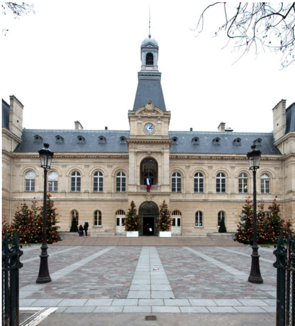
Partie centrale de la façade principale
