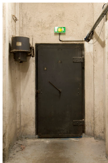
vue de la porte blindée fermée du soubassement. Phot. Laurent Kruszyk IVR11_20157500173NUC4A
