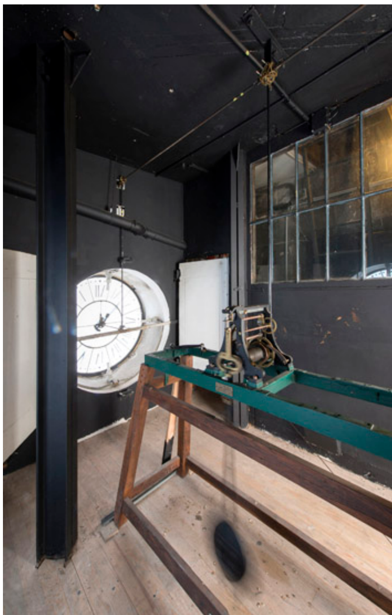
vue du balancier et de l'horloge du campanile.
