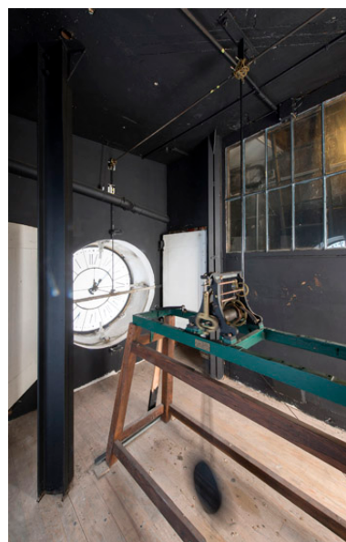
vue du balancier et de l'horloge du campanile. Phot. Laurent Kruszyk IVR11_20157500259NUC4A
