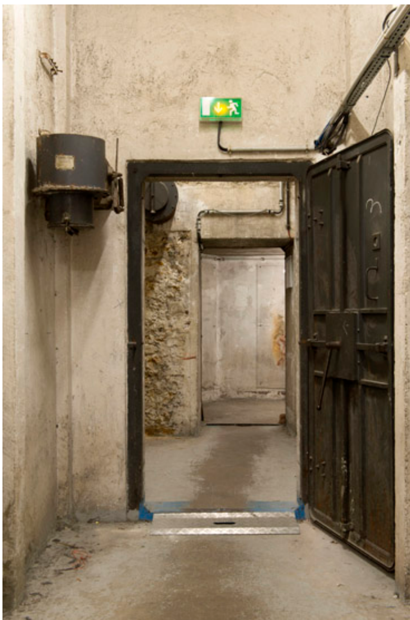
vue d'une porte blindée du soubassement.
