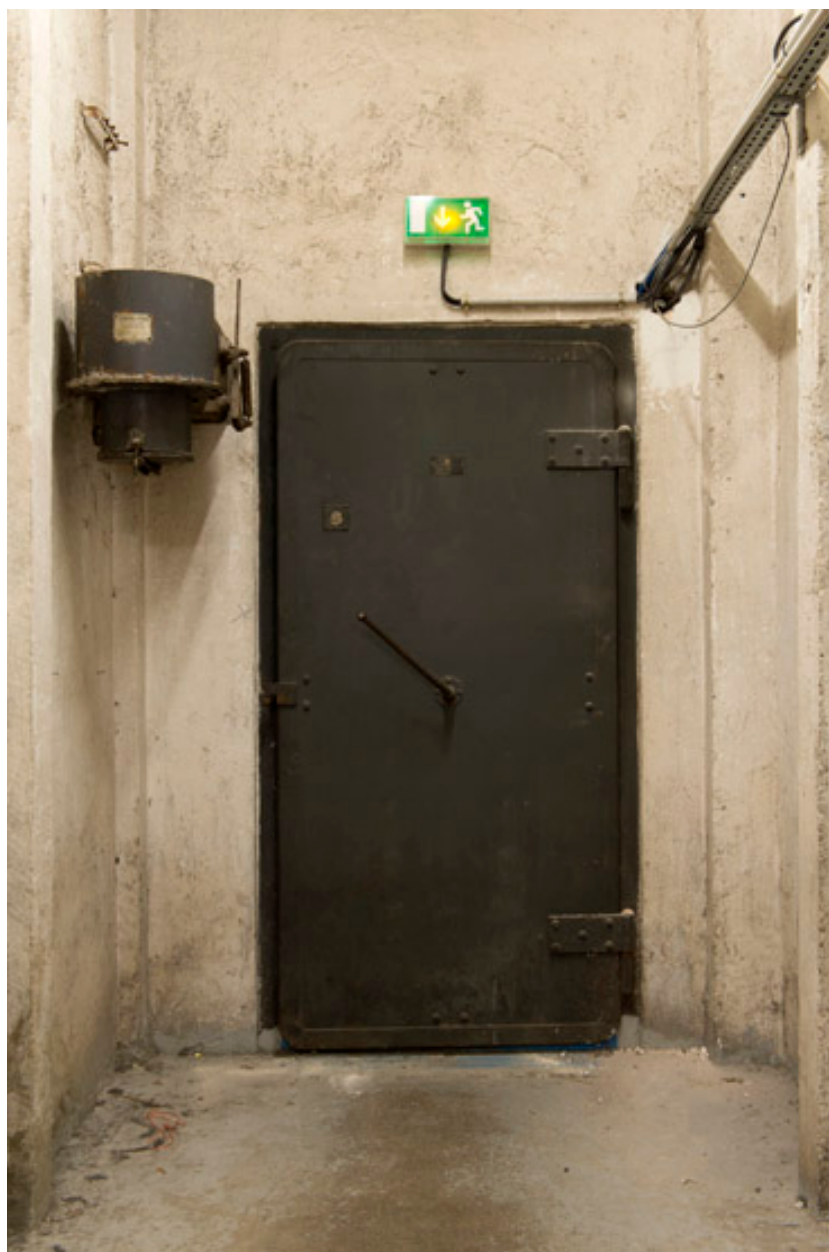
vue de la porte blindée fermée du soubassement.
