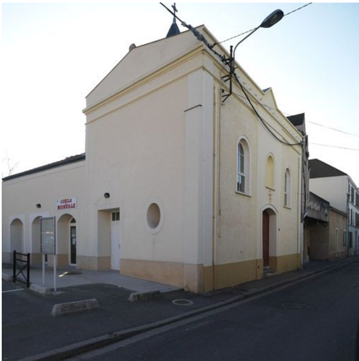
Vue des façades principale et latérale est.
