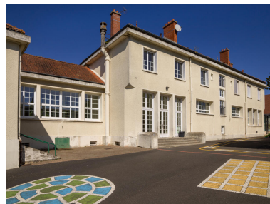
Vue générale de la façade sur cour de l'école maternelle Jean de La Fontaine depuis le sud-ouest. Phot. Asseline Stéphane IVR11_20259101060NUC4A
