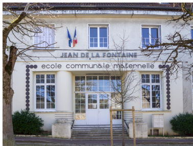
Vue de la partie centrale de la façade sur le boulevard. Phot. Asseline Stéphane IVR11_20269100074NUC4A
