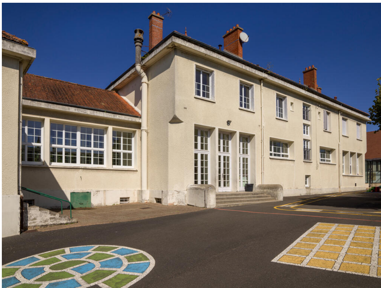
Vue générale de la façade sur cour de l'école maternelle Jean de La Fontaine depuis le sud-ouest.
