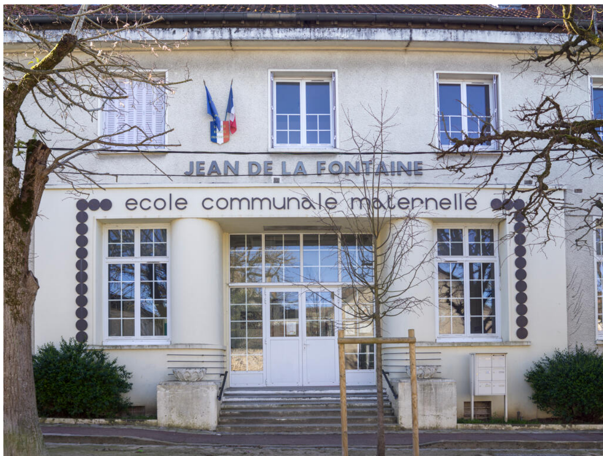
Vue de la partie centrale de la façade sur le boulevard.
