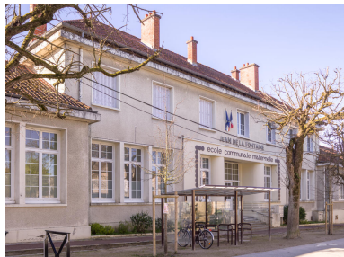
Vue générale de la façade sur le boulevard, depuis le nord-est. Phot. Asseline Stéphane IVR11_20269100073NUC4A
