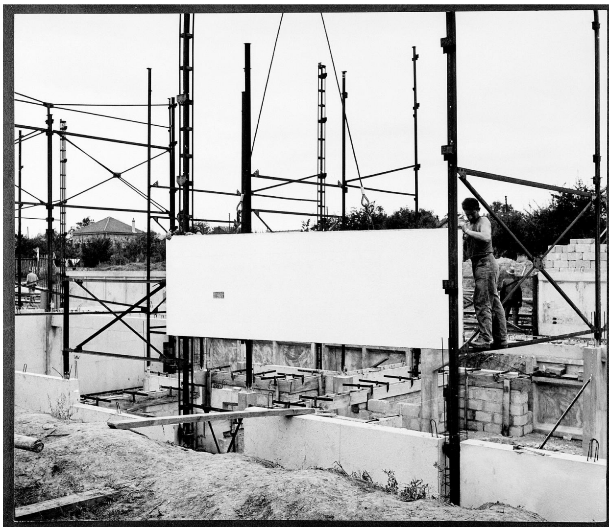
Installation d'éléments préfabriqués sur armature de métal, 1959.
