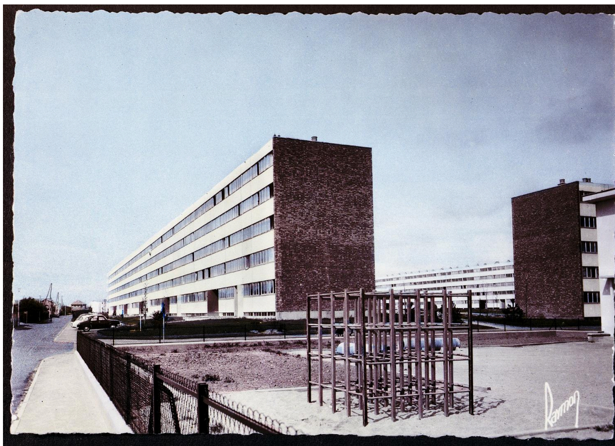
Vue d'une partie des bâtiments, à l'arrière de la rue du Plein Midi.
