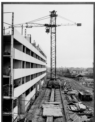
Construction des immeubles, chemin de grue, janvier 1959. IVR11_20019100740NUCB
