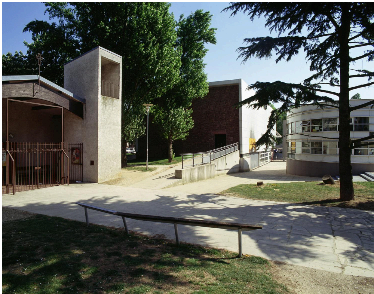
La façade antérieure de la chapelle, le mur nord du Centre Michelet et la Maison du Citoyen.
