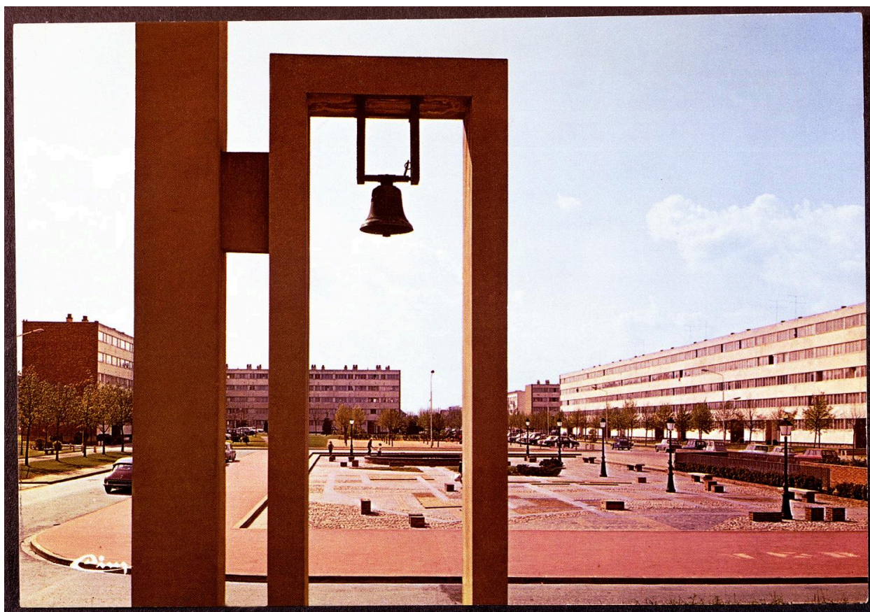
La place des Quatre Voyes derrière le clocher de l'église.
