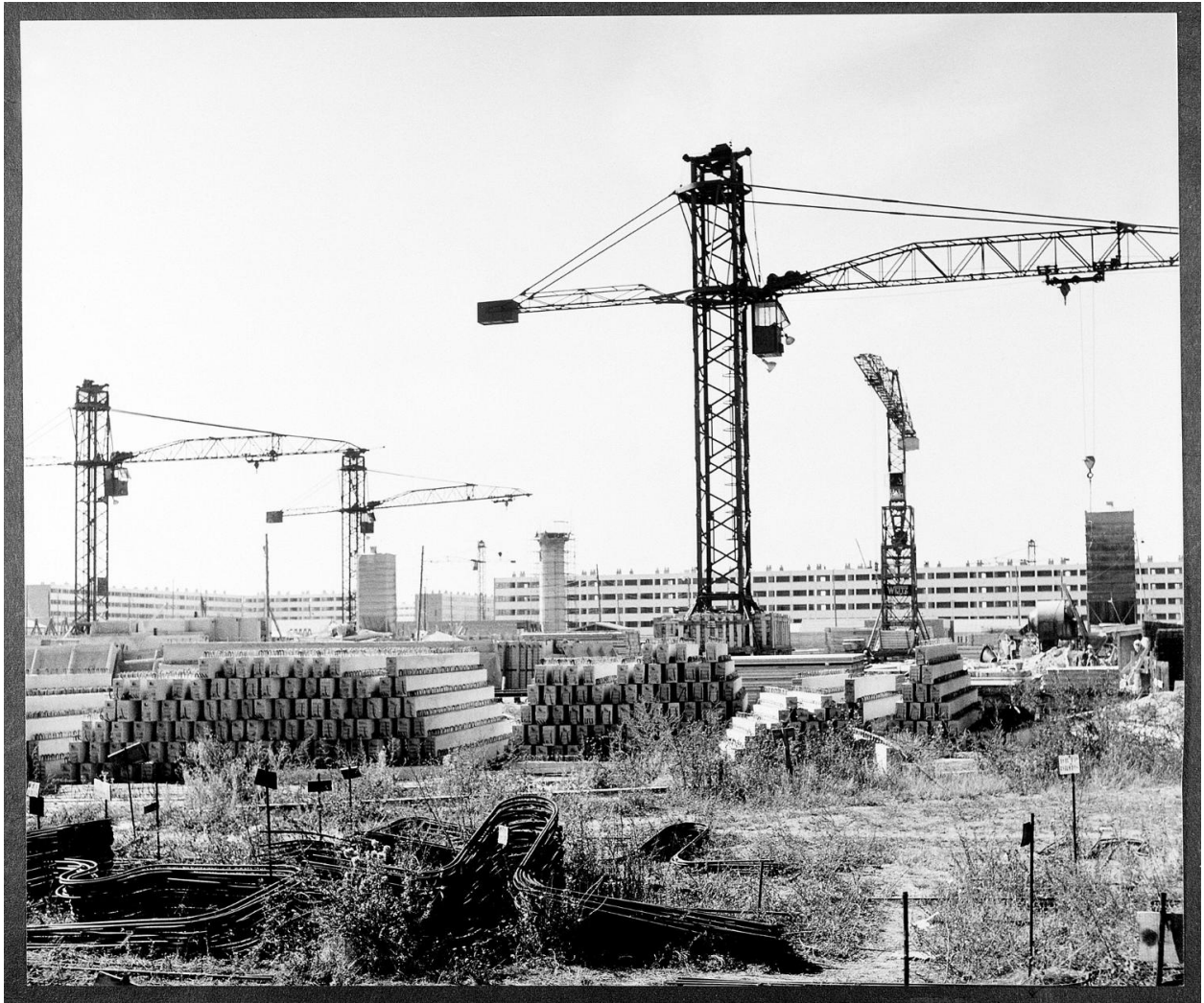
Construction de la Cité vers le centre commercial. Octobre 1959.
