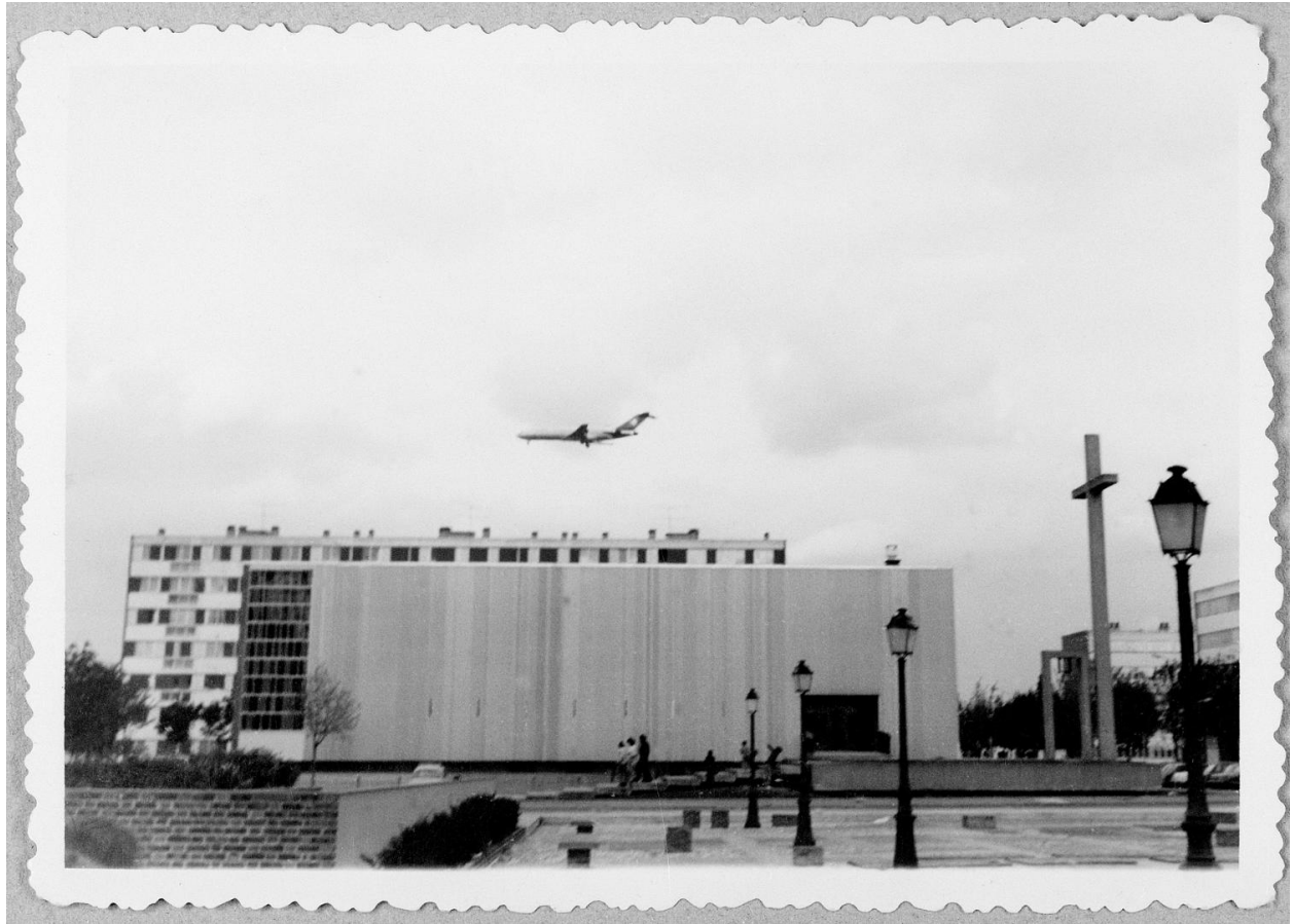
Un avion au-dessus de l'église des 3F. Vers 1975.
