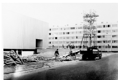
Construction de l'église et de la croix, place des Quatre Voyes. Juillet 1962. IVR11_20019100751NUCB
