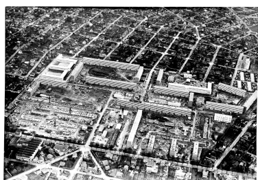
Vue aérienne de la Cité, du nord vers le sud ; au premier plan, l'avenue de Morangis. 19 janvier 1960. IVR11_20019100744NUCB
