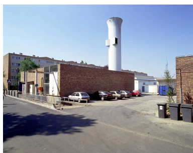
Vue de la chaufferie, située près du supermarché. Phot. Philippe Ayrault IVR11_20039100655XA
