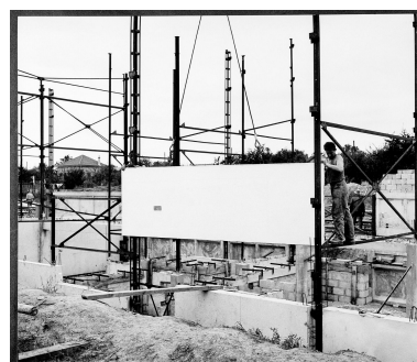
Installation d'éléments préfabriqués sur armature de métal, 1959. IVR11_20019100741NUCB
