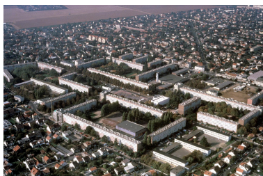
Vue aérienne. IVR11_20049100454NUCAB
