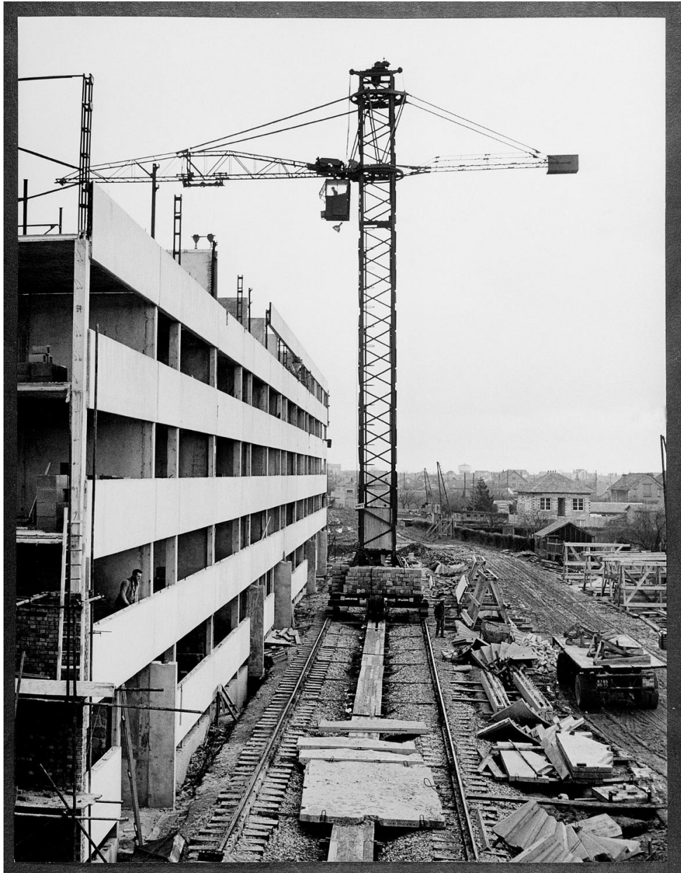
Construction des immeubles, chemin de grue, janvier 1959.
