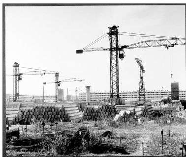
Construction de la Cité vers le centre commercial. Octobre 1959. IVR11_20019100755NUCB
