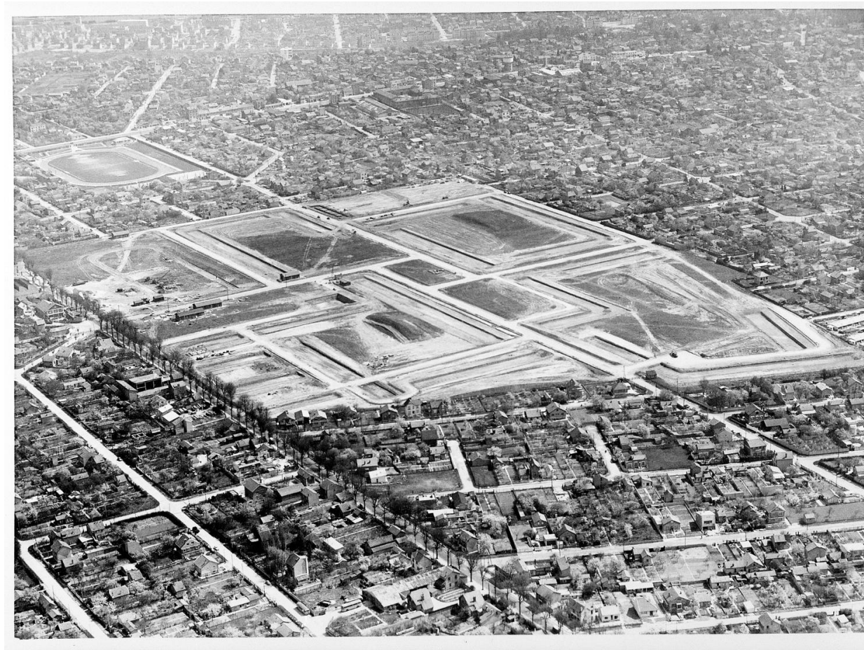
Vue aérienne nord-ouest sud-est ; les terrains sont encore nus ; au premier plan, l'avenue de Morangis ; au fond, la RN 7. Avril 1958.
