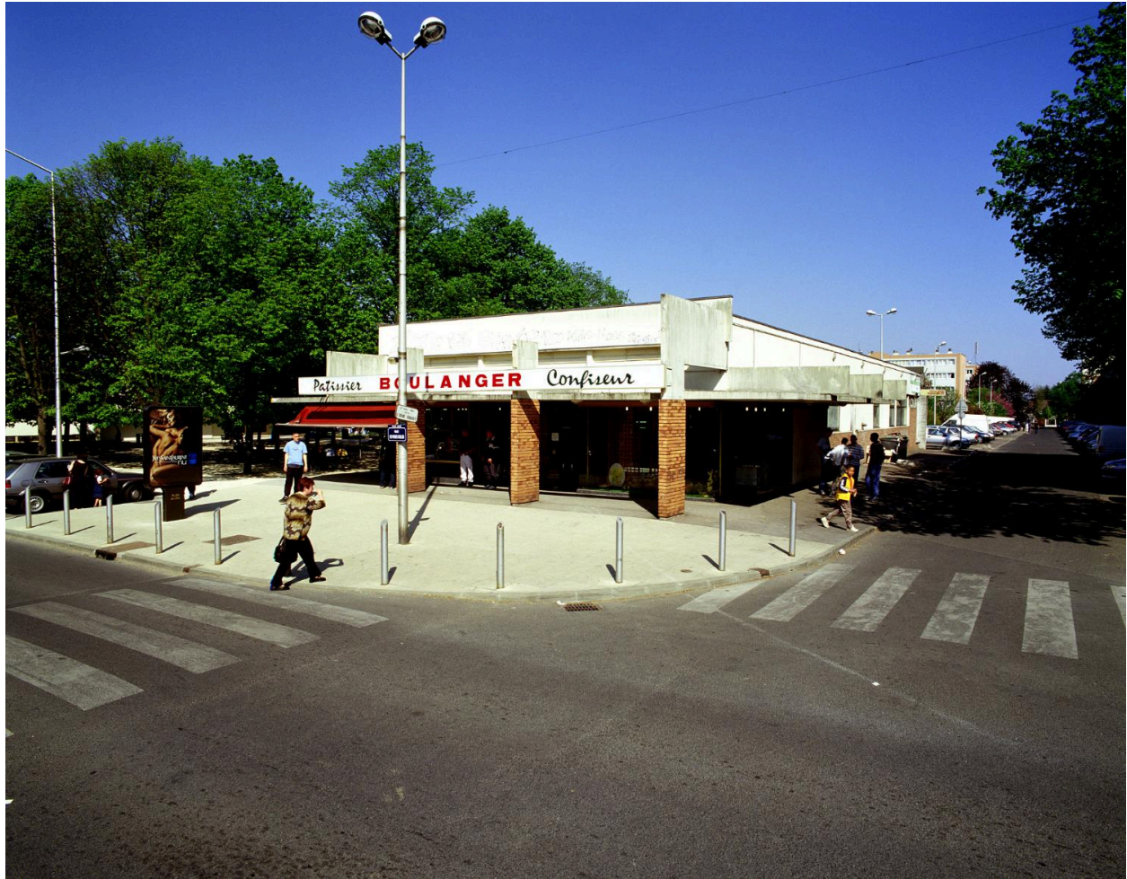
Vue du centre commercial situé à l'angle des rues des Froides-Bouillies et de l'Orme-Robinet.
