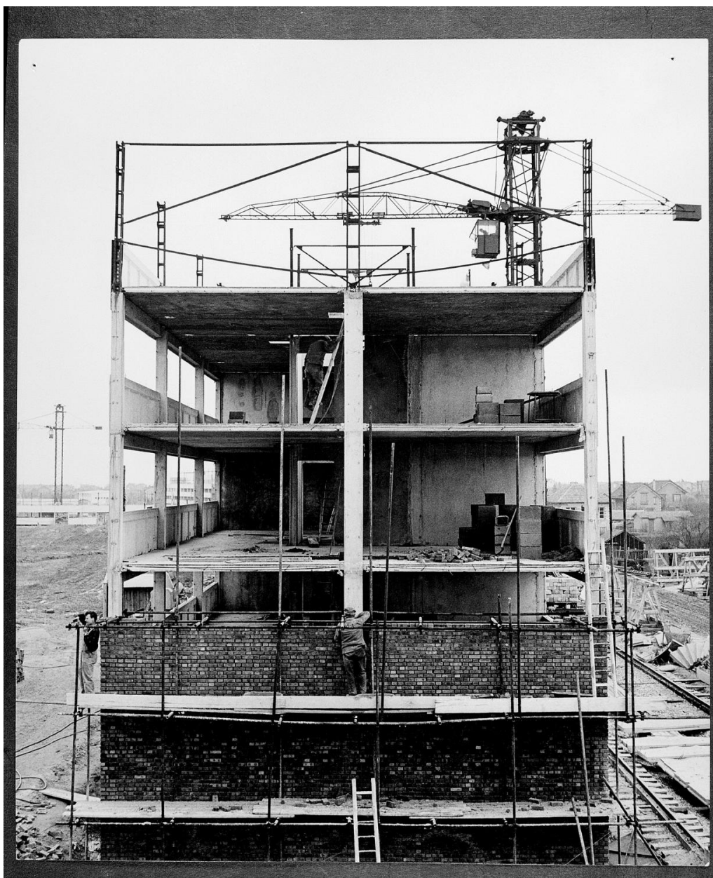
Montage du pignon d'un immeuble en briques.
