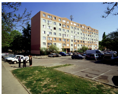
Vue d'ensemble de l'immeuble de six étages (immeuble U du programme 1962-1964) situé à l'arrière de l'église et du Centre Michelet. Phot. Philippe Ayrault IVR11_20039100663XA
