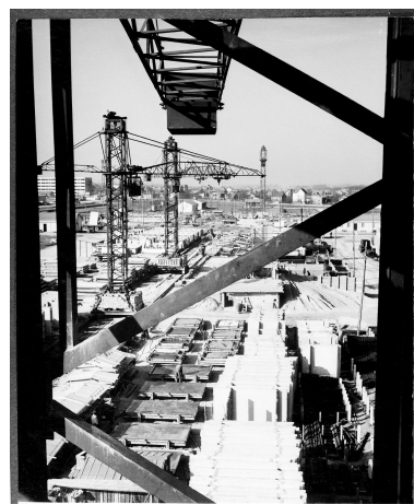
Gros plan de l'aire de préfabrication. 6 mai 1959. IVR11_20019100757NUCB
