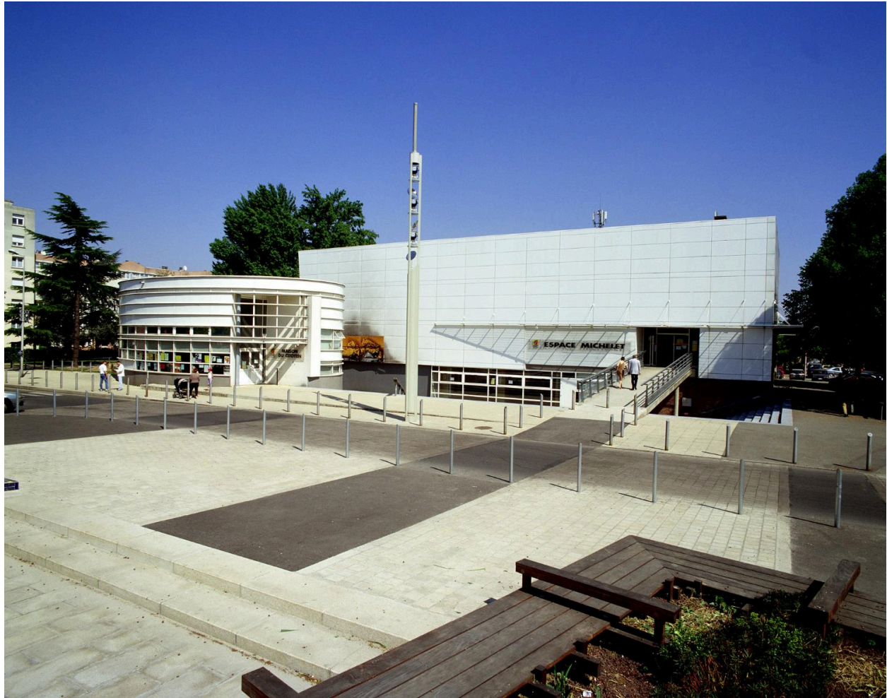
Vue de l'Espace Michelet (ancienne église Notre-Dame-de-l'Air) et de la Maison du Citoyen à l'extrémité de la place Mendès-France.
