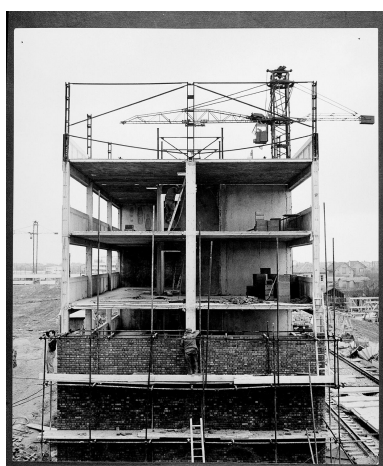
Montage du pignon d'un immeuble en briques. IVR11_20019100756NUCB
