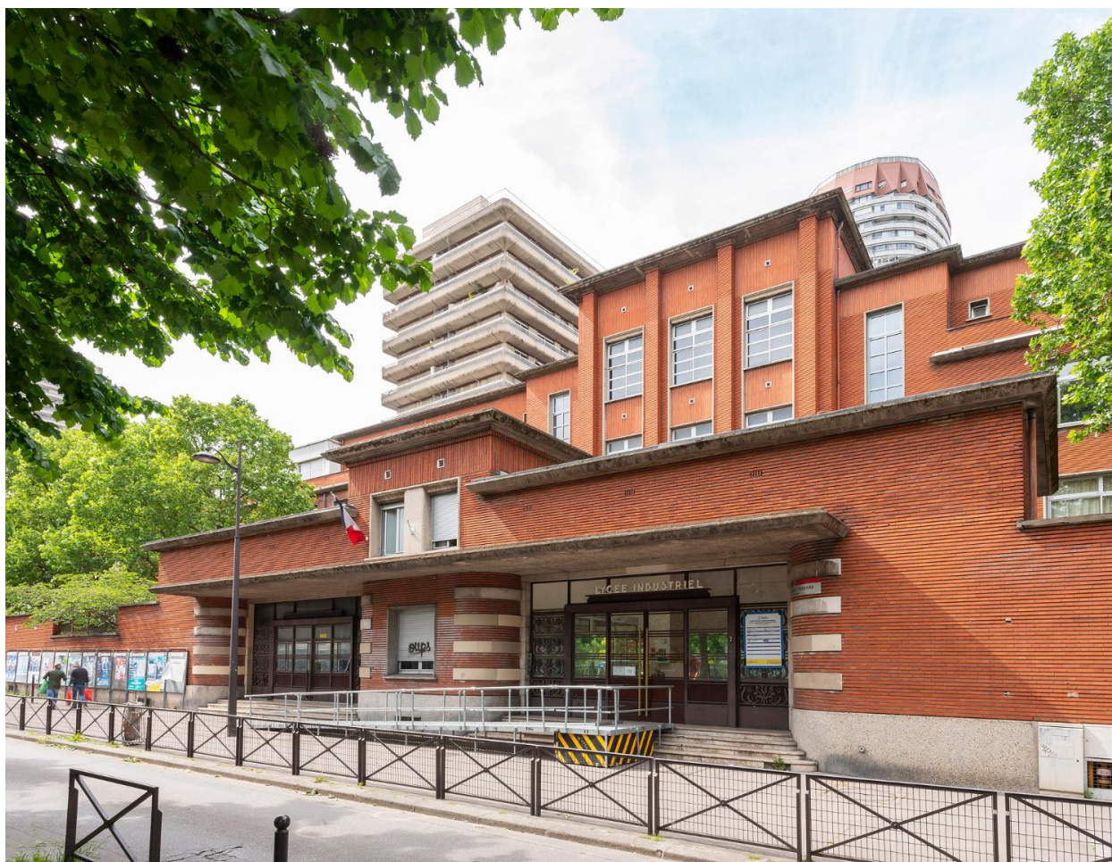
Vue générale du lycée.
