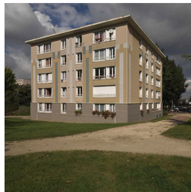
La cité des Bergeries à Vigneux-sur-Seine : façade postérieure d'un immeuble R + 4 (n° 12).
