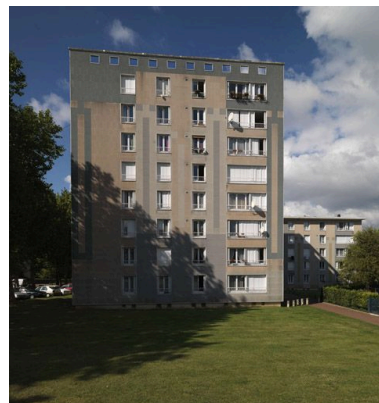
Une façade de l'immeuble n° 29 (R + 7), près de l'allée des Ecoles. Phot. Philippe IVR11_20089100018NUC4A
