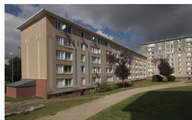
La cité des Bergeries à Draveil : immeuble composé de deux bâtiments en équerre, 1-7 et 42-48, allée des Bergeries. Phot. Philippe IVR11_20089100029NUC4A
