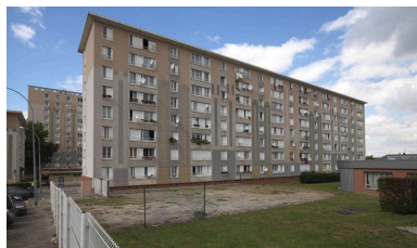
La cité des Bergeries à Vigneux-sur-Seine : immeuble-barre, 1-7, rue des Deux communes, à côté de l'école Louise-Michel.
