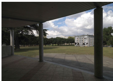
La cité des Bergeries à Draveil : la galerie du centre social ouvrant sur le parc traversé par un mail planté ; au centre, immeuble n°4.
