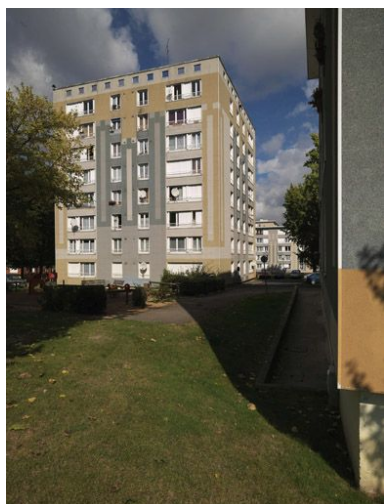
La cité des Bergeries à Draveil : vue d'ensemble de l'immeuble n° 11 (R + 7), le long de l'allée des Deux communes ; à l'extrême droite, immeuble n° 13. Phot. Philippe IVR11_20089100019NUC4A
