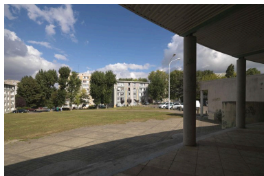
La cité des Bergeries à Draveil : de la galerie du centre social, vue sur le grand espace libre bordé par les trois immeubles situés de part et d'autre de l'allée des Deux communes (de gauche à droite, n° 4, 11 et 13).
