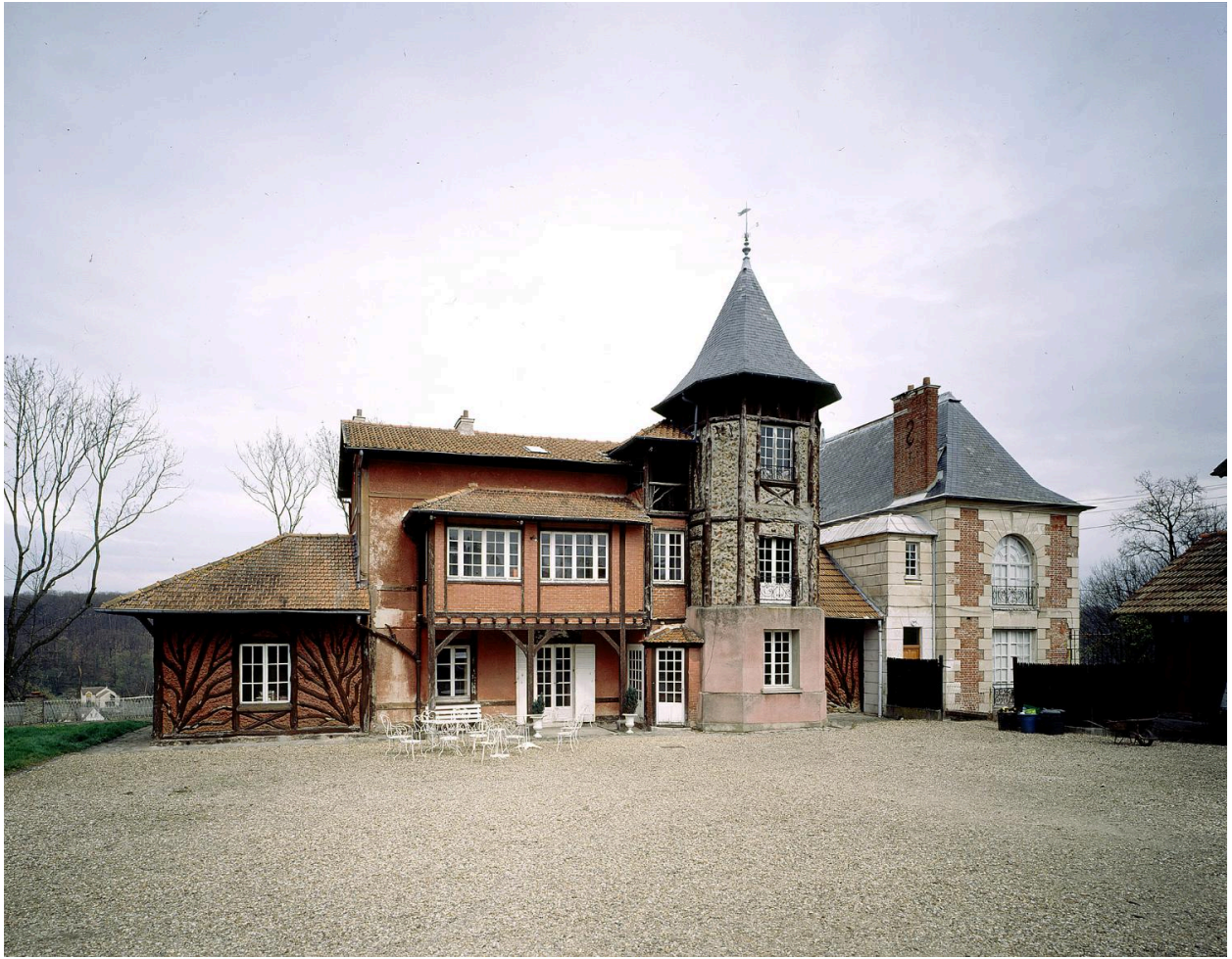
Vue de la façade sur jardin.
