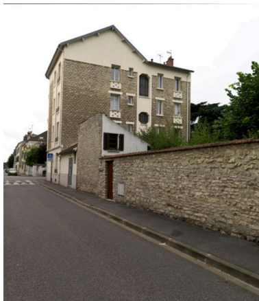
Vue de la façade arrière. Phot. Laurent Kruszyk IVR11_20167800399NUC4A
