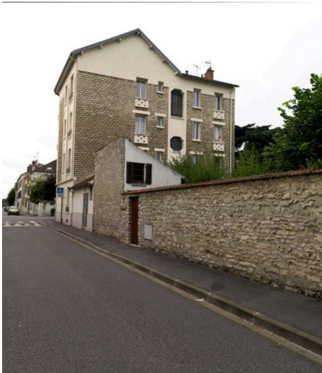
Vue de la façade arrière.
