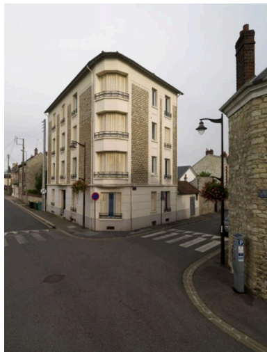
Vue de la façade principale. Phot. Laurent Kruszyk IVR11_20167800397NUC4A
