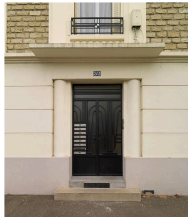
Détail de la porte. Phot. Laurent Kruszyk IVR11_20167800398NUC4A
