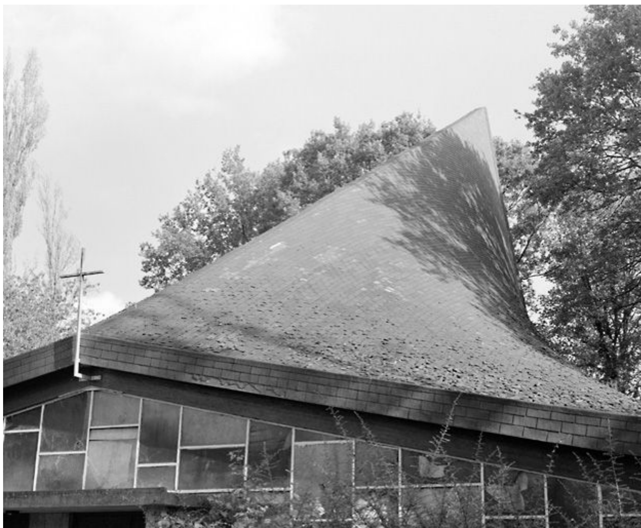
Vue du toit et de la flèche côté sud.
