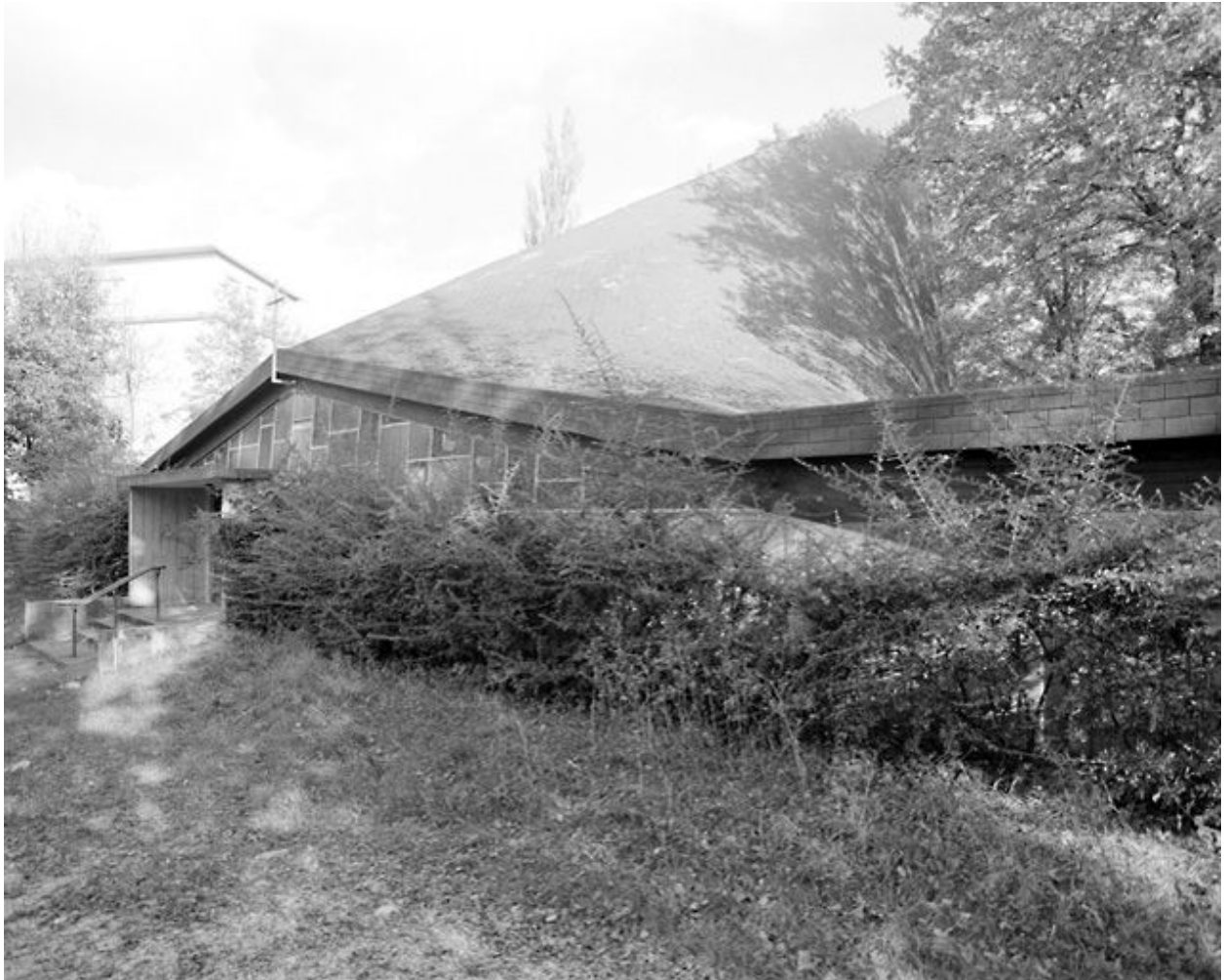
Vue de la chapelle côté sud.
