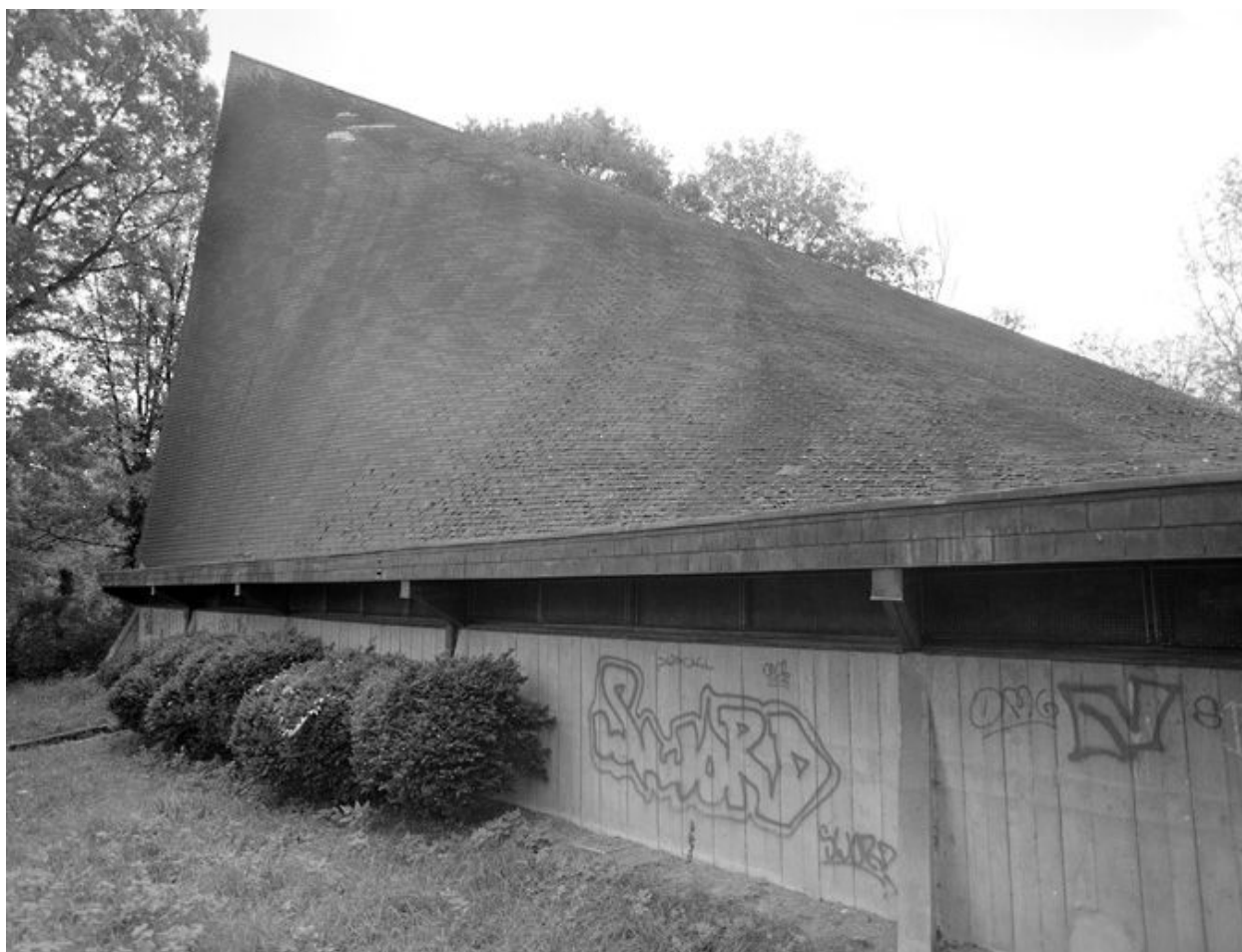
Vue de la façade nord.
