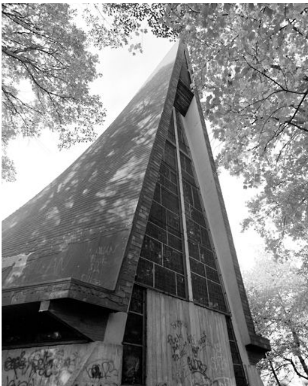
Vue de la baie du chevet.
