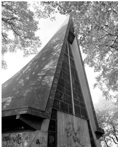
Vue de la baie du chevet. Phot. Philippe Ayrault IVR11_20019100635X
