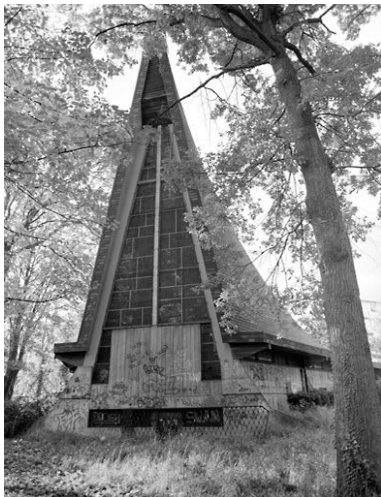
Vue de la façade postérieure. Phot. Philippe Ayrault IVR11_20019100638X
