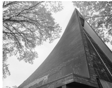
Vue de la flèche côté sud-est. Phot. Philippe Ayrault IVR11_20019100639X
