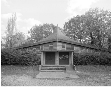
Vue de la façade principale et de l'entrée. La flèche dirigée vers l'est évoque la voile d'une nef. Phot. Philippe Ayrault IVR11_20019100634X
