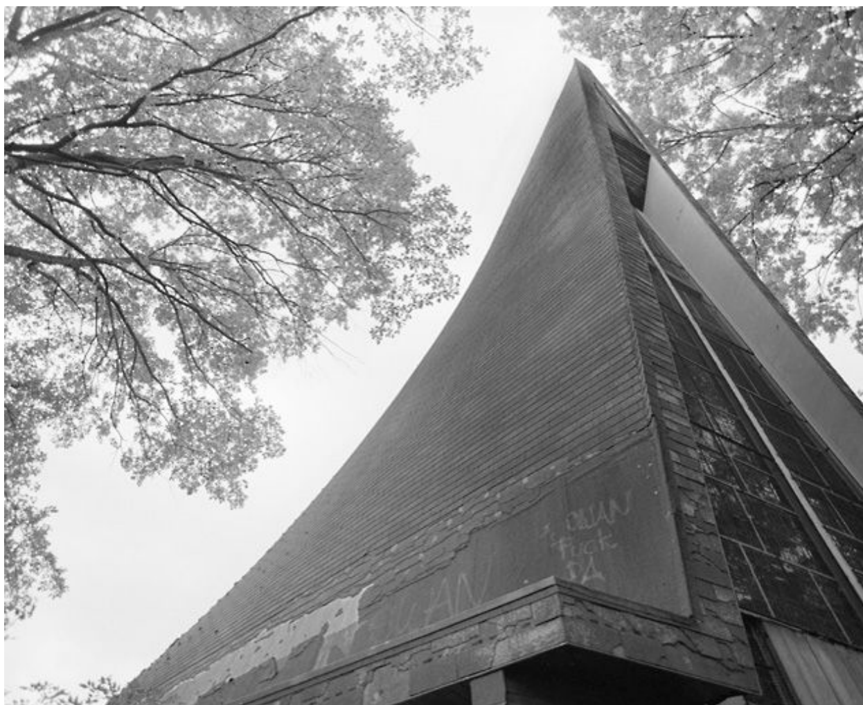
Vue de la flèche côté sud-est.
