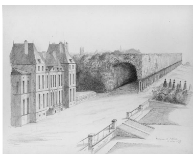
La terrasse du château ; à droite, l'allée de tilleuls taillés en table créée par la comtesse de Charolais. IVR11_20029100252X
