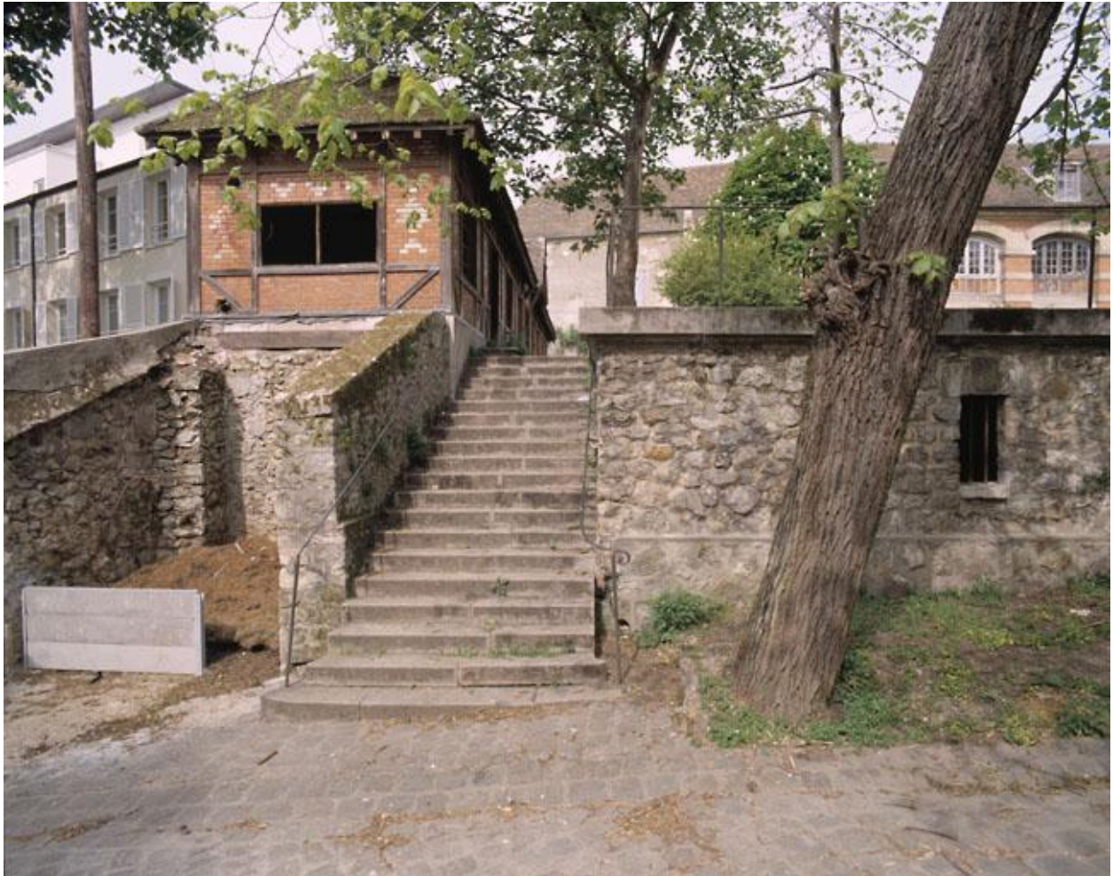
Escalier et mur de soutènement de la cour des communs ; au fond à droite, l'orangerie ; l'escalier descend vers l'ancien potager.
