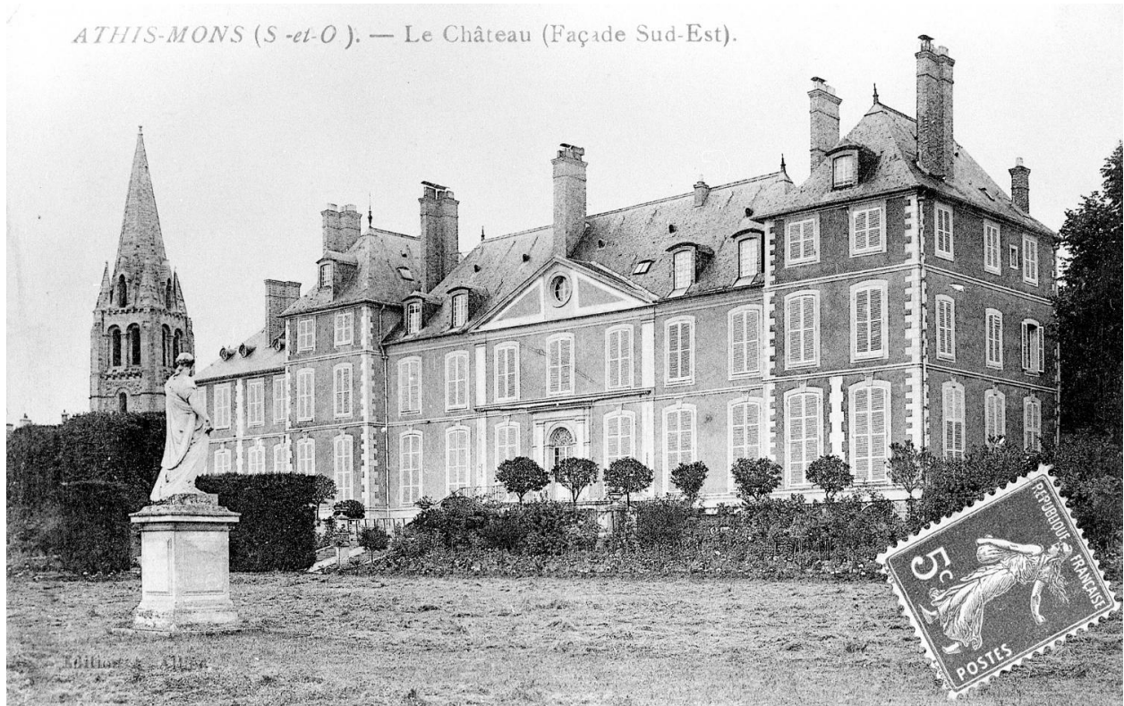
Façade sur le parc.
