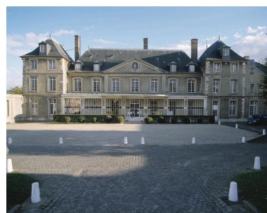
Vue d'ensemble de la façade sur la cour d'honneur ; la véranda qui couvre le rez-de-chaussée du corps central a été mise en place au début du 20e siècle.
