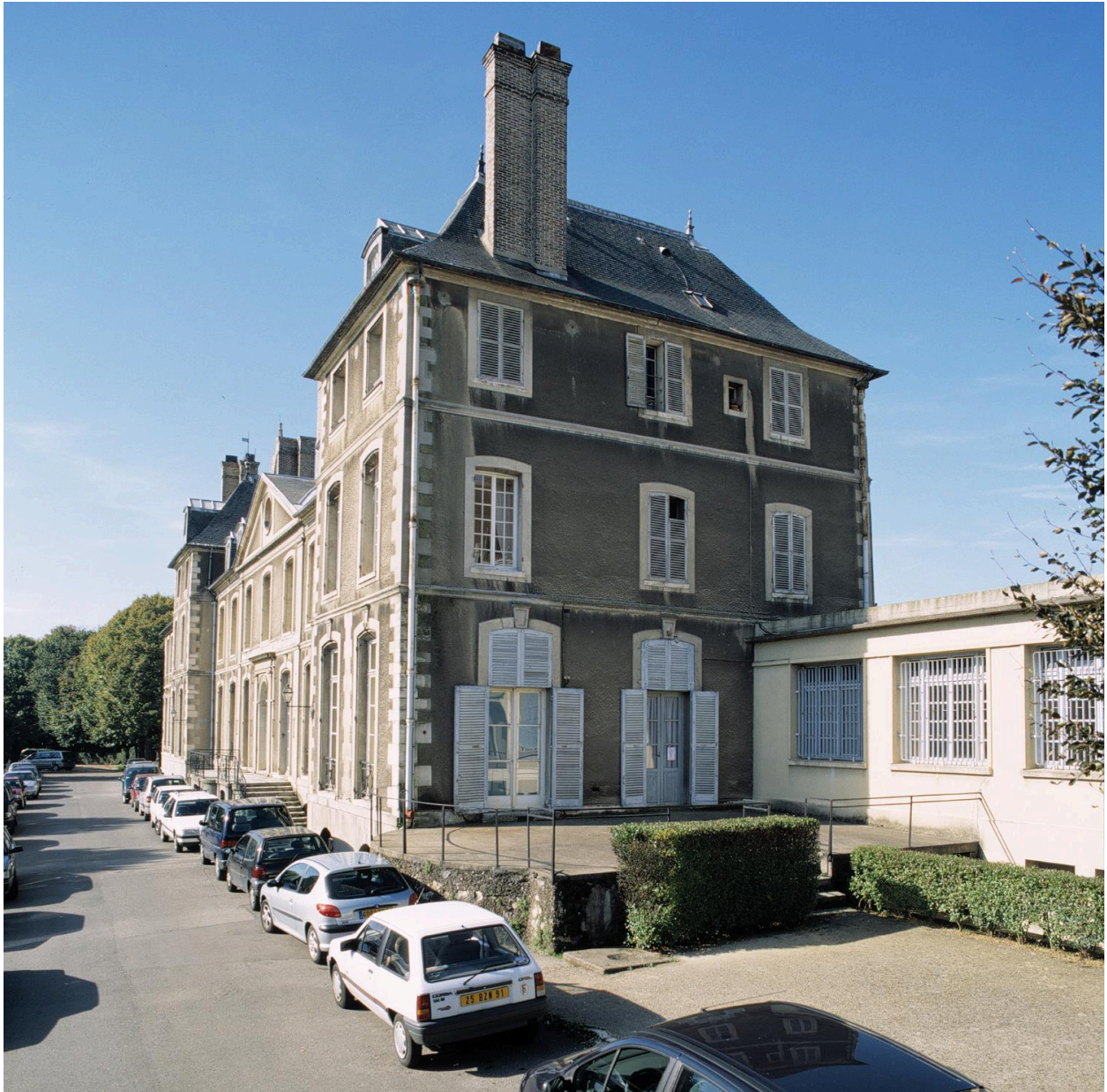
Vue latérale du château, côté parc.
