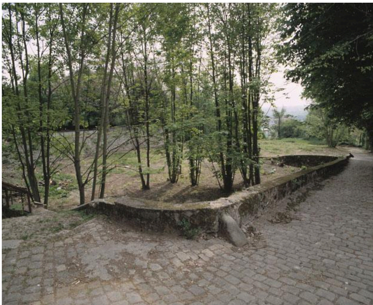
L'ancien potager avec au pied de la rampe un réservoir en hémicycle protégé par des murs de soutènement.
