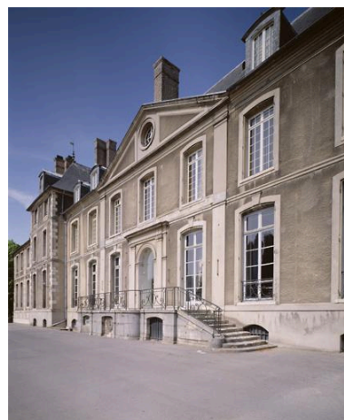
Le château : vue de l'escalier extérieur sur la façade arrière ; il ne possède qu'une volée.
