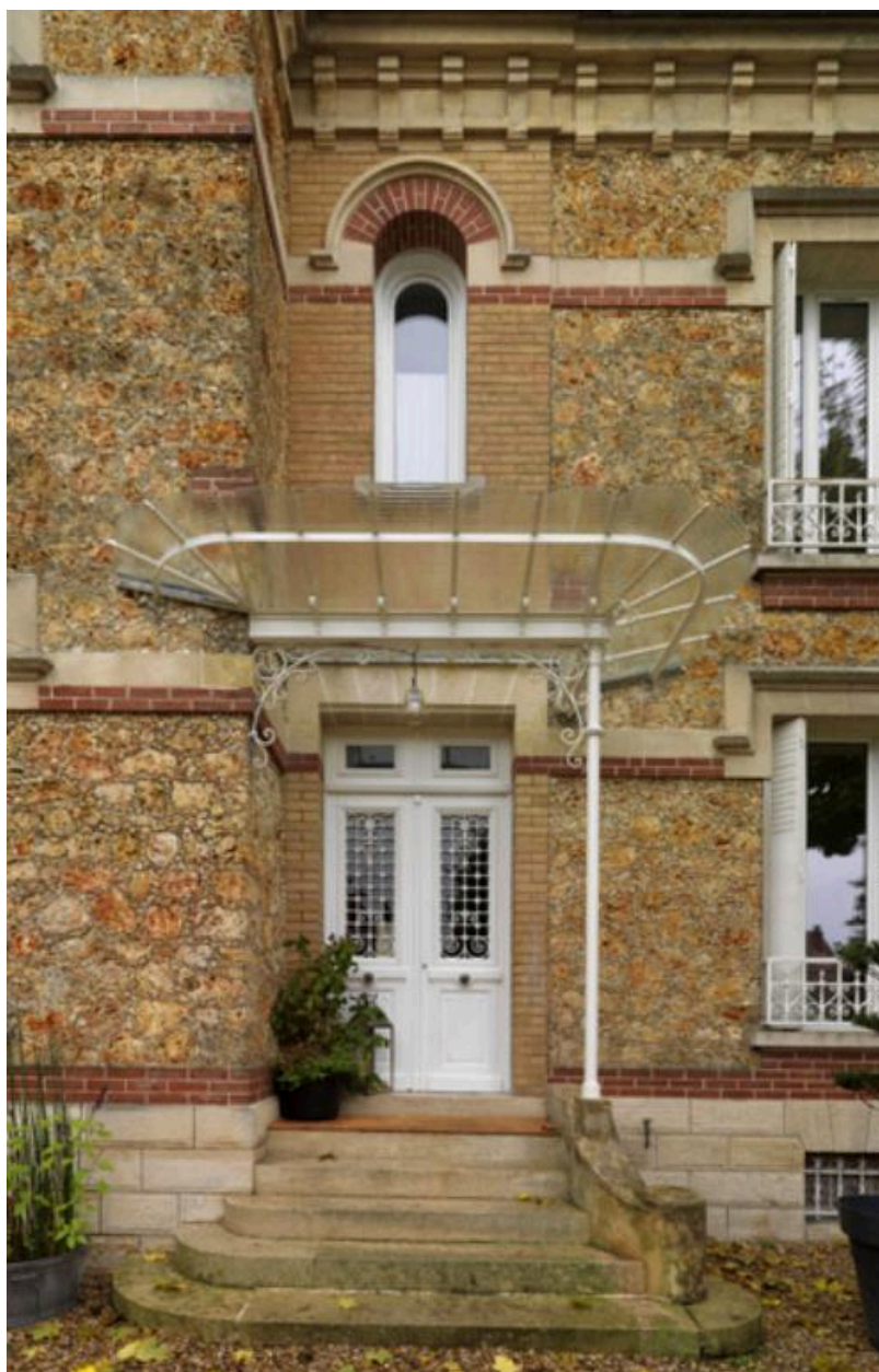
Vue de détail de la marquise d'entrée
