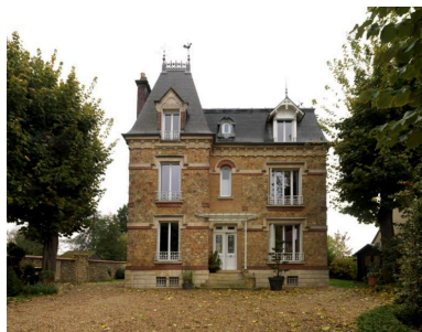
Façade principale sur rue. Phot. Laurent Kruszyk IVR11_20167800667NUC4A
