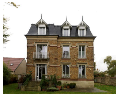
Façade arrière sur jardin Phot. Laurent Kruszyk IVR11_20167800669NUC4A
