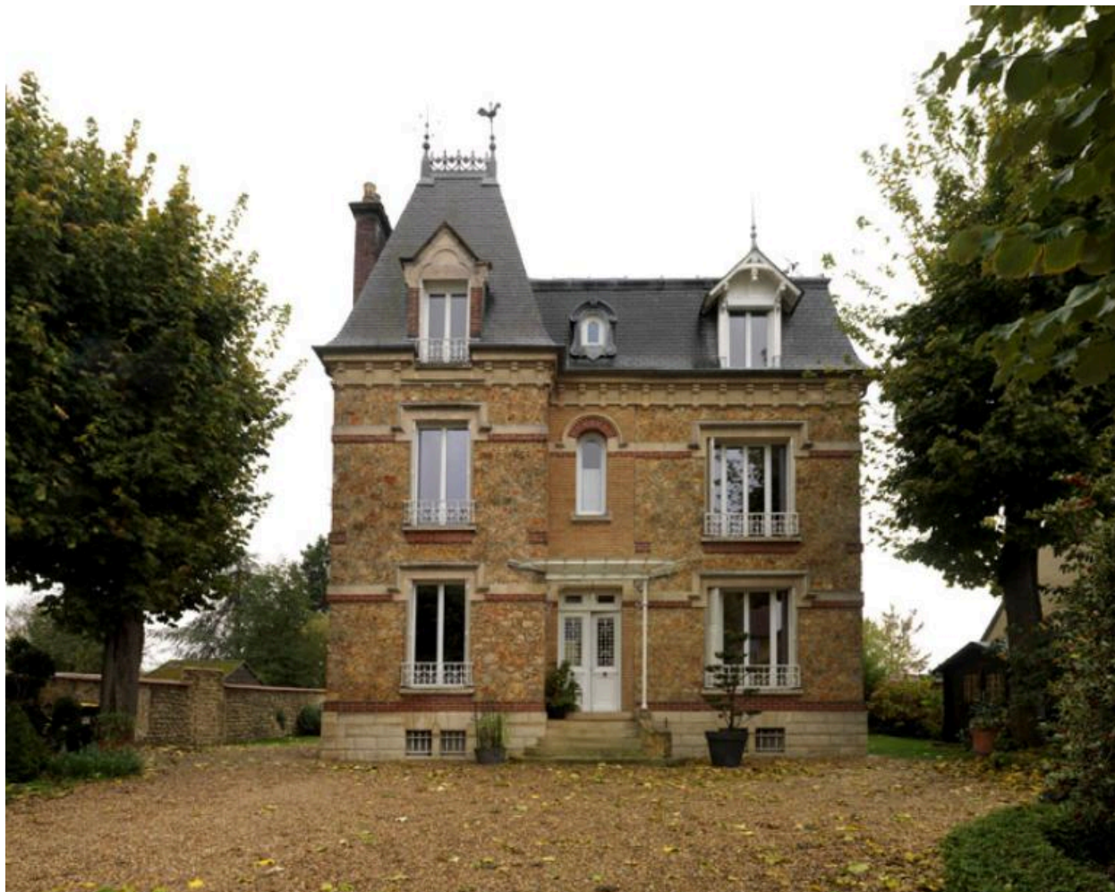
Façade principale sur rue.
