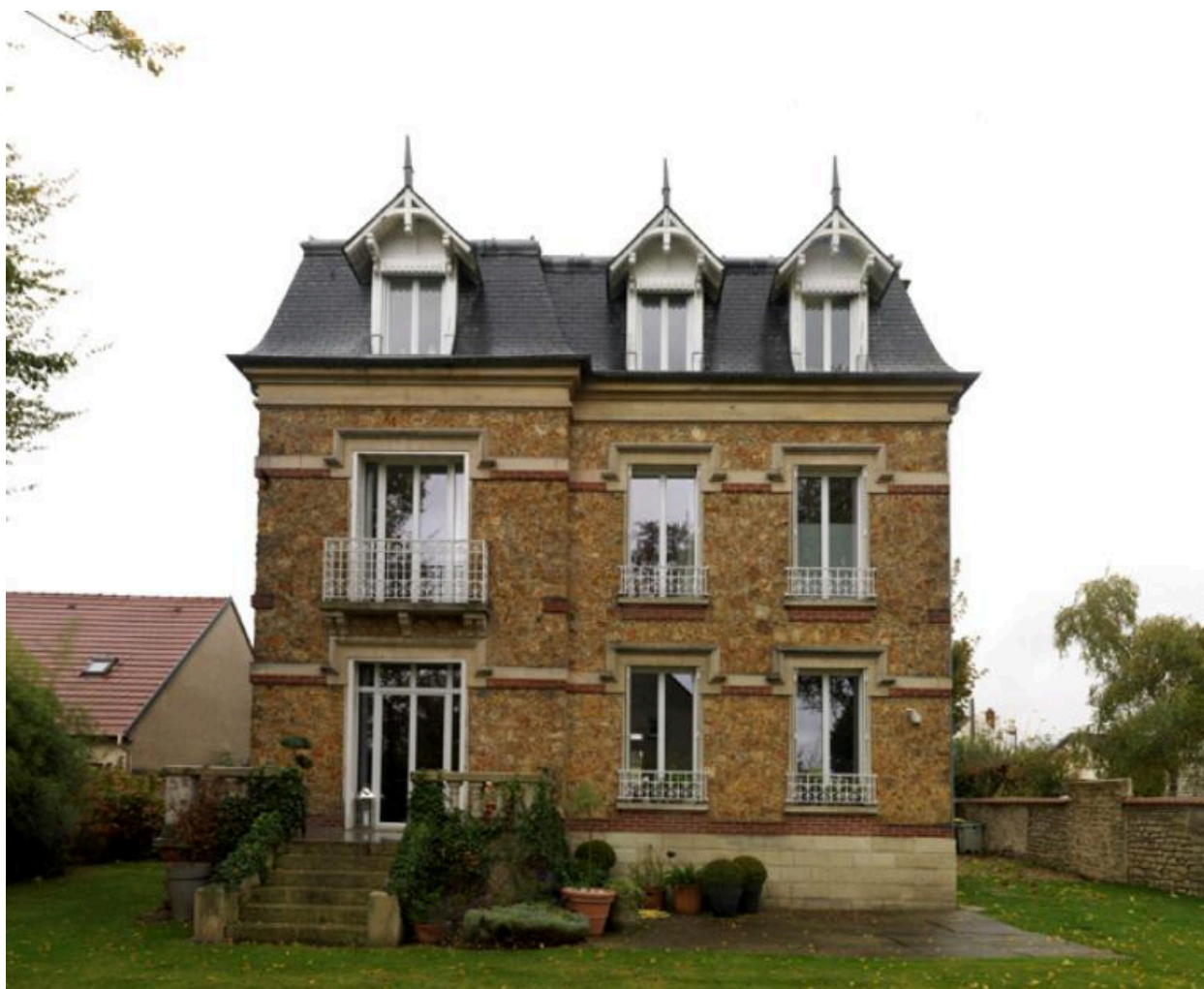
Façade arrière sur jardin
