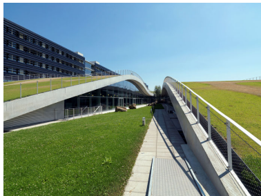
Vue sud-ouest. Phot. Jean-Bernard Vialles IVR11_20157700038NUC4A
