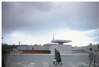
Vue depuis la rue du Pierris. Au premier plan, au centre le conduit d'évacuation de la chaudière qui prend la forme d'un promontoire, à droite on distingue le mécanisme de la cloche. Au second plan, le lanterneau originel aujourd'hui remplacé par un modeste pyramidion. Photographie ancienne, circa 1968. (Collection particulière) Autr. Louis Rémy Sabattier, Phot. Jean-Bernard Vialles IVR11_20127700178NUC1A
