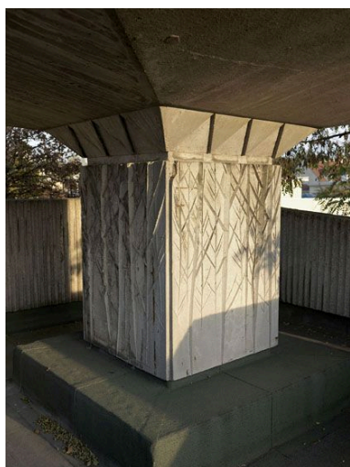
Vue du toit-terrasse. Détail du béton architectonique du conduit d'évacuation de la chaudière. Phot. Jean-Bernard Vialles IVR11_20117701043NUC4A
