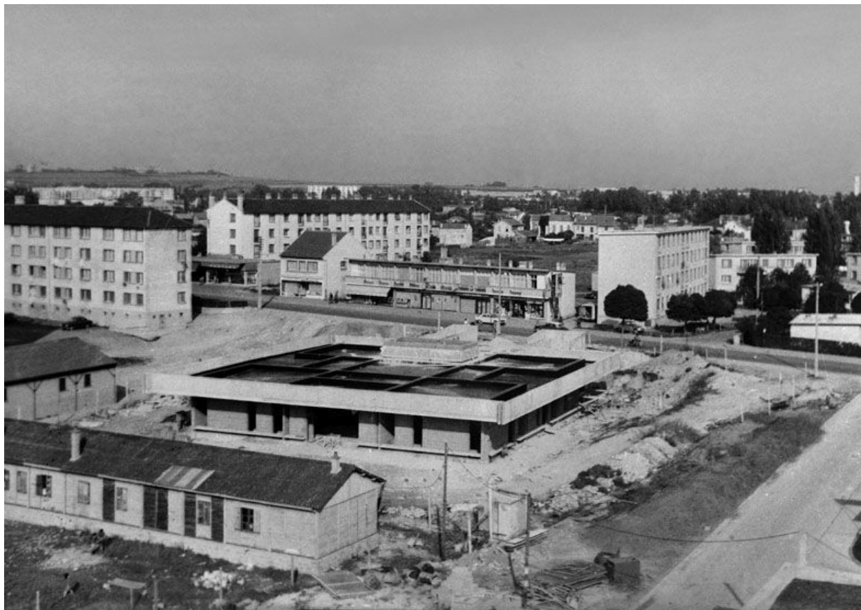
Vue d'ensemble depuis le sud-ouest lors du chantier de construction. Photographie ancienne, circa 1968. (Collection particulière)
