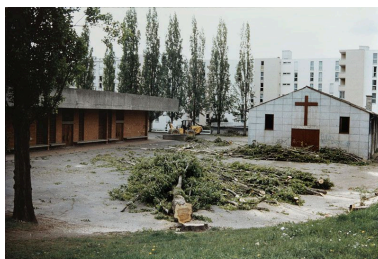
Vue depuis le nord-est lors de l'abattage des peupliers. A droite, la chapelle provisoire détruite au milieu des années 2000.
