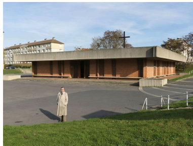
Vue d'ensemble depuis le sud-ouest, au premier plan l'architecte Michel Marot. Phot. Jean-Bernard Vialles IVR11_20117701037NUC4A
