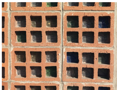
Depuis l'extérieur, détail des claustras garnis de verre coloré. Phot. Jean-Bernard Vialles IVR11_20117701046NUC4A
