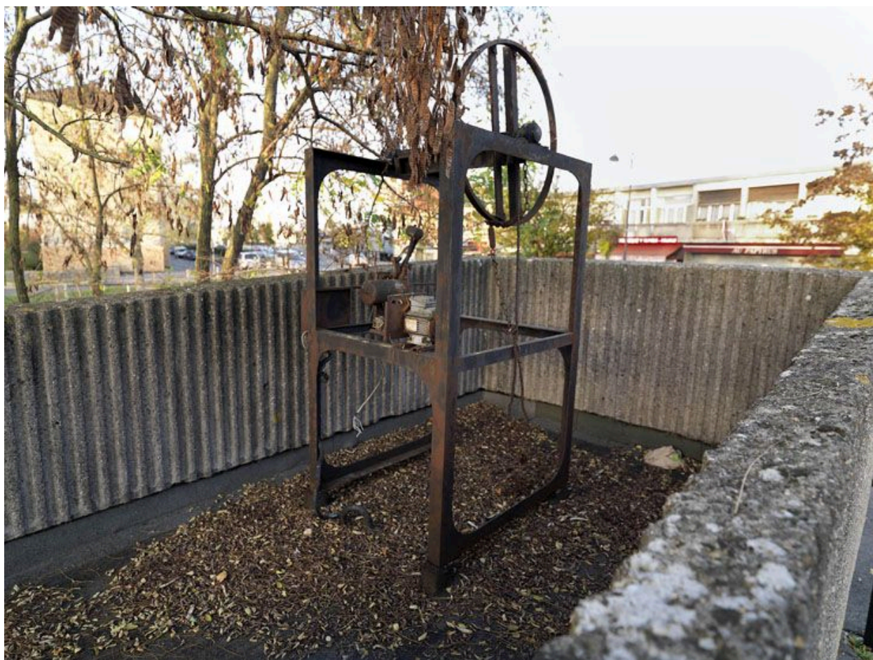
Vue du toit-terrasse vers le nord-est. Ancien mécanisme destiné à accueillir une cloche amenée par les rapatriés d'Algérie. Cette dernière est aujourd'hui conservée dans les réserves de l'église.
