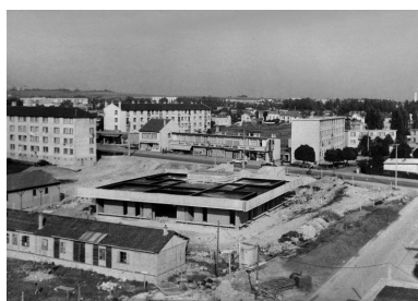
Vue d'ensemble depuis le sud-ouest lors du chantier de construction.
