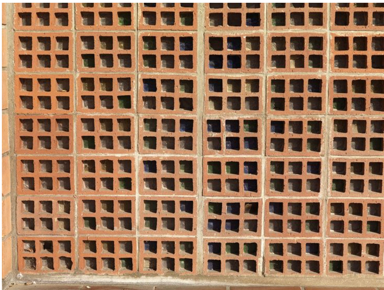
Depuis l'extérieur, vue rapprochée de façade en briques à claustras garnis de verre coloré.
