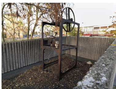
Vue du toit-terrasse vers le nord-est. Ancien mécanisme destiné à accueillir une cloche amenée par les rapatriés d'Algérie. Cette dernière est aujourd'hui conservée dans les réserves de l'église. Phot. Jean-Bernard Vialles IVR11_20117701044NUC4A
