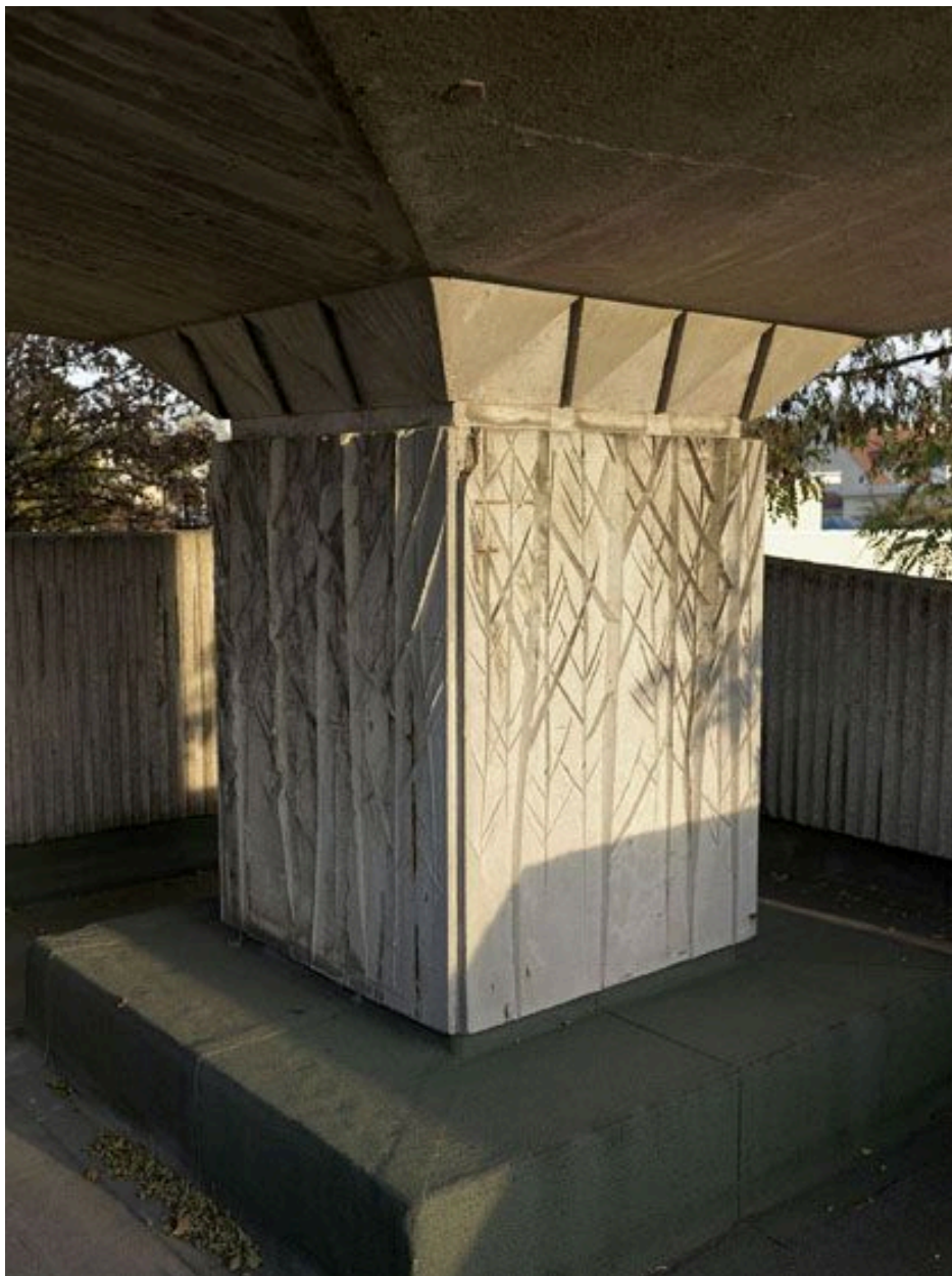
Vue du toit-terrasse. Détail du béton architectonique du conduit d'évacuation de la chaudière.
