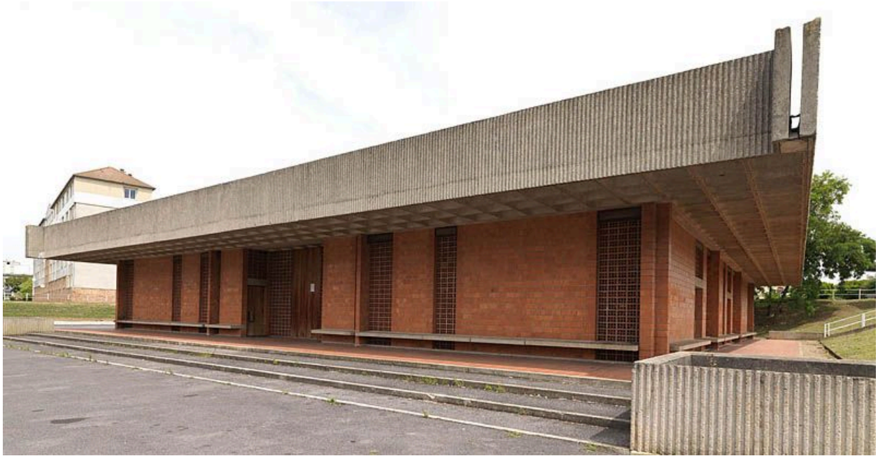
Façade ouest depuis le sud-ouest.
