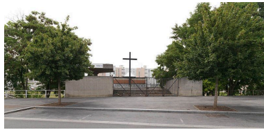
Vue (nord-est) depuis l'avenue Henri Dunant. Phot. Stéphane Asseline IVR11_20097701093NUC4A
