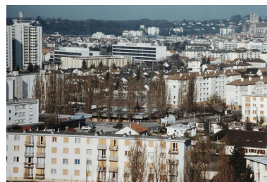
Vue d'ensemble depuis le sud-est avant l'abattage des peupliers. Le lanterneau élané originel constituait le signal visuel de l'édifice. Il fut remplacé par un pyramidon de plus petite dimension au milieu des années 2000. Photographie ancienne, mars 1991. (Collection particulière)
