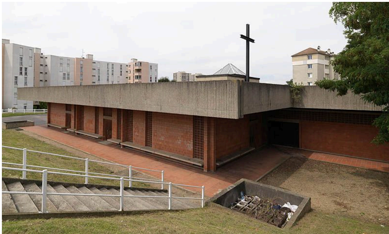
Façade sud depuis le sud-est.
