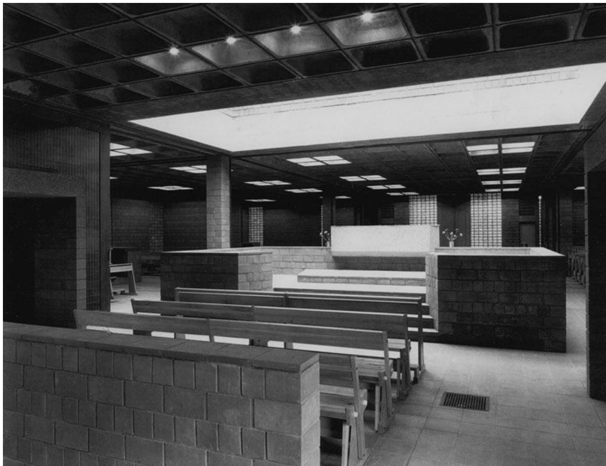
Vue du maître-autel originel depuis la chapelle de la semaine. Photographie ancienne, circa 1968. (Collection particulière)
