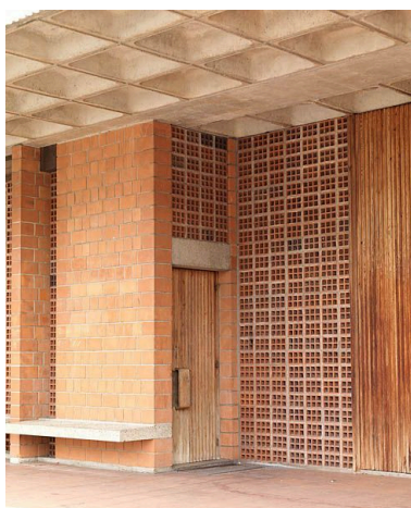
Façade ouest. Entrée principale, porte latérale gauche. Phot. Stéphane Asseline IVR11_20097701091NUC4A
