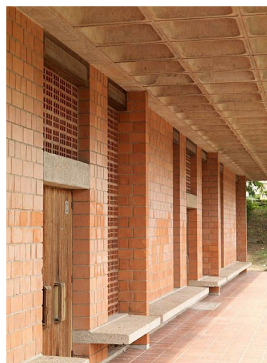
Façade ouest. Phot. Stéphane Asseline
