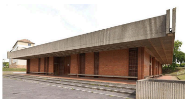
Façade ouest depuis le sud-ouest. Phot. Stéphane Asseline IVR11_20097701088NUC4A
