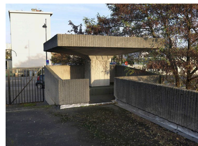
Vue du toit-terrasse vers l'est. Conduit d'évacuation de la chaudière autour duquel prend place un banc. Cette aménagement fut réalisé dans le dessein d'un toit-terrasse traité en jardin. Phot. Jean-Bernard Vialles IVR11_20117701042NUC4A
