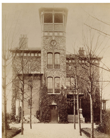
Façade antérieure. Photographie, fin 19e siècle. (Institut français d'architecture, Fonds Friesé) Phot. Jean-Bernard Vialles, Autr. Louis Rémy Sabattier IVR11_20089500631NUC4AB
