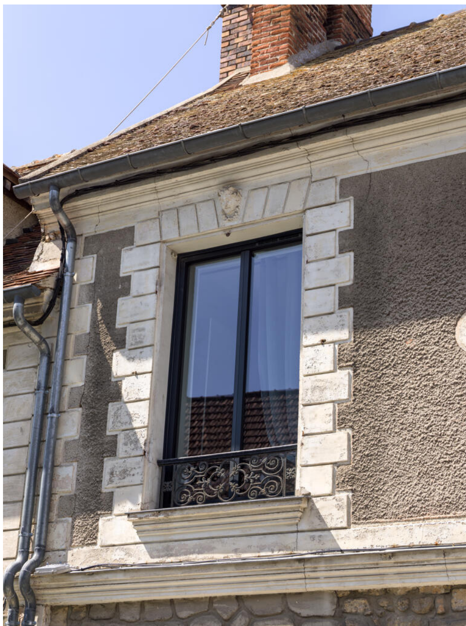
Vue d'une baie de l'étage.
