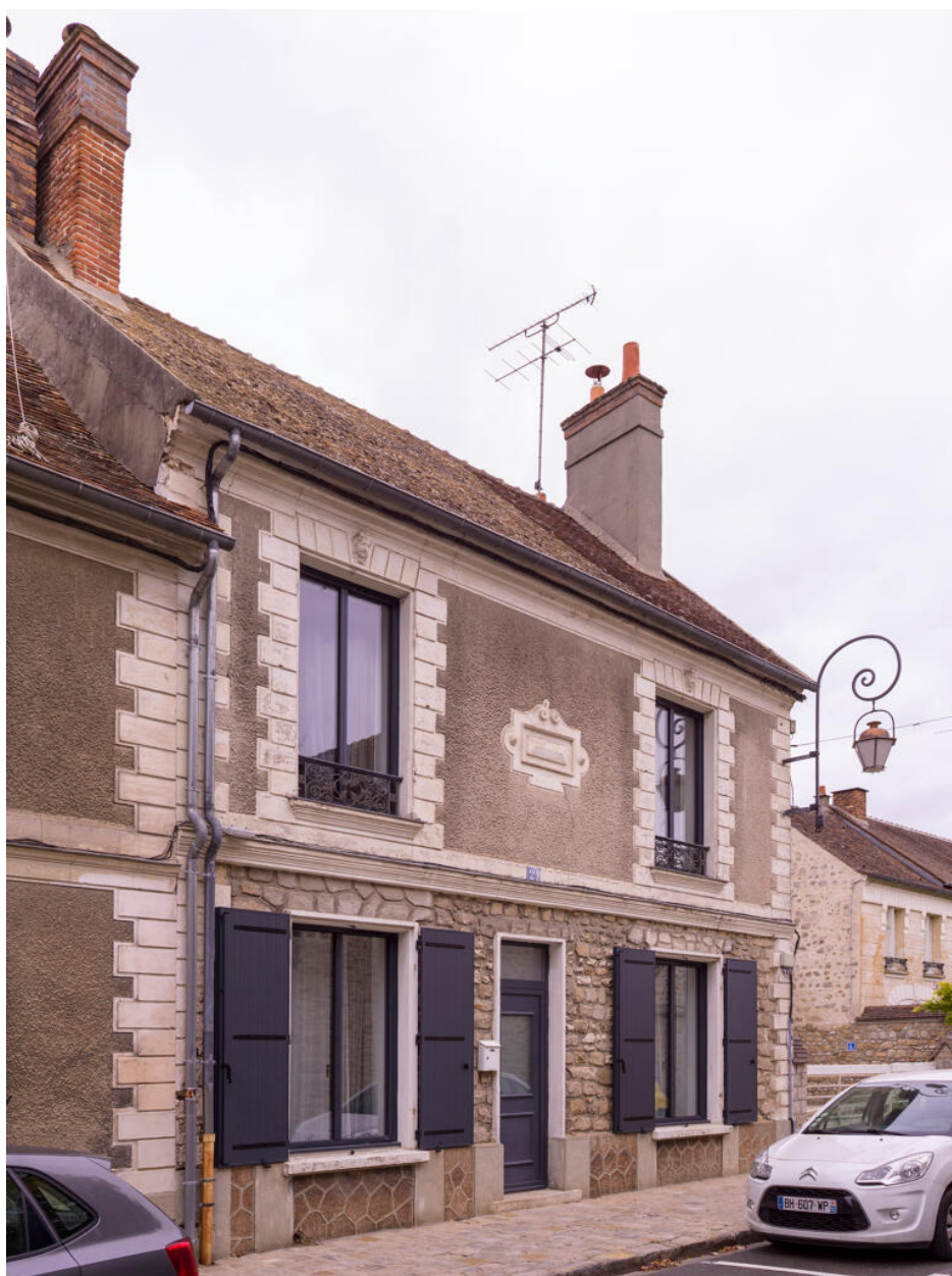
Vue depuis l'angle sud-ouest de la façade sur rue exposée au sud.
