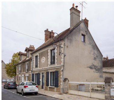
Vue depuis l'angle sud- est de la façade sud. Phot. Asseline Stéphane IVR11_20259101139NUC4A
