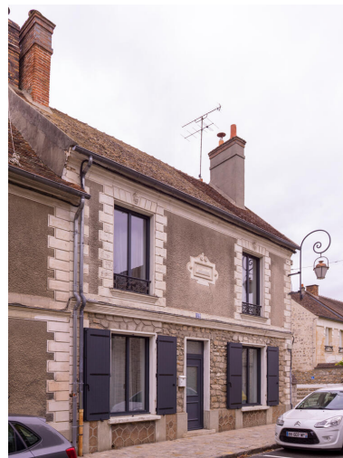
Vue depuis l'angle sud-ouest de la façade sur rue exposée au sud. Phot. Asseline Stéphane IVR11_20259101138NUC4A
