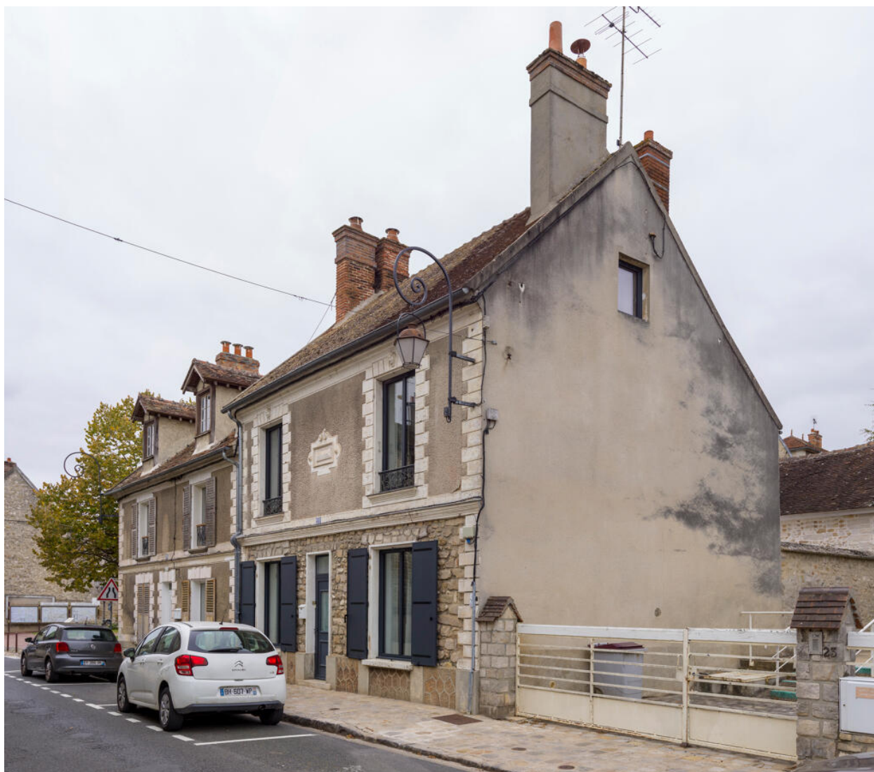
Vue depuis l'angle sud-est de la façade sud.
