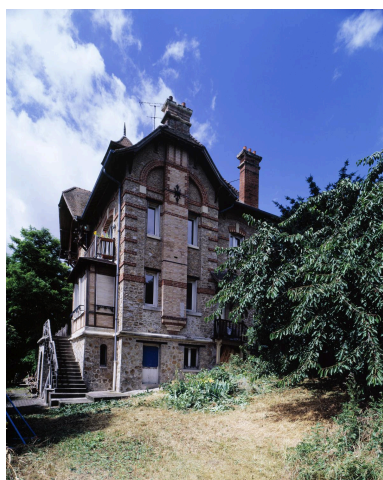
Vue latérale (façade est).
