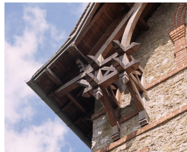
Détail d'un aisselier (façade sur jardin). Phot. Philippe Ayrault IVR11_20029100799XA
