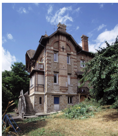
Vue latérale (façade est). Phot. Philippe Ayrault IVR11_20049100486XA
