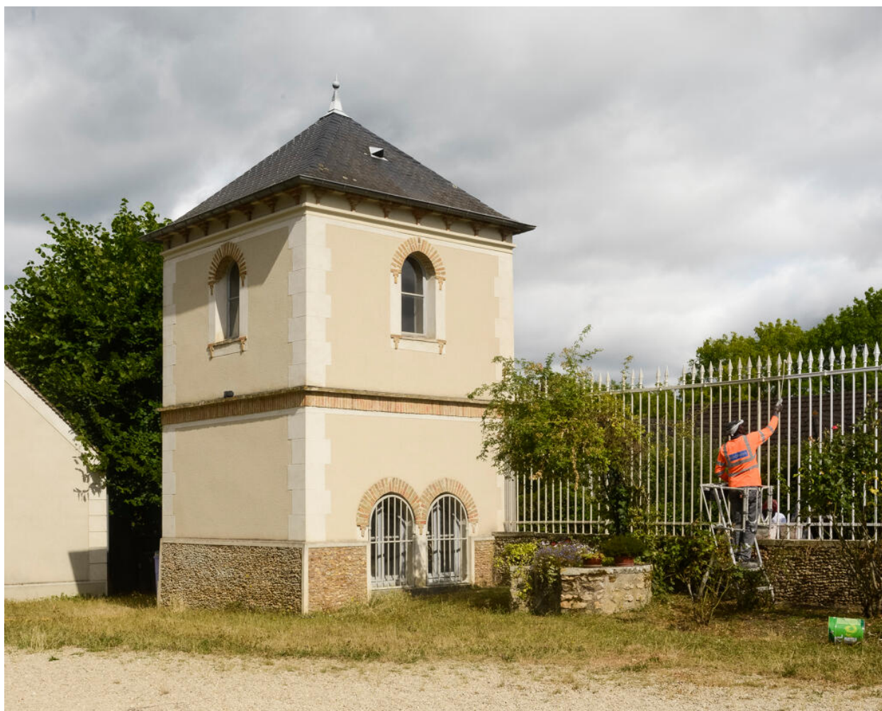
Détail du pavillon ouest de l'entrée.
