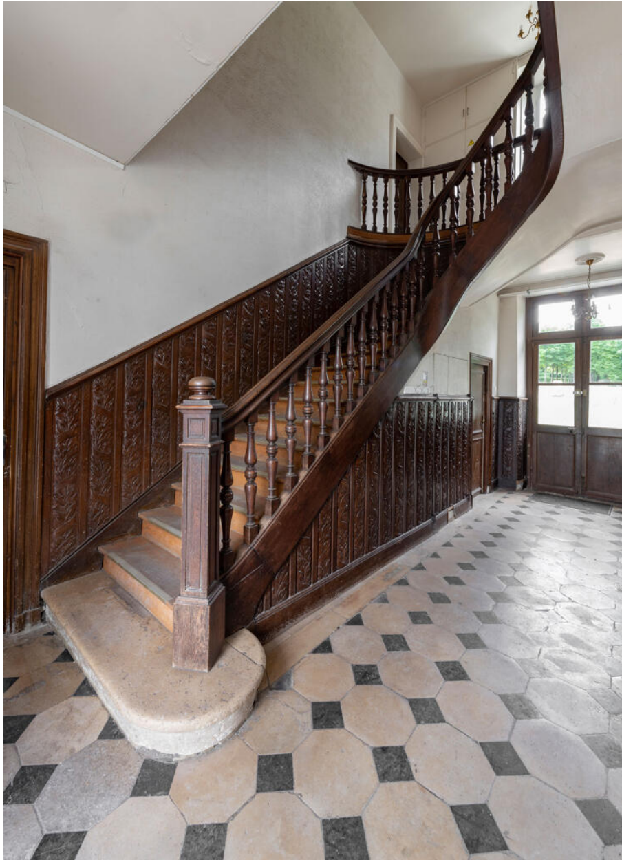
L'escalier dans le vestibule traversant, menant de l'entrée au parc. Seule la première marche est en pierre calcaire, identique à celle du sol à cabochons.
