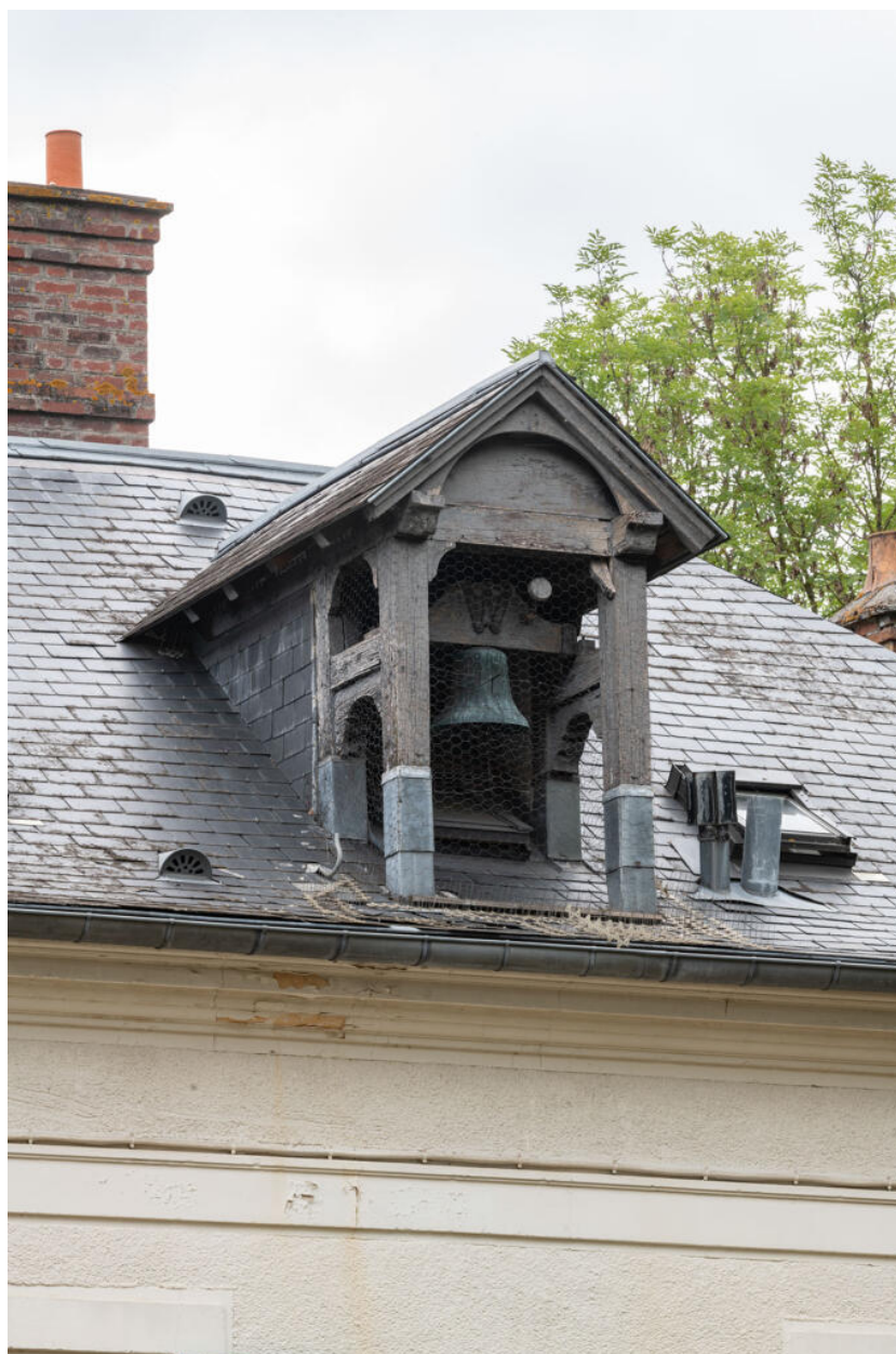
Côté sud, détail de la lucarne contenant une cloche. Elle existait déjà au début du XXe.
