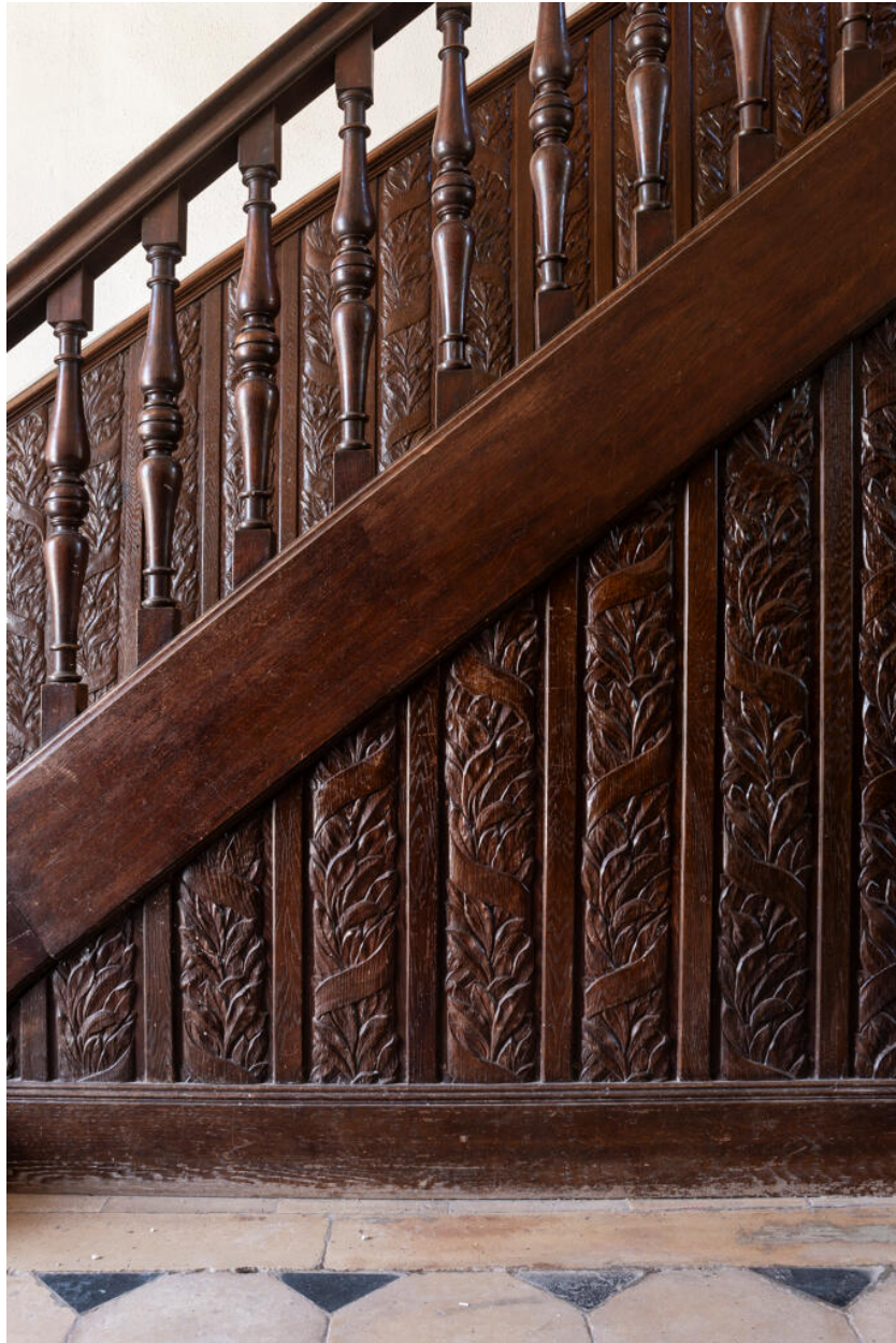
Détail de l'escalier entièrement en bois sculpté, avec son original décor de lauriers enrubannés et sa rampe d'appui à balustres en bois tourné.
