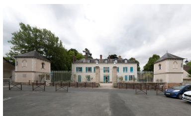
Vue d'ensemble du côté nord, séparé de la rue Desmazures-Mentienne par une grille. Le portail d'entrée est
