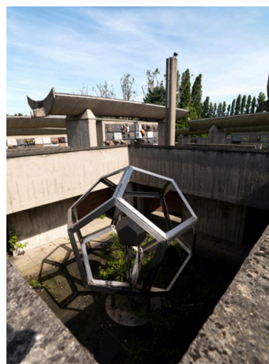
Vue d'ensemble depuis la plateforme des ossuaires individuels. Phot. Stéphane Asseline IVR11_20179300304NUCA
