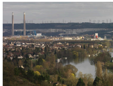
Les falaises de Guerville et la centrale de Porcheville. Phot. Laurent Kruszyk IVR11_20187800609NUC4A
