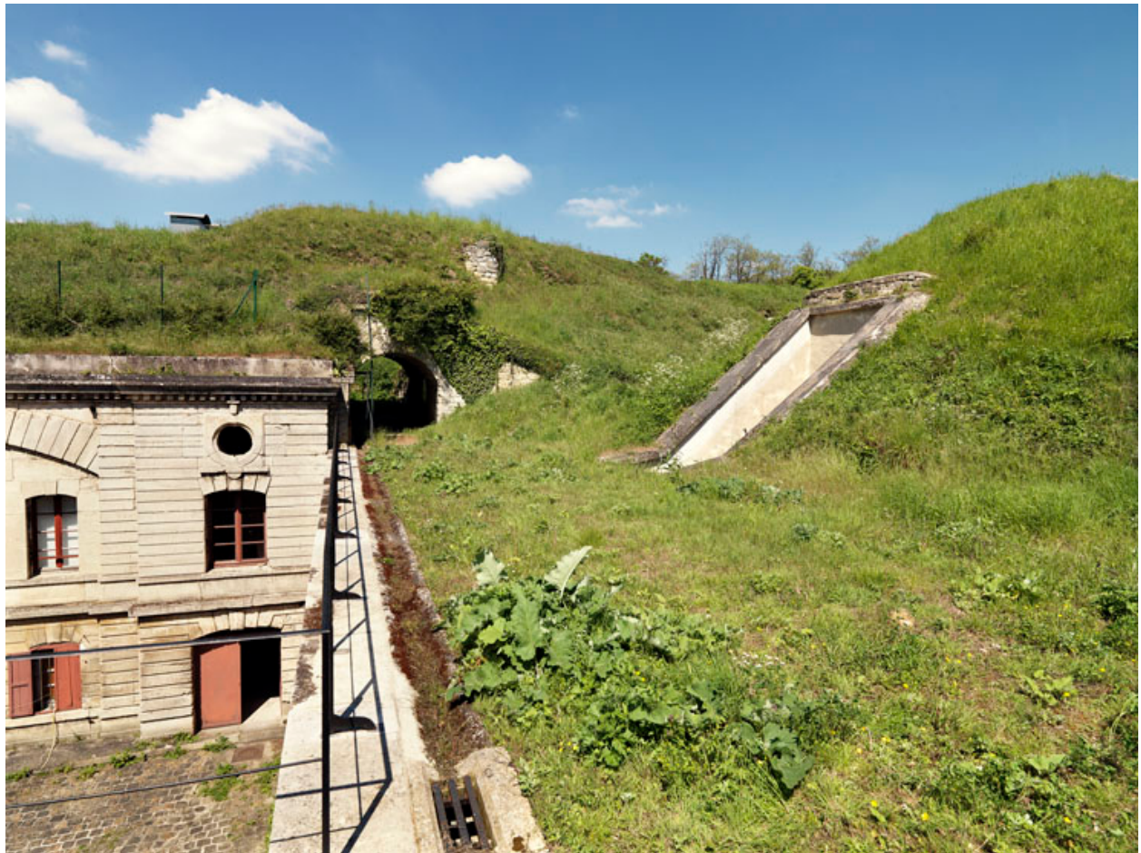
Le sommet des bâtiments, à l'est.
