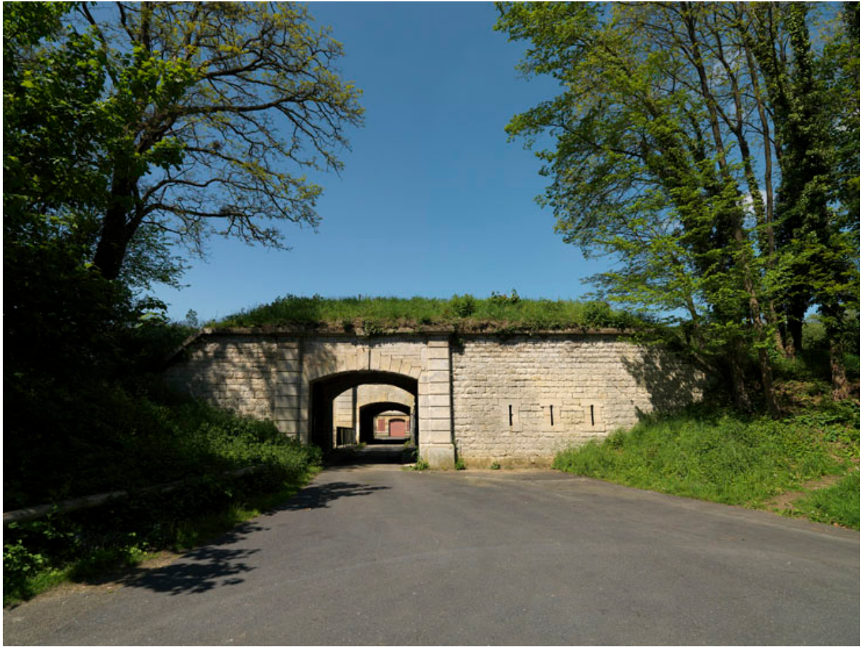
Le ravelin à l'entrée du fort.
