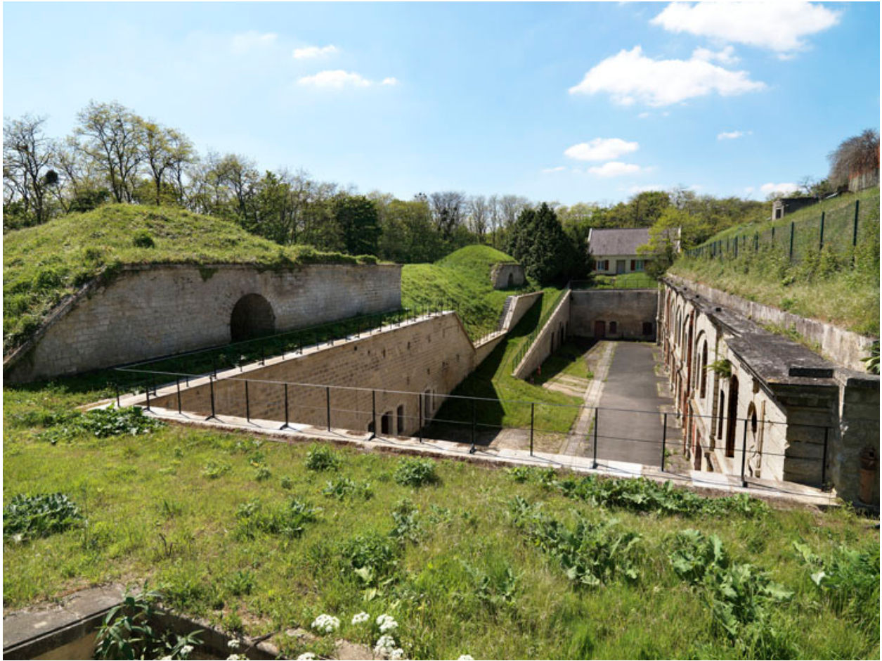
Vue du sommet des bâtiments, depuis l'est.
