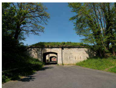
Le ravelin à l'entrée du fort. Phot. Jean-Bernard Vialles IVR11_20179500095NUC4A
