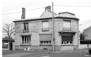
Vue de la façade. Phot. Stéphane Asseline IVR11_20037700127X
