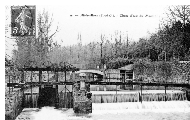
La chute d'eau du moulin. A l'arrière plan, le pont sur l'Orge construit en 1899 par la famille Chodron de Courcel. IVR11_20019100113X
