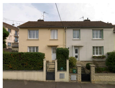
Vue d'un groupe de deux pavillons. Phot. Laurent Kruszyk IVR11_20167800431NUC4A
