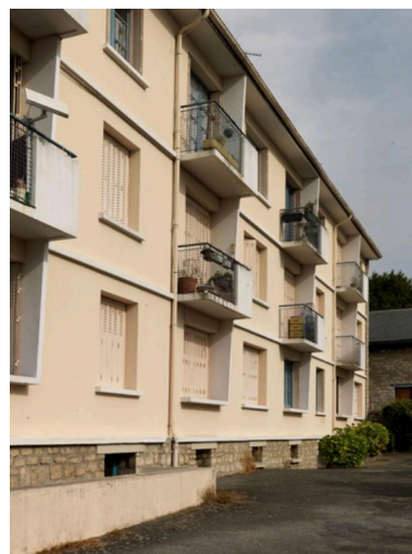
Façade principale tournée sur le jardin. Phot. Laurent Kruszyk IVR11_20167800429NUC4A
