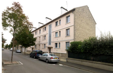
Façade sur rue de l'immeuble avec entrées et travées d'escalier. Phot. Laurent Kruszyk IVR11_20167800426NUC4A
