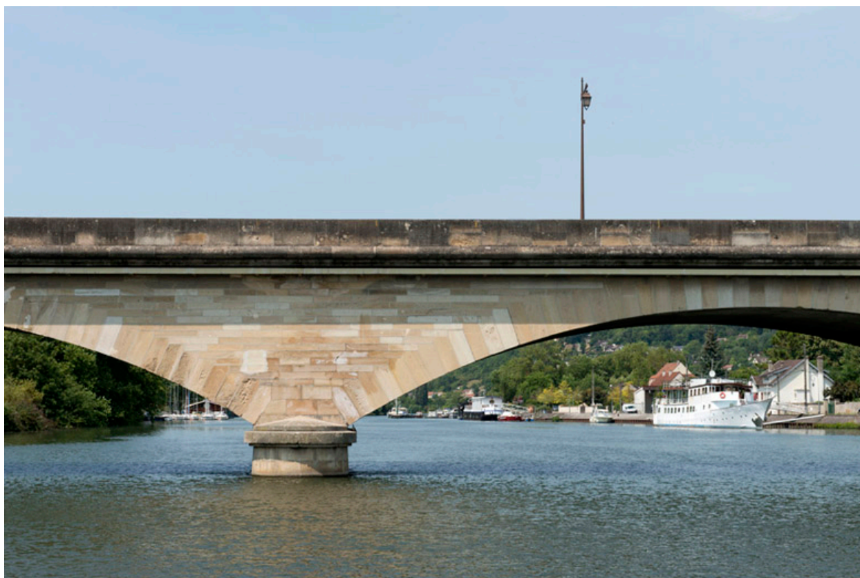
Vue d'une pile depuis la Seine.
