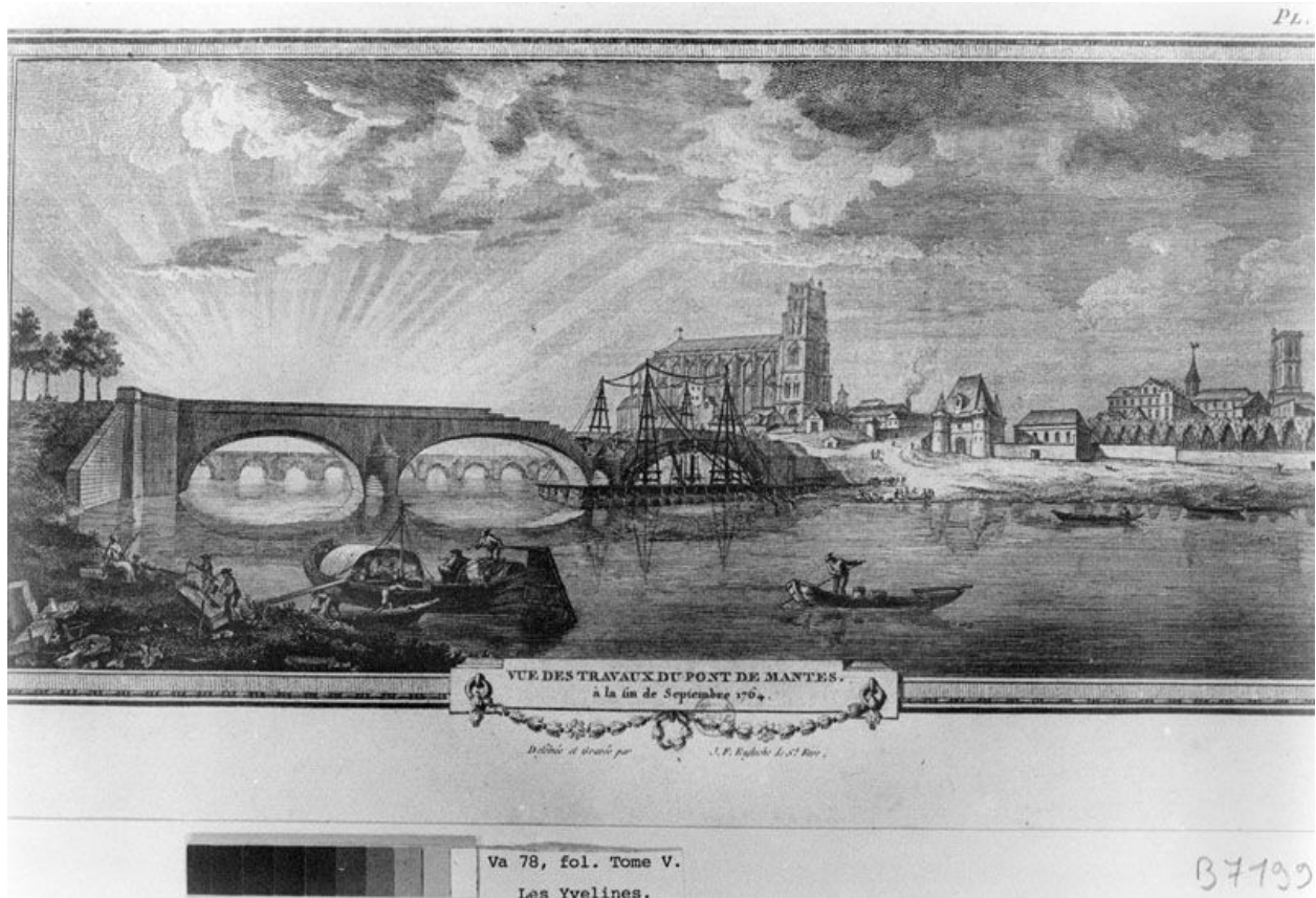
Vue des travaux du pont de Mantes à la fin de septembre 1764. Gravure, 18e siècle. (BNF, Va 78, fol., tome V, Yvelines, B 7199). Vue du Pont Neuf en construction en 1764 au premier plan et du Pont ancien de Mantes (détruit) au second plan ; vue prise vers l'amont depuis les rives d'une île.
