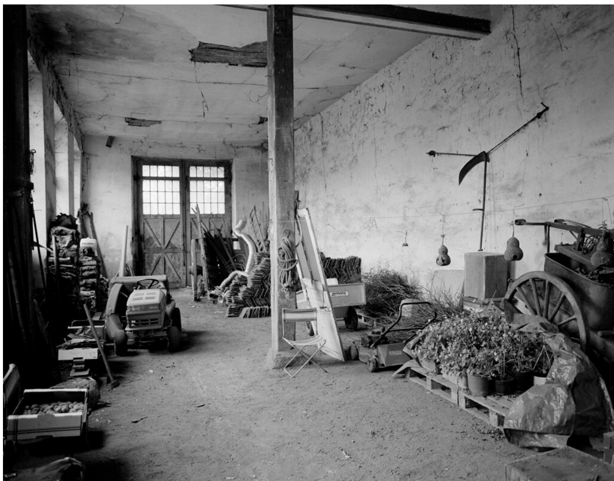
Vue intérieure de l'orangerie.
