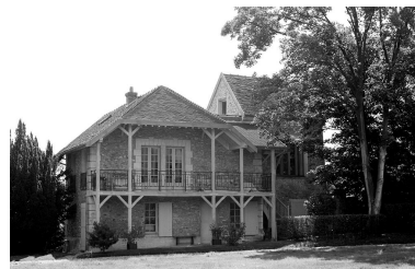
Un bâtiment agricole aménagé en atelier au début du siècle. Phot. Décamps Christian IVR11_20007800531X
