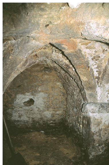
Détail des voûtes de la cave médiévale. Phot. Laforest Pascal IVR11_20017800003ZA
