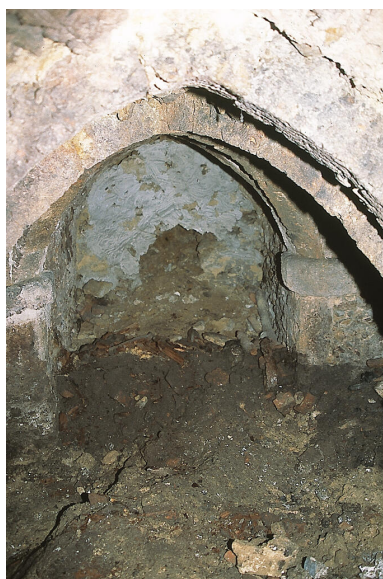
Vue des caves médiévales. Phot. Laforest Pascal IVR11_20017800001ZA
