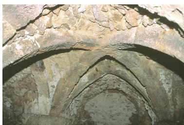
Vue des caves médiévales. Phot. Laforest Pascal IVR11_20017800002ZA
