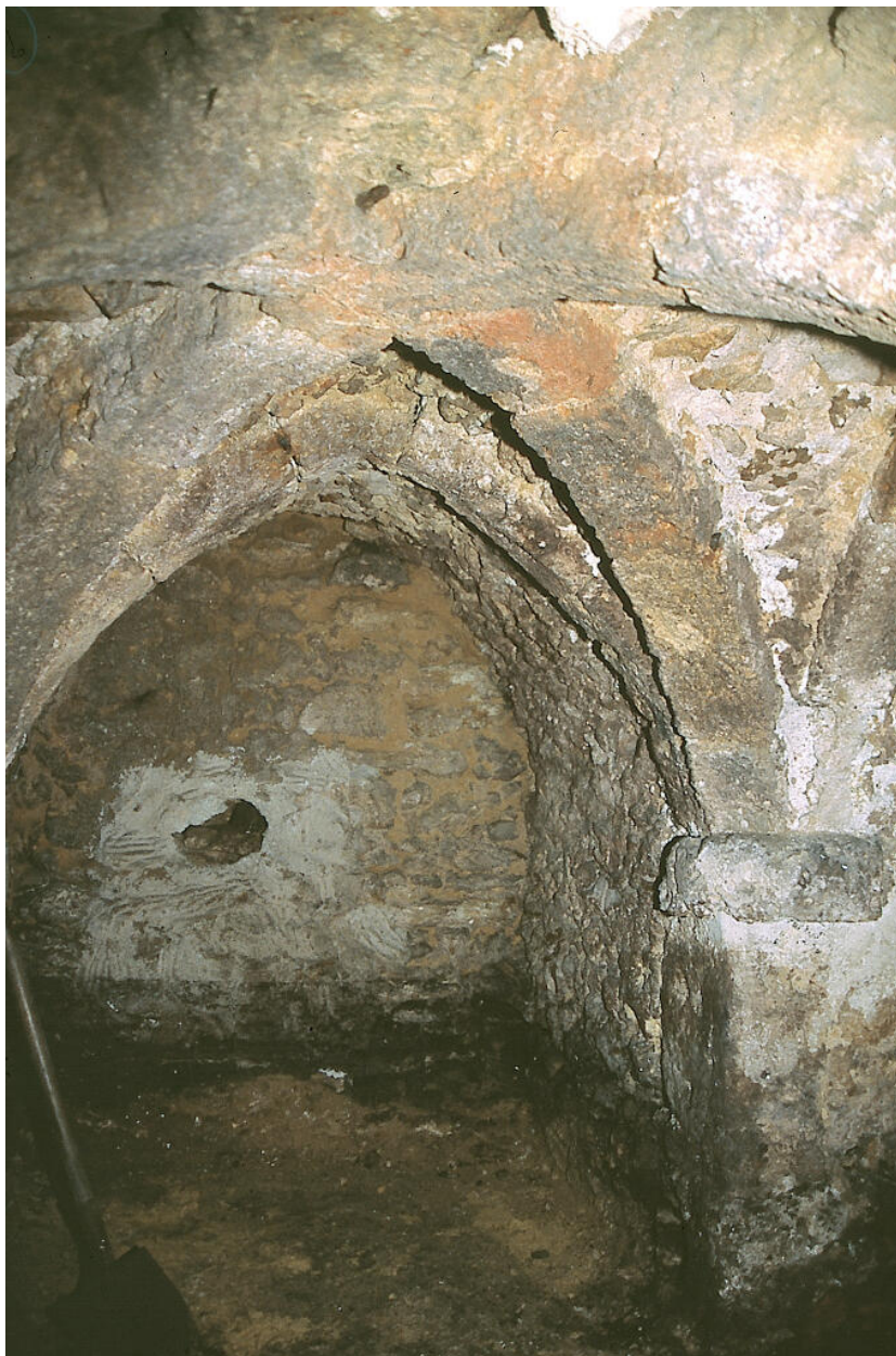
Détail des voûtes de la cave médiévale.
