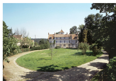
La façade antérieure et le jardin. Phot. Décamps Christian IVR11_20007800516XA
