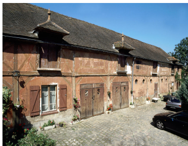
Les ancienne écuries. Phot. Décamps Christian IVR11_20007800528XA
