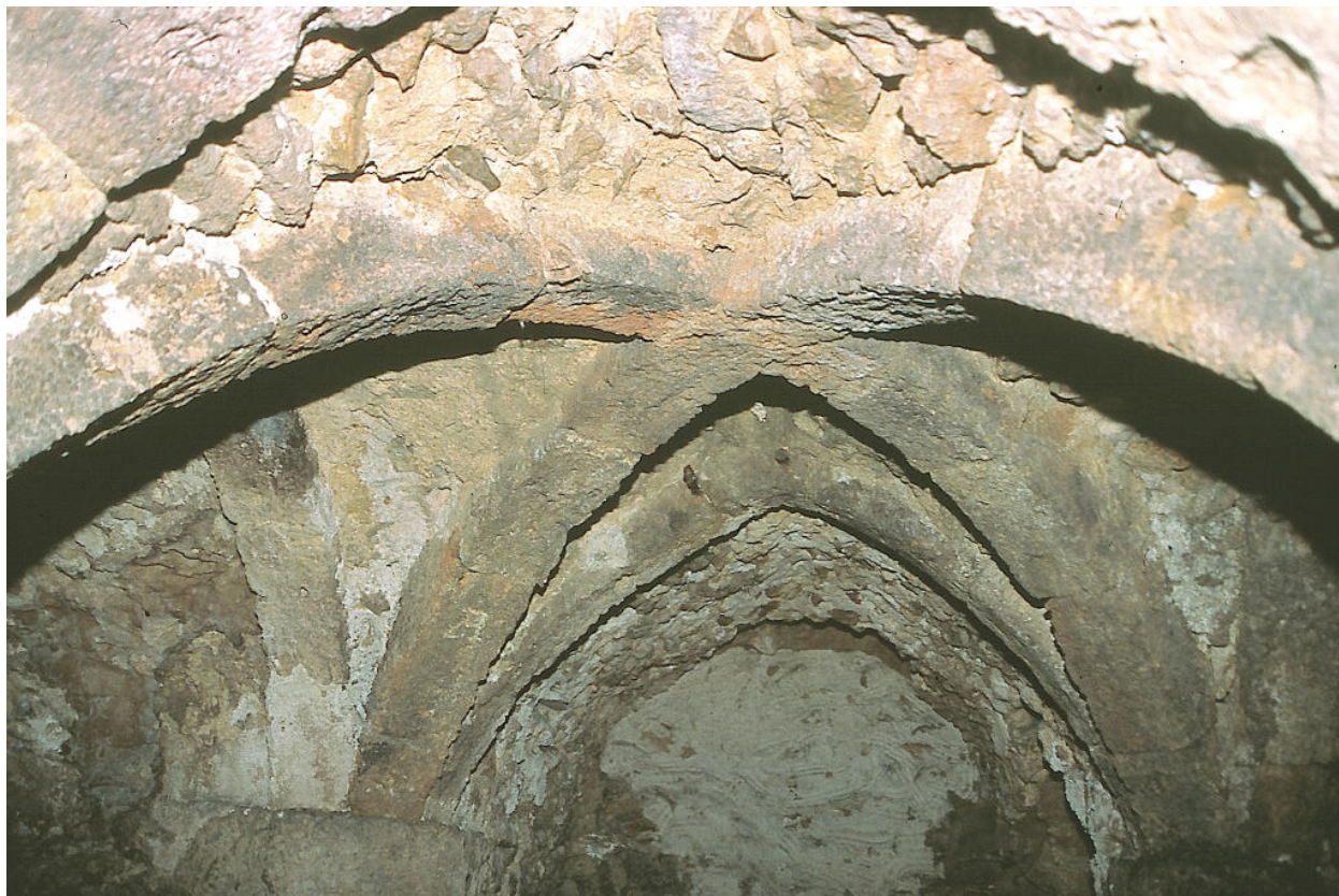
Vue des caves médiévales.
