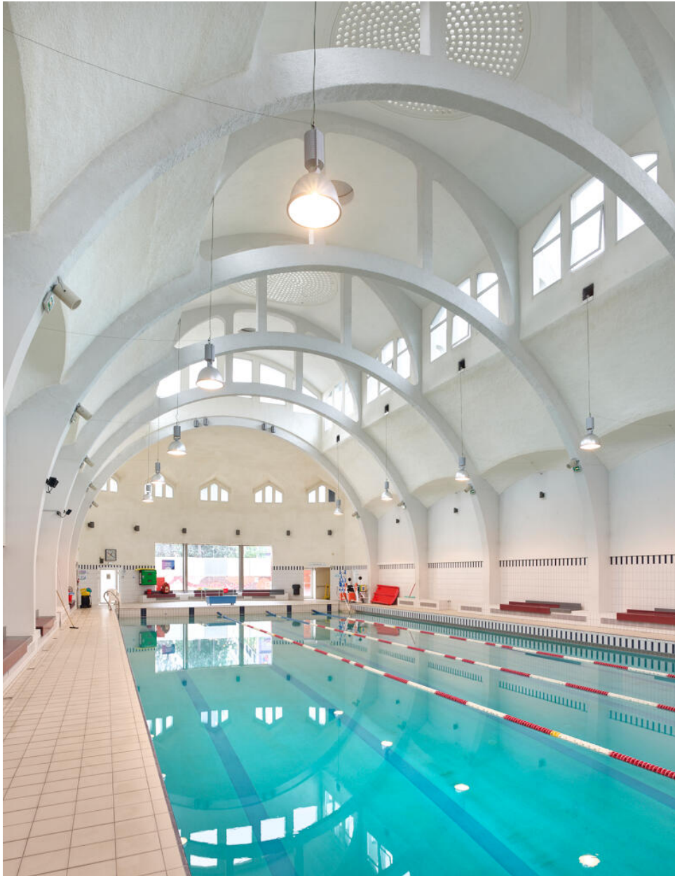
La piscine de la Butte aux cailles. Bassin vu depuis l'entrée.
