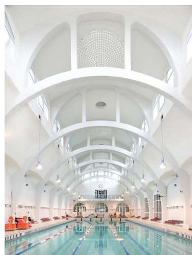
La piscine de la Butte aux cailles. Bassin vu de l'abside. Phot. Asseline Stéphane IVR11_20247500249NUC4A
