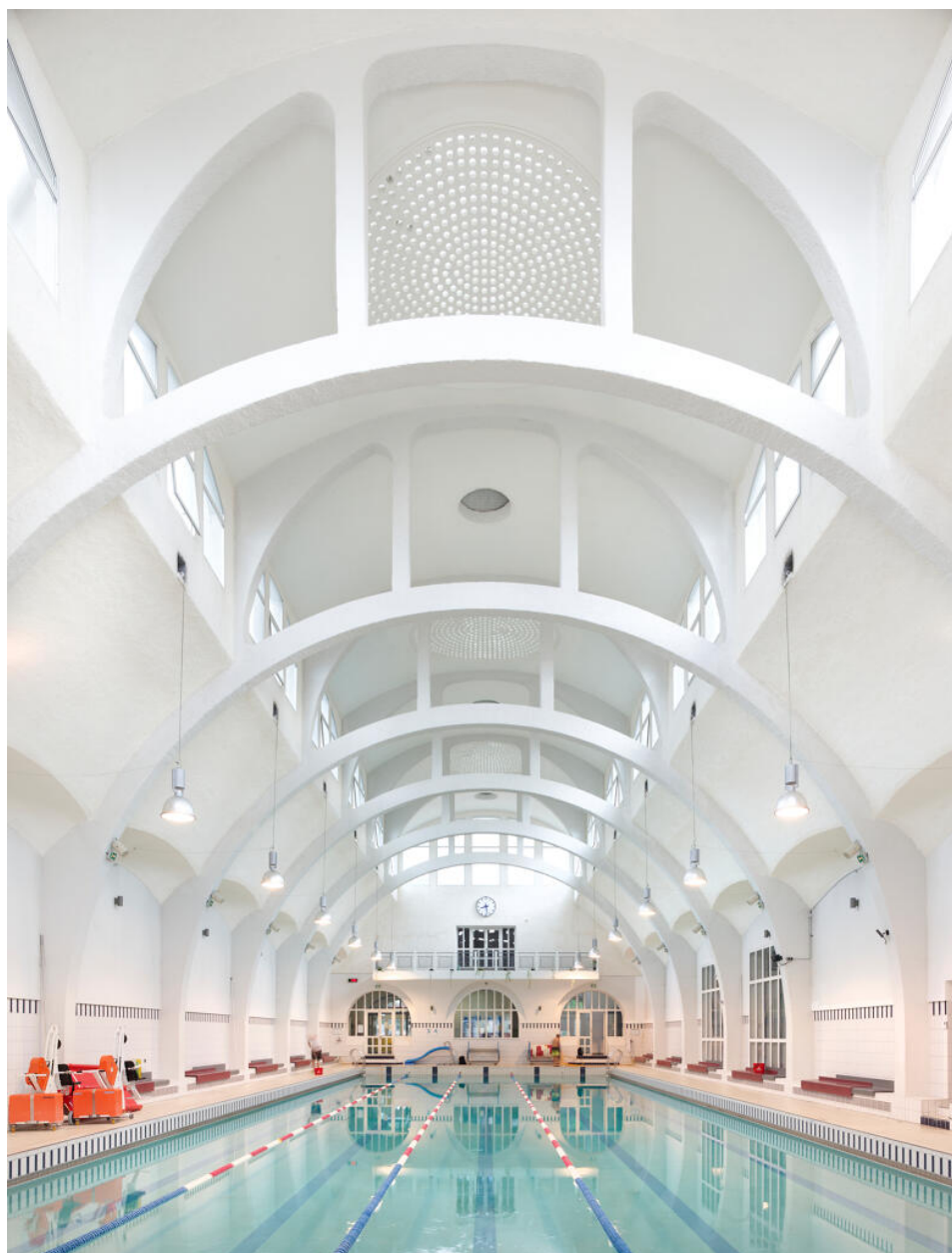
La piscine de la Butte aux cailles. Bassin vu de l'abside.
