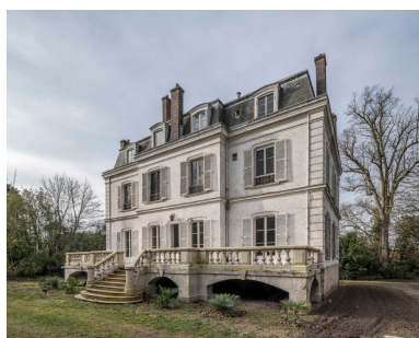
Façade sur le jardin. Phot. Ayrault Philippe IVR11_20239100090NUC4A
