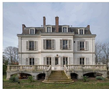
Façade sur jardin Phot. Philippe Ayrault IVR11_20239100089NUC4A
