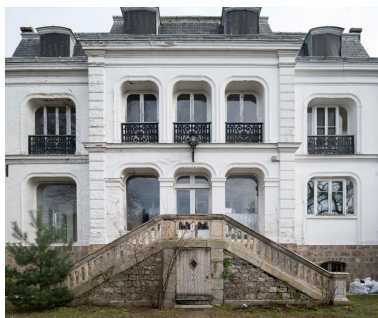
Façade d'entrée. Les fenêtres en retrait par rapport au mur apportent un fort relief. Phot. Ayrault Philippe IVR11_20239100119NUC4A
