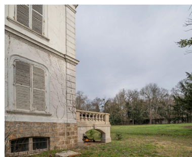
Extrémité de la façade sud. La terrasse vers le jardin est soutenue par des arcades de pierre. Phot. Ayrault Philippe IVR11_20239100091NUC4A
