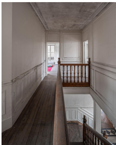
Palier du premier étage. Phot. Ayrault Philippe IVR11_20239100105NUC4A
