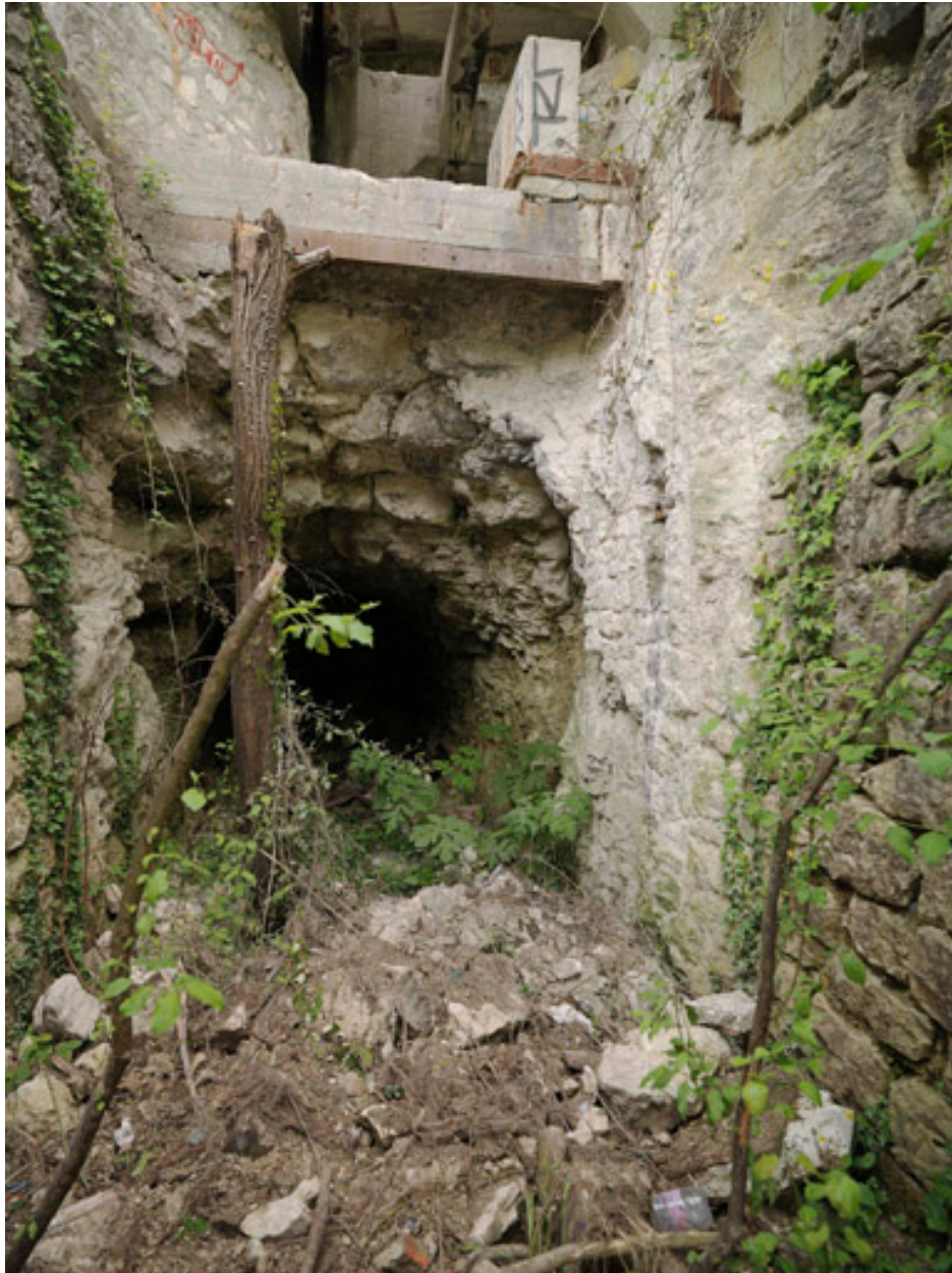
Vue extérieure des vestiges des bâtiments détruits.
