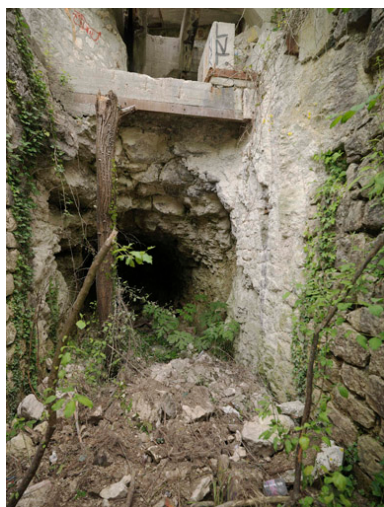
Vue extérieure des vestiges des bâtiments détruits. Phot. Philippe Ayrault
