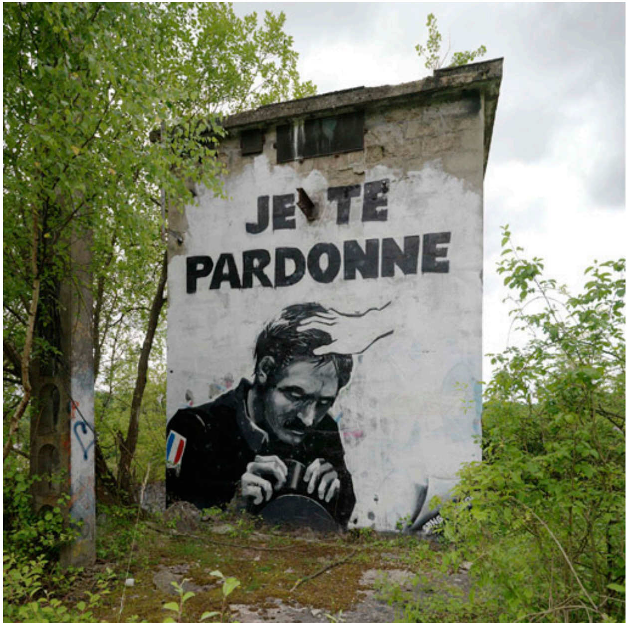
Vue extérieure des vestiges des bâtiments détruits. Poste électrique. Graffiti.
