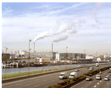
Charenton-le-Pont : au premier plan, les voies de l'A4, longeant la Seine. Au loin, le port d'Ivry. Phot. Stéphane Asseline IVR11_20089400036XE
