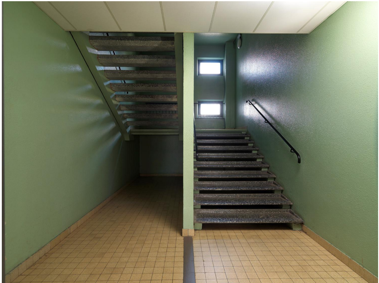
Une cage d'escalier, avec de fines marches suspendues pavées de granito.
