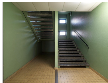
Une cage d'escalier, avec de fines marches suspendues pavées de granito.
