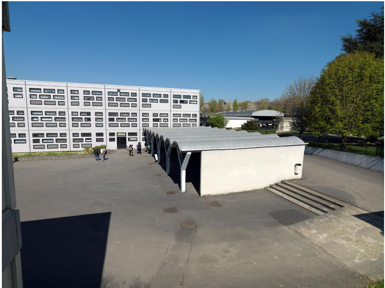
Le préau séparant les cours basse et haute, avec également des poteaux en Y.
