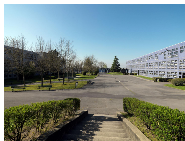
La composition générale du lycée repose sur la juxtaposition de
