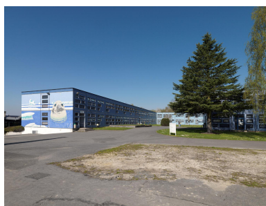
Vue générale de la cour haute, où sont disséminés les bâtiments de l'internat.
