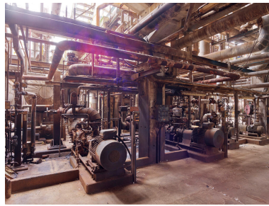
Unités Est - Zone FCC (Unité 651). Pompes utilisées pour transférer un produit d'une capacité à une autre.
