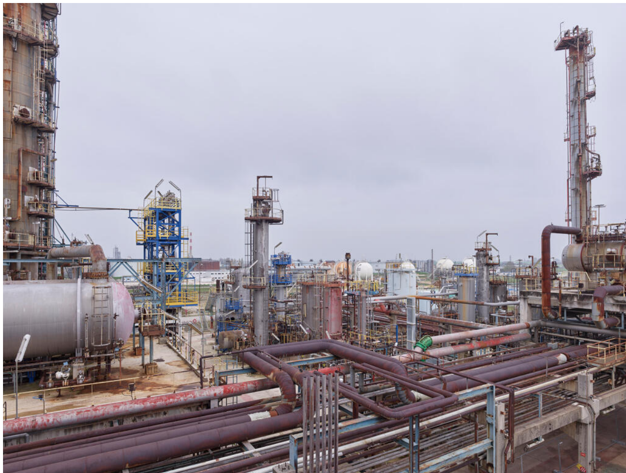
Unités Est - Zone FCC (Unité 651). Vue générale.
