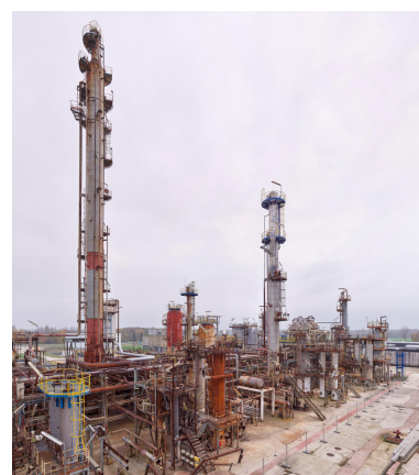
Unités Est - Zone FCC (Unité 651). Vue globale sur l'alkylation. La colonne C1003 (isostrippeur, séparation des gaz) au premier plan est la plus grande du site (72 mètres). Phot. Stéphane Asseline, Phot. Stéphane Asseline IVR11_20237700241NUC4A
