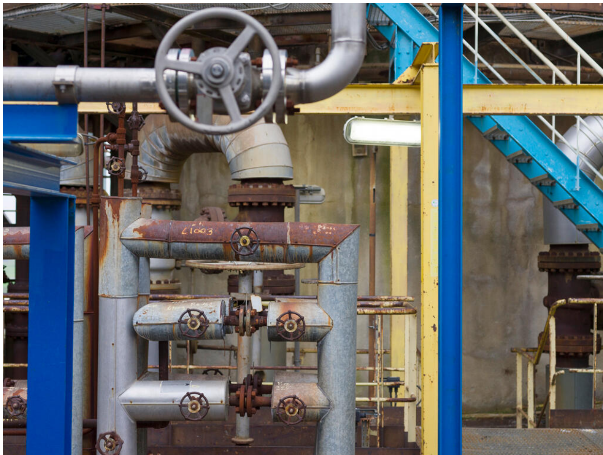
Unités Est - Zone FCC (Unité 651). Système de fluidisation et d'apport en oxygène pur pour le régénérateur du FCC (Unité 651)
