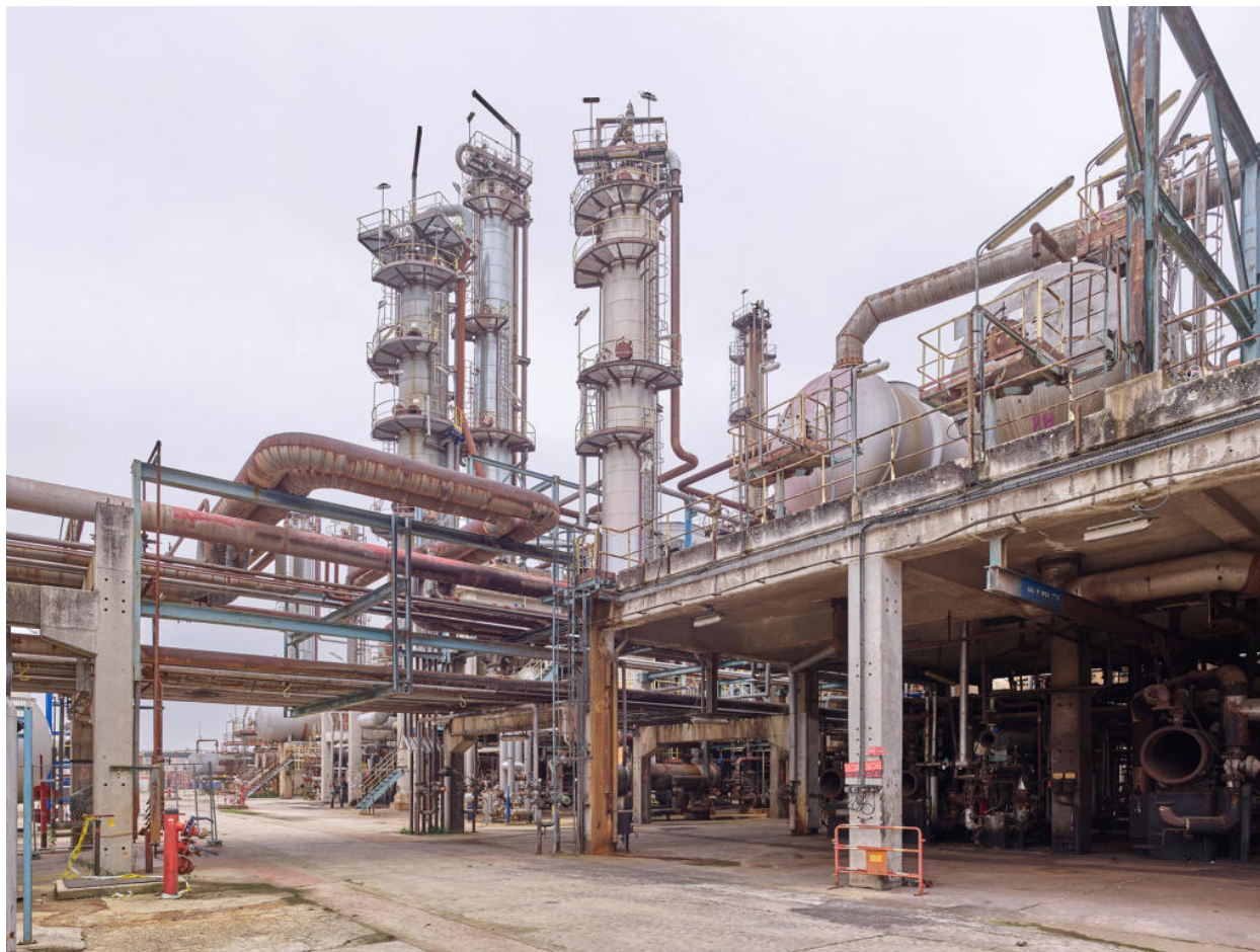
Unités Est - Zone FCC (Unité 651). Allée de cheminement entre le FCC l'Unité Merox (oxydation des essences et GPL).
