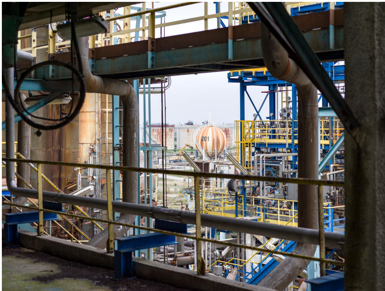
Vue sur les sphères depuis la plateforme des aéros réfrigérants 651 EM 1001.
