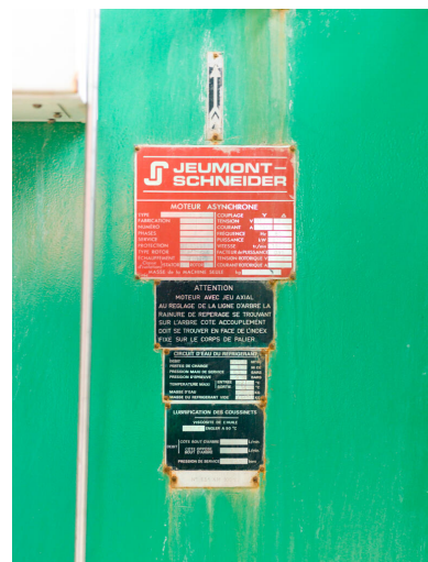
Unités Est - Zone FCC (Unité 651). Compresseur turbo-alternateur, autrement dit compresseur à récupération d'énergie. Plaque signalétique du moteur Jeumont-Schneider, utilisé pour le démarrage du compresseur. Phot. Hourdebaigt Cindy IVR11_20237700217NUC4A
