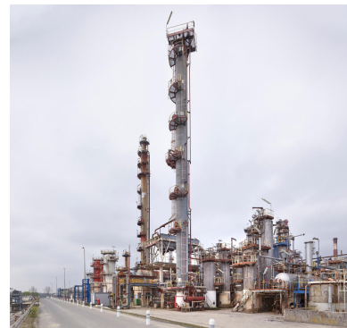
Vue de l'unité alkylation depuis l'angle nord-est de l'avenue 3 bis. Au premier plan, le préfractionneur de l'unité alkylation (traitement à la soude), au second plan l'alkylation. Phot. Stéphane Asseline, Phot. Stéphane Asseline IVR11_20237700267NUC4A
