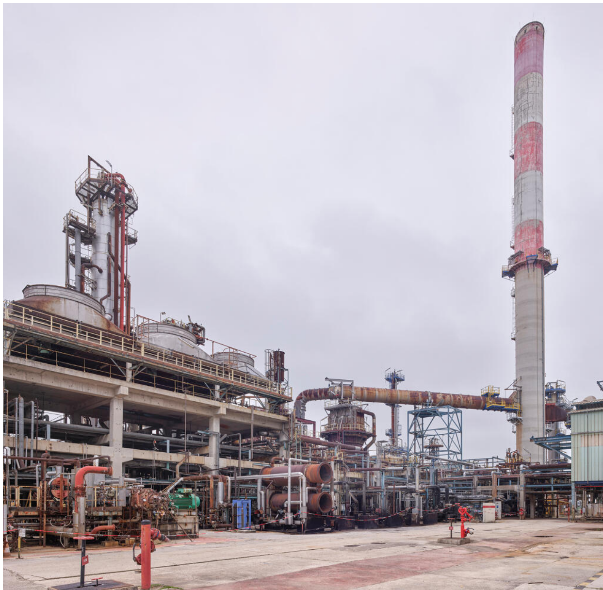
Unités Est - Zone viscoréducteur (Unité 691). Vue générale du viscoréducteur avec à gauche, les aéroréfrigérants et à droite, le four connecté à sa cheminée.
