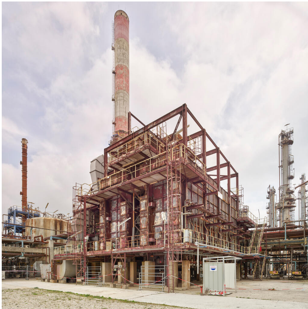
Unités Est - Zone du viscoréducteur (Unité 691). Vue globale du four de l'unité, depuis le sud-est.
