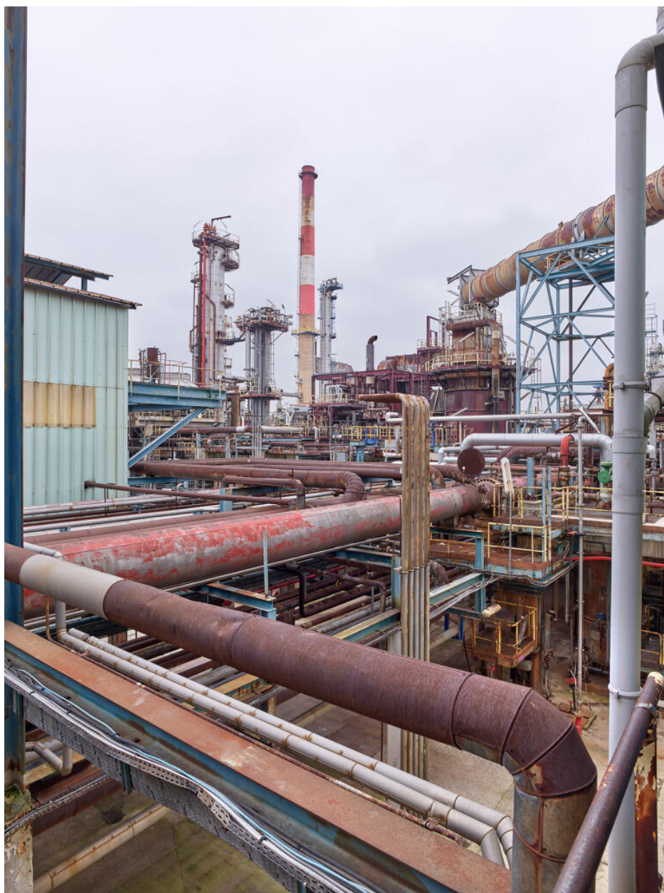
Unités Est - Zone FCC (Unité 651). Vue générale des Unités depuis le compresseur K1001.
