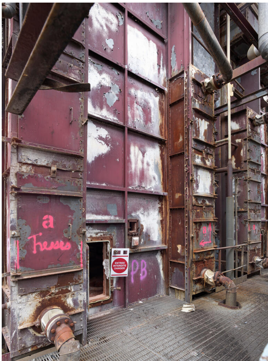
Unités Est - Zone du viscoréducteur (Unité 691). Porte d'entrée vers une cellule du four de l'unité.
