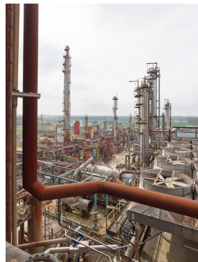
Unités Est - Zone FCC (Unité 651). Vue sur l'alkylation (à gauche) depuis la zone réactionnelle du FCC. À droite, la batterie aéroréfrigérants E 1001 . Phot. Stéphane Asseline, Phot. Stéphane Asseline IVR11_20237700279NUC4A
