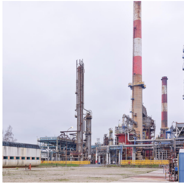
Unités Est - Zone viscoréducteur (Unité 691). Vue générale du viscoréducteur à droite. Au fond, les Unités Ouest. À gauche, la salle de contrôles. Phot. Stéphane Asseline, Phot. Stéphane Asseline IVR11_20237700199NUC4A
