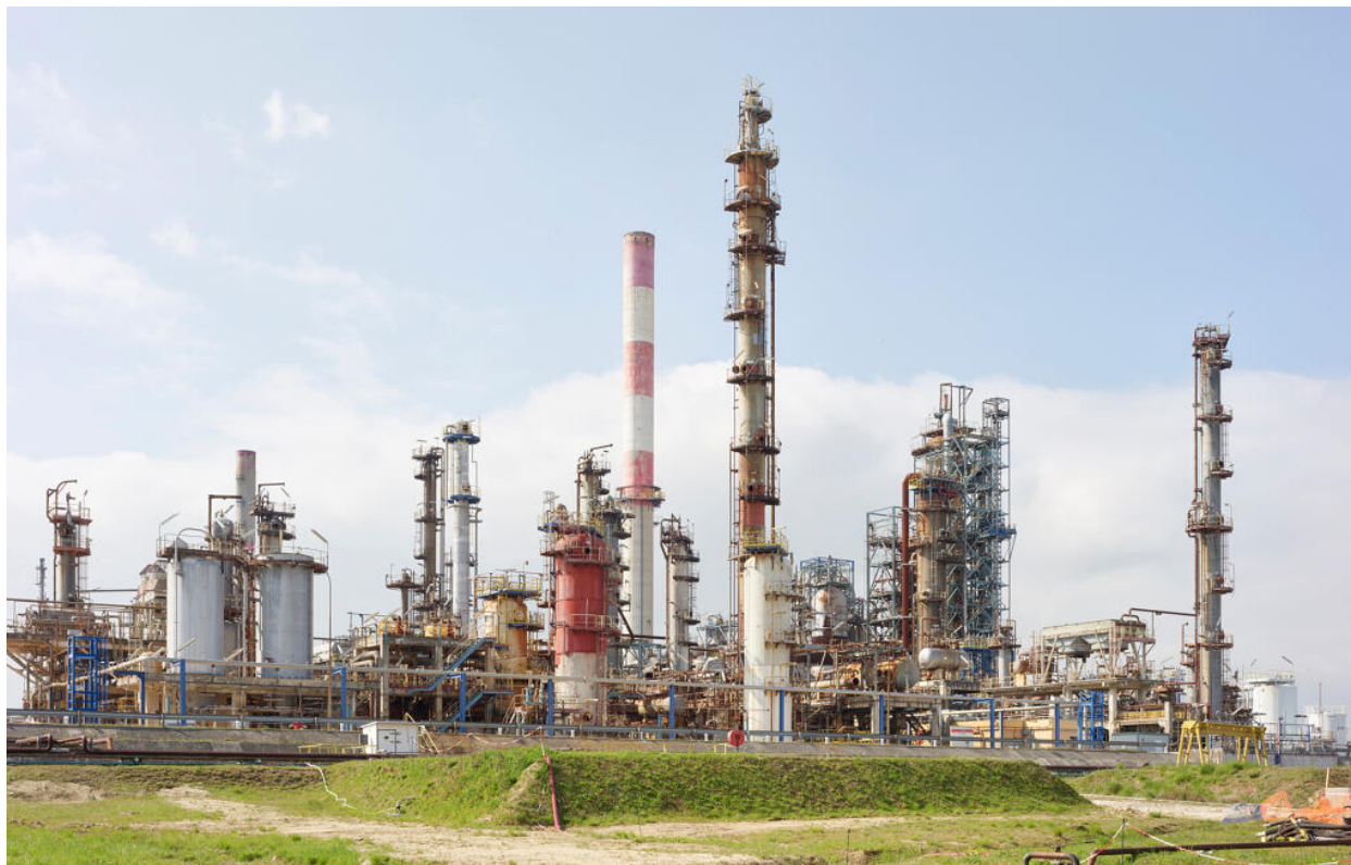
Unités Est - Zone alkylation (Unité 761). Vue générale. Transformation des GPL à l'aide d'un acide en essence à très haut indice d'octane.
