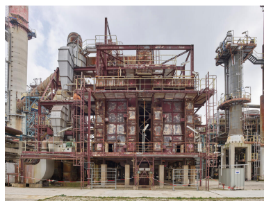
Unités Est - Zone du viscoréducteur (Unité 691). Vue globale du four de l'unité depuis l'est. Phot. Stéphane Asseline, Phot. Stéphane Asseline IVR11_20237700287NUC4A
