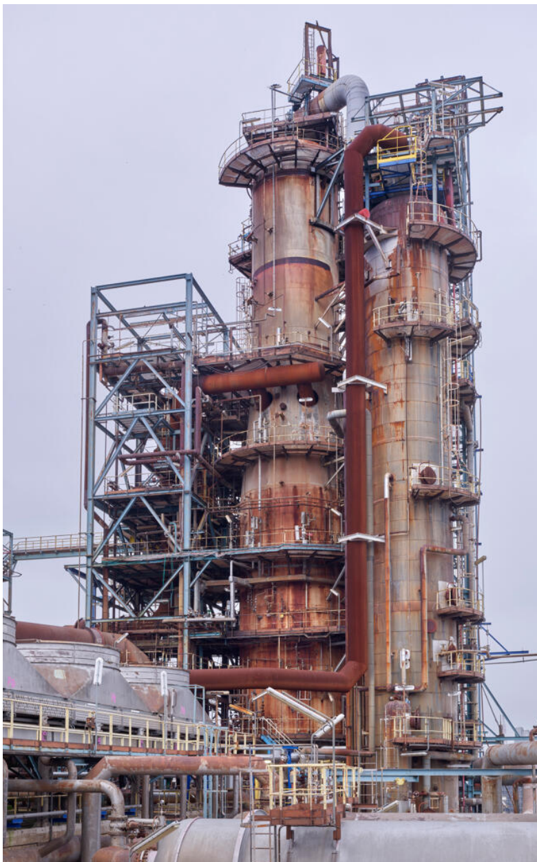
Unités Est - Zone FCC (Unité 651). Zone réactionnelle du FCC. Colonne de fractionnement primaire à droite. Début du process.
