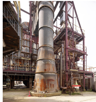
Unités Est - Zone du viscoréducteur (Unité 691). Four du viscoréducteur. Alimentation en air. Phot. Stéphane Asseline, Phot. Stéphane Asseline IVR11_20237700282NUC4A
