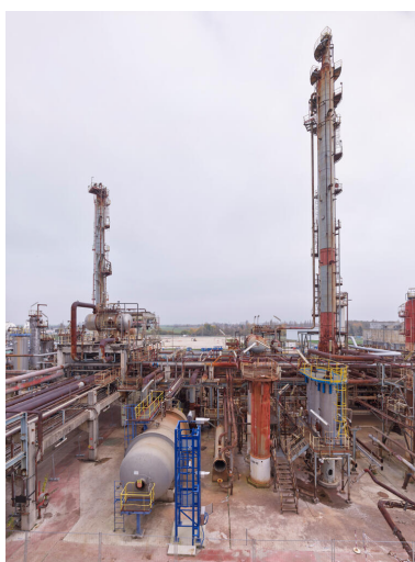
Unités Est - Zone FCC (Unité 651). Vue partielle sur l'alkylation. La structure en bleu est le radar de détection de fuite d'acide fluoridrique (HF). Phot. Stéphane Asseline, Phot. Stéphane Asseline IVR11_20237700240NUC4A
