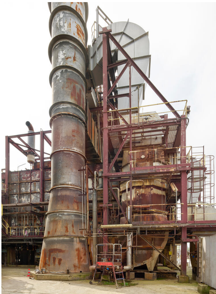
Unités Est - Zone du viscoréducteur (Unité 691). Vue sur les lignes des fumées du four du viscoréducteur.
