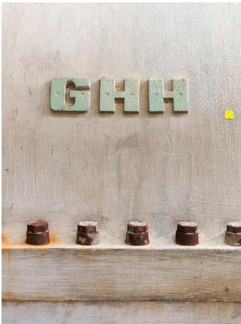
Unités Est - Zone FCC (Unité 651). Compresseur turbo-alternateur, autrement dit compresseur à récupération d'énergie. Plaque signalétique du compresseur.
