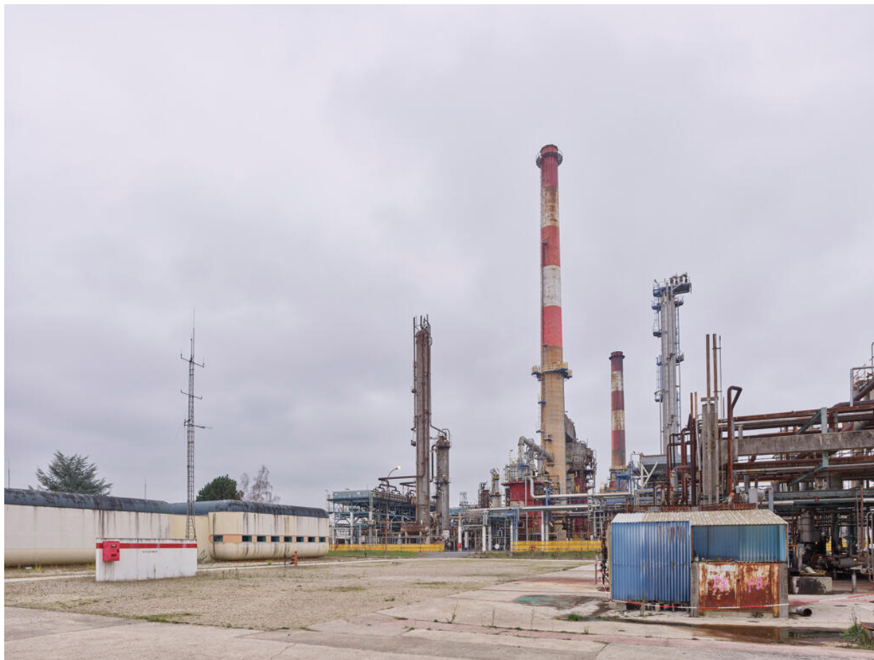
Unités Est - Zone viscoréducteur (Unité 691). Vue générale du viscoréducteur à droite. Au fond, les Unités Ouest. À gauche, la salle de contrôles.
