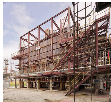
Unités Est - Zone du viscoréducteur (Unité 691). Vue globale du four de l'unité depuis le sud-ouest. Phot. Stéphane Asseline, Phot. Stéphane Asseline
