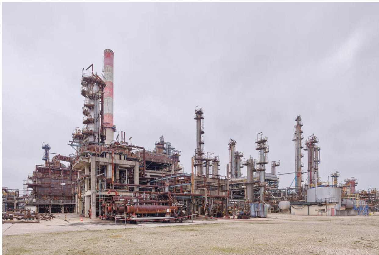
Unités Est - Zone viscoréducteurs (Unité 691). Traitements des résidus de la distillation sous-vide pour obtenir des bases gasoil.
