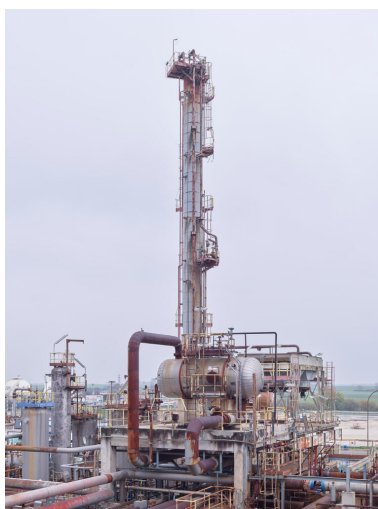
Unités Est - Zone FCC (Unité 651). Vue sur la colonne de préfractionnement, pour préparer la charge de l'alkylation. Phot. Stéphane Asseline, Phot. Stéphane Asseline IVR11_20237700237NUC4A
