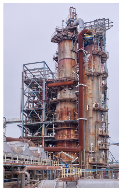
Unités Est - Zone FCC (Unité 651). Zone réactionnelle du FCC. Colonne de fractionnement primaire à droite. Début du process. Phot. Stéphane Asseline, Phot. Stéphane Asseline IVR11_20237700238NUC4A
