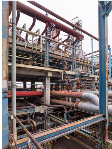
Unités Est - Zone FCC (Unité 651). Au premier plan, en rouge, ligne de torches (évacuation des gaz). Phot. Stéphane Asseline, Phot. Stéphane Asseline IVR11_20237700225NUC4A
