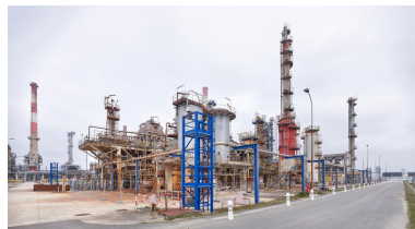
Vue de l'unité alkylation depuis l'angle sud-est de l'avenue 3 bis. Au premier plan (structure bleue), le radar détecteur d'HF (acide fluorhydrique). Phot. Stéphane Asseline, Phot. Stéphane Asseline IVR11_20237700266NUC4A
