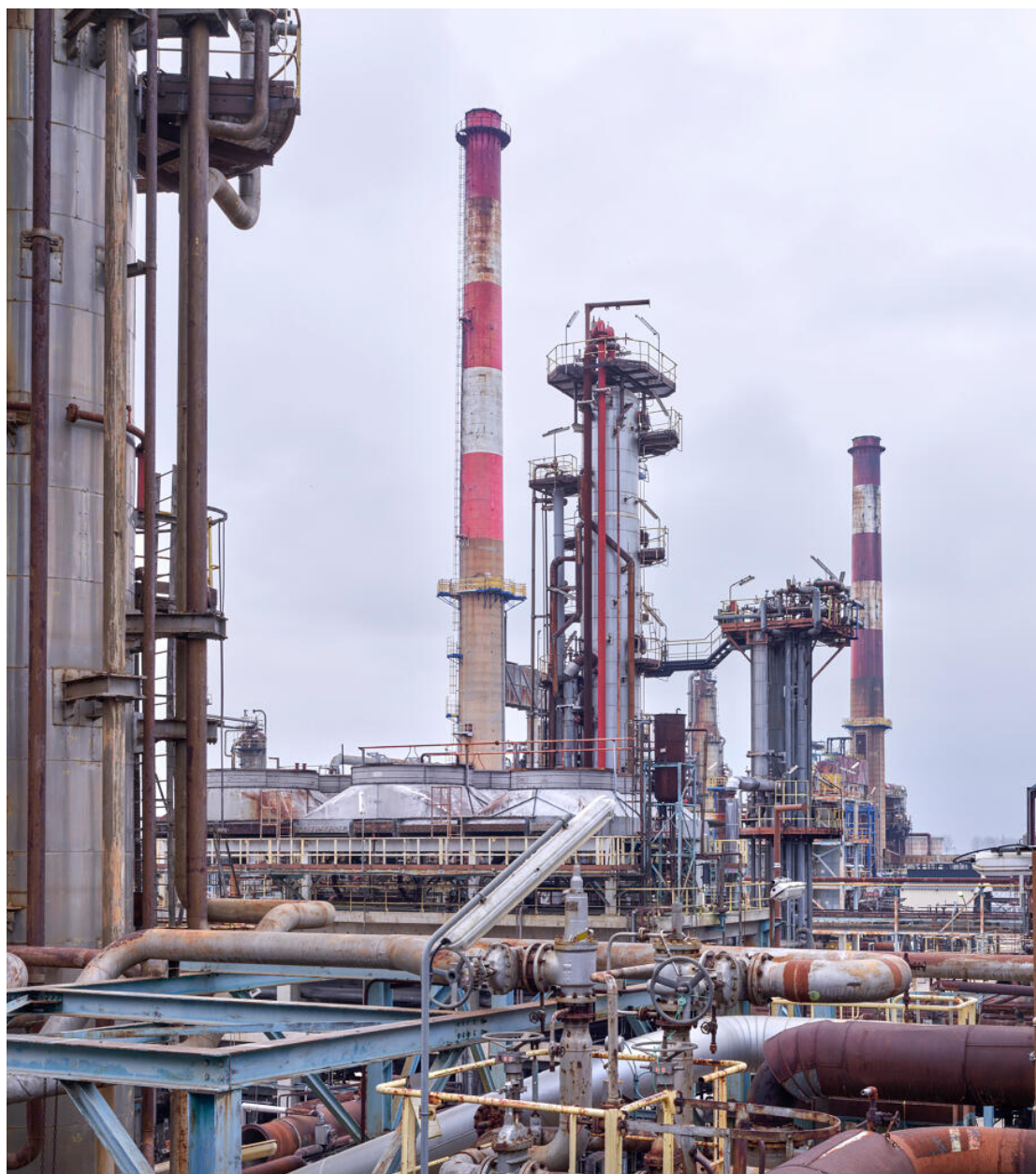
Unité Est - Vue sur le viscoréducteur (Unité 691) depuis la plateforme du stripping des eaux FCC (Unité 651)
