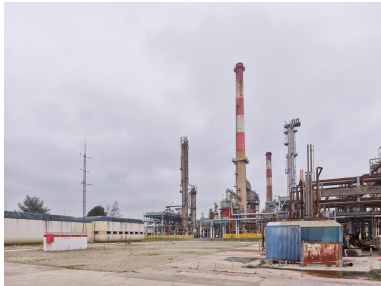
Unités Est - Zone viscoréducteur (Unité 691). Vue générale du viscoréducteur à droite. Au fond, les Unités Ouest. À gauche, la salle de contrôles. Phot. Stéphane Asseline, Phot. Stéphane Asseline IVR11_20237700198NUC4A
