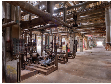
Unités Est - Zone FCC (Unité 651). Allée centrale du FCC avec vue sur les racks et à gauche, les pompes. En cours de démontage.
