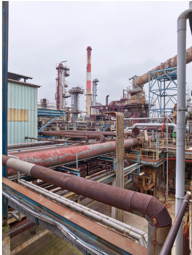
Unités Est - Zone FCC (Unité 651). Vue générale des Unités depuis le compresseur K1001. Phot. Stéphane Asseline, Phot. Stéphane Asseline IVR11_20237700224NUC4A
