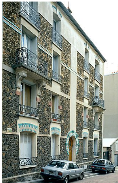
Façade antérieure. Phot. Christian Décamps IVR11_19869400288VA
