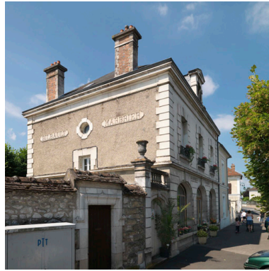
Vue extérieure du bâtiment. L'enseigne "Bilbault marbrier" est posée sur la façade latérale. Phot. Philippe Ayrault IVR11_20087701133NUC4A
