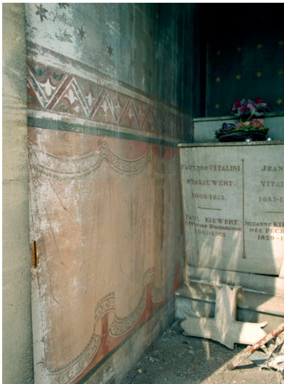
Détail du décor peint de l'intérieur de la chapelle : dans la partie inférieure figurent des draperies évoquant un style pompéien.
