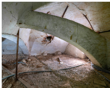
Charpente en maçonnerie de moellon et brique. Phot. Ayrault Philippe IVR11_20237700956NUC4A
