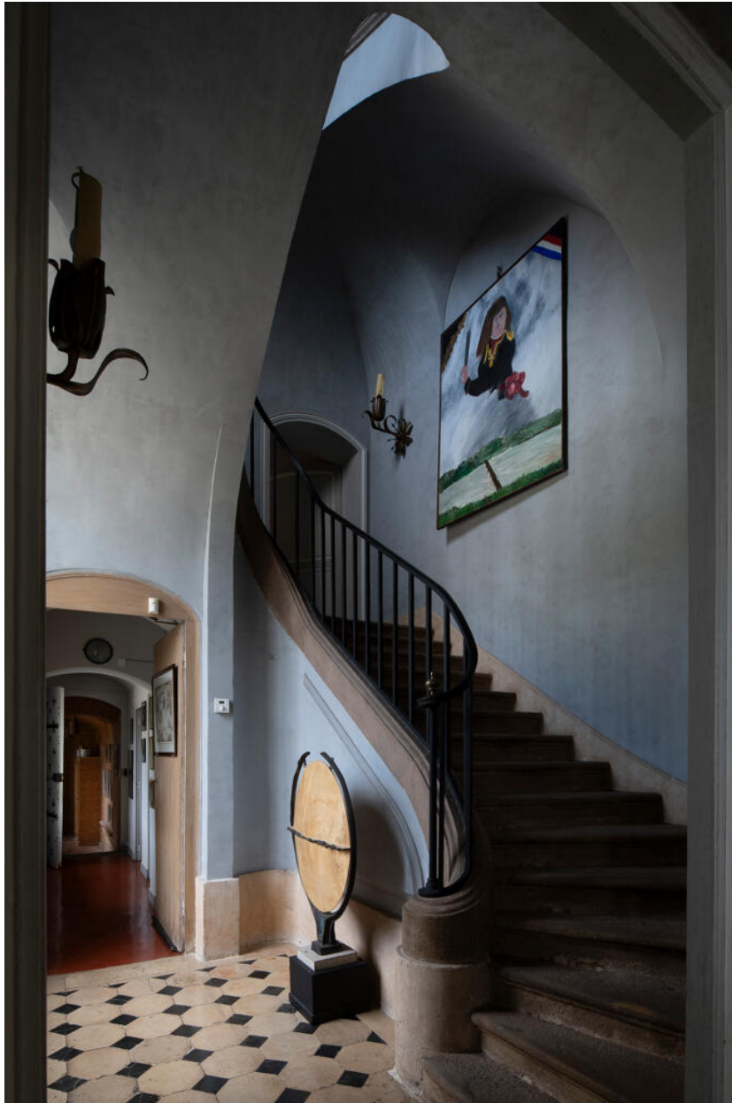
Départ de l'escalier d'honneur en pierre de taille, de fond en comble.
