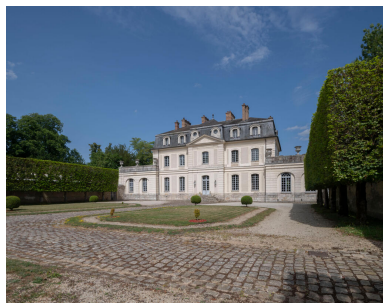
Façade sur cour. Phot. Ayrault Philippe IVR11_20237700938NUC4A
