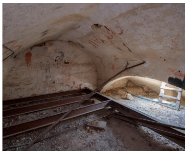
Charpente en maçonnerie de moellon et brique. Phot. Ayrault Philippe IVR11_20237700955NUC4A
