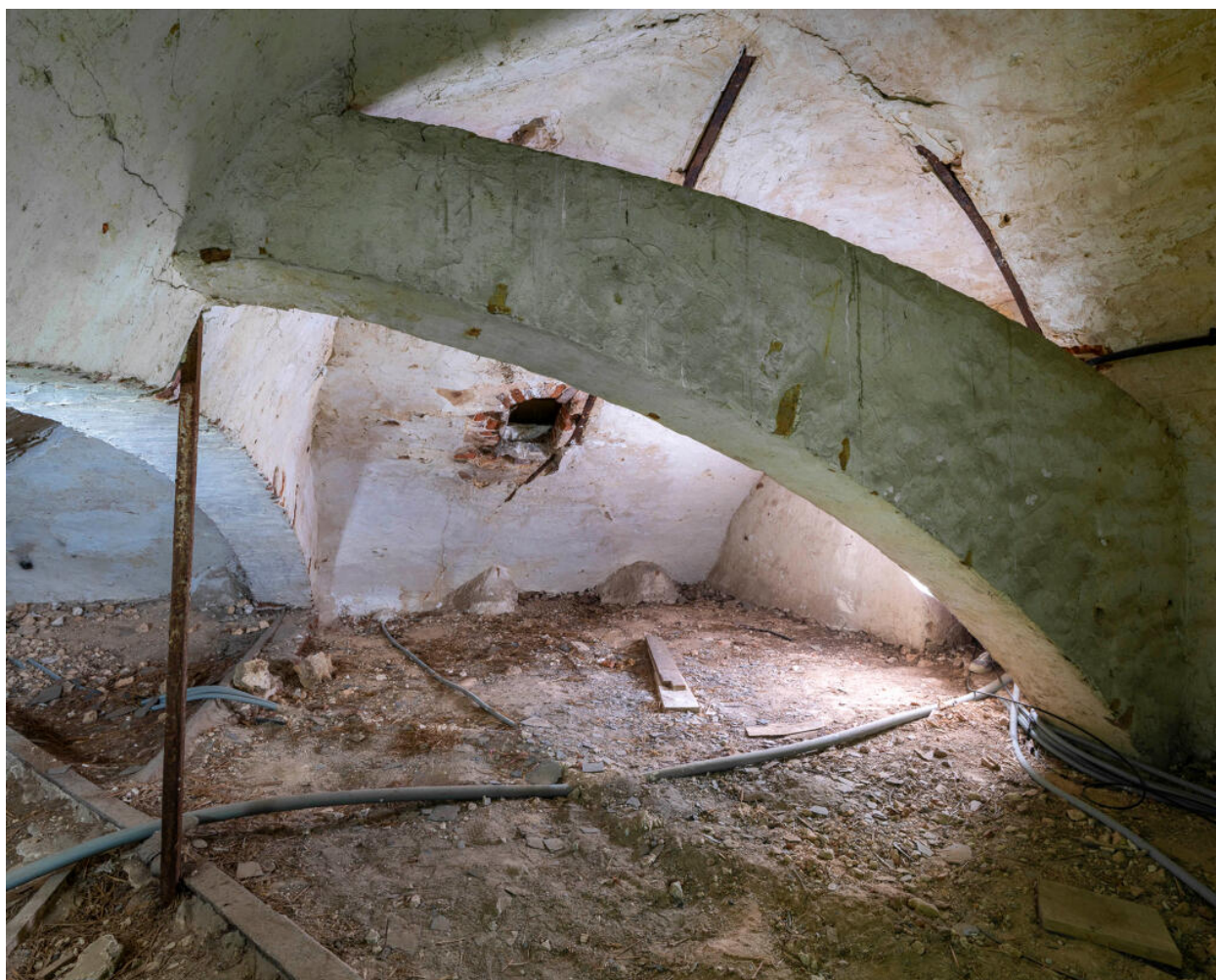
Charpente en maçonnerie de moellon et brique.
