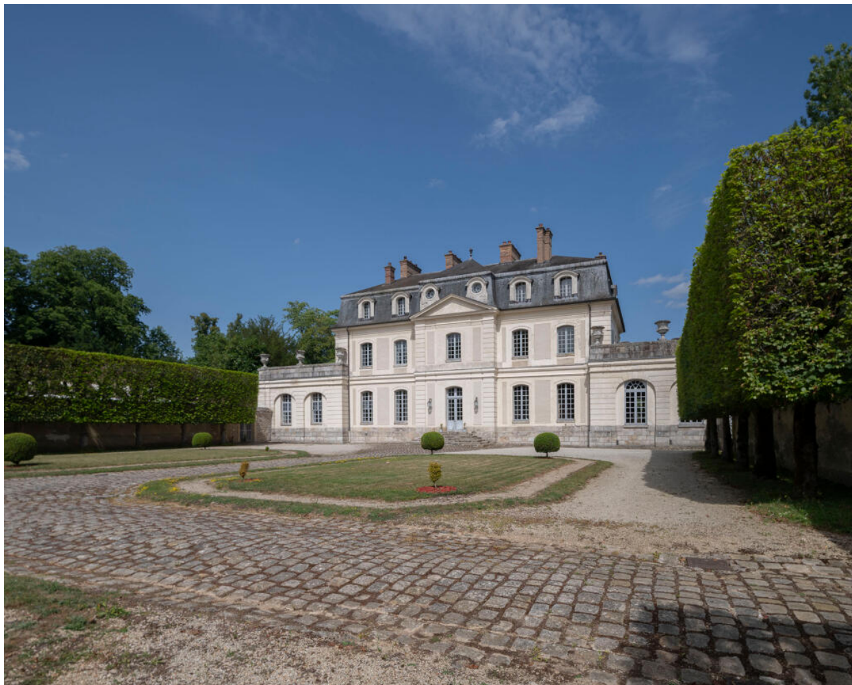
Façade sur cour.
