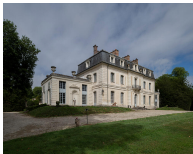
Façade sur jardin. Phot. Ayrault Philippe IVR11_20237700936NUC4A
