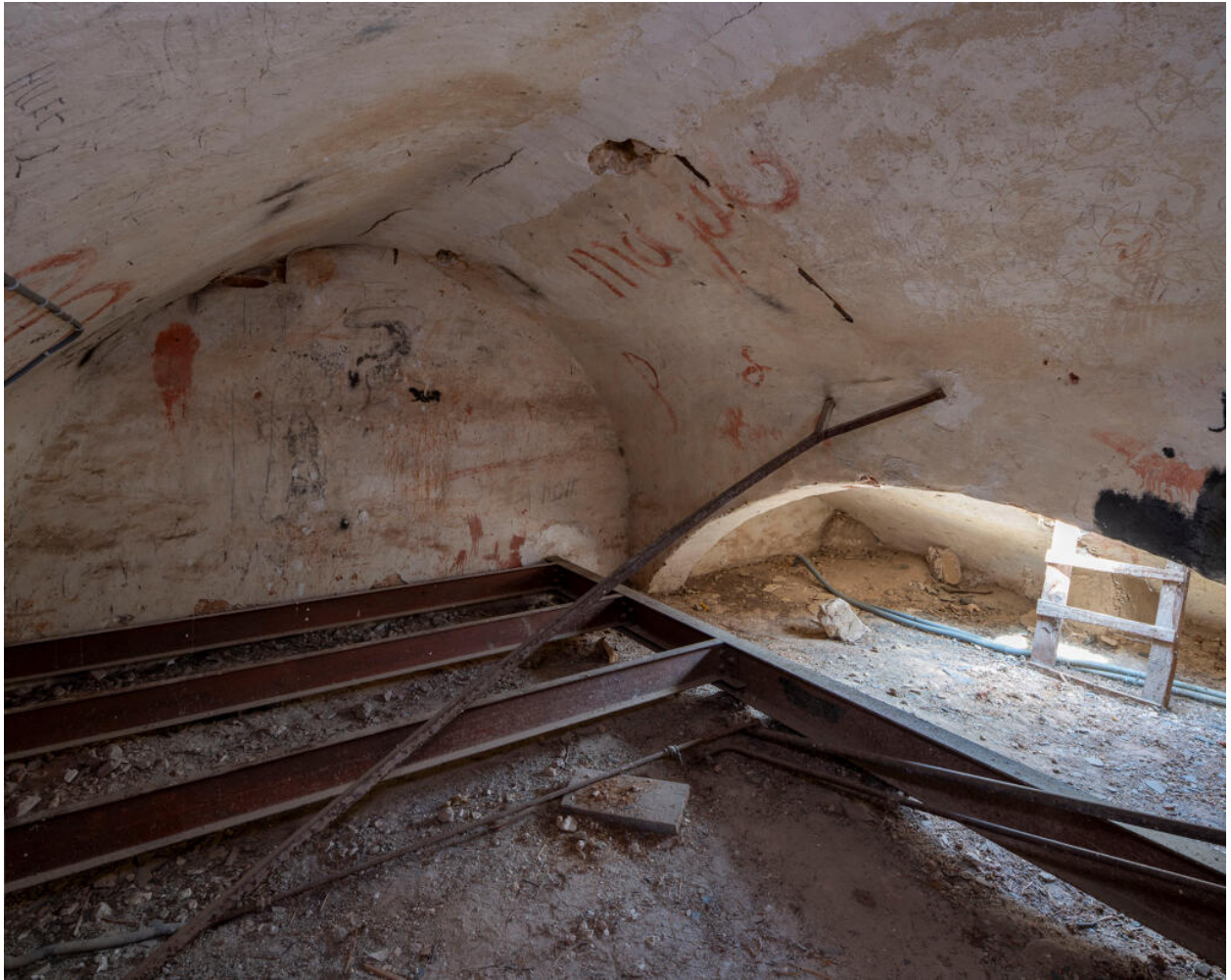
Charpente en maçonnerie de moellon et brique.
