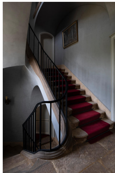
L'escalier d'honneur, au premier étage. Le palier est en pierre de taille, comme tous les plafonds de l'édifice. Phot. Ayrault Philippe IVR11_20237700948NUC4A
