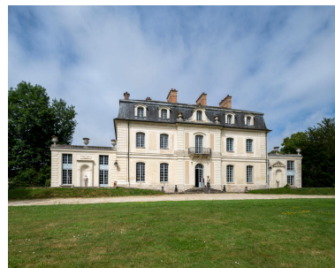
Façade sur jardin. Phot. Ayrault Philippe IVR11_20237700935NUC4A
