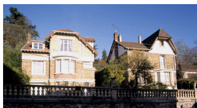
Maisons aux n° 10-12, boulevard Aristide-Briand, édifiées en surplomb de la voirie. Celle de droite date de 1936 (AM Melun, 1 Fi 1267). Phot. Stéphane Asseline IVR11_20027700878XA
