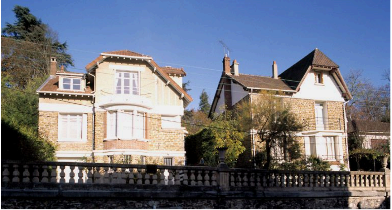
Maisons aux n° 10-12, boulevard Aristide-Briand, édifiées en surplomb de la voirie. Celle de droite date de 1936 (AM Melun, 1 Fi 1267).
