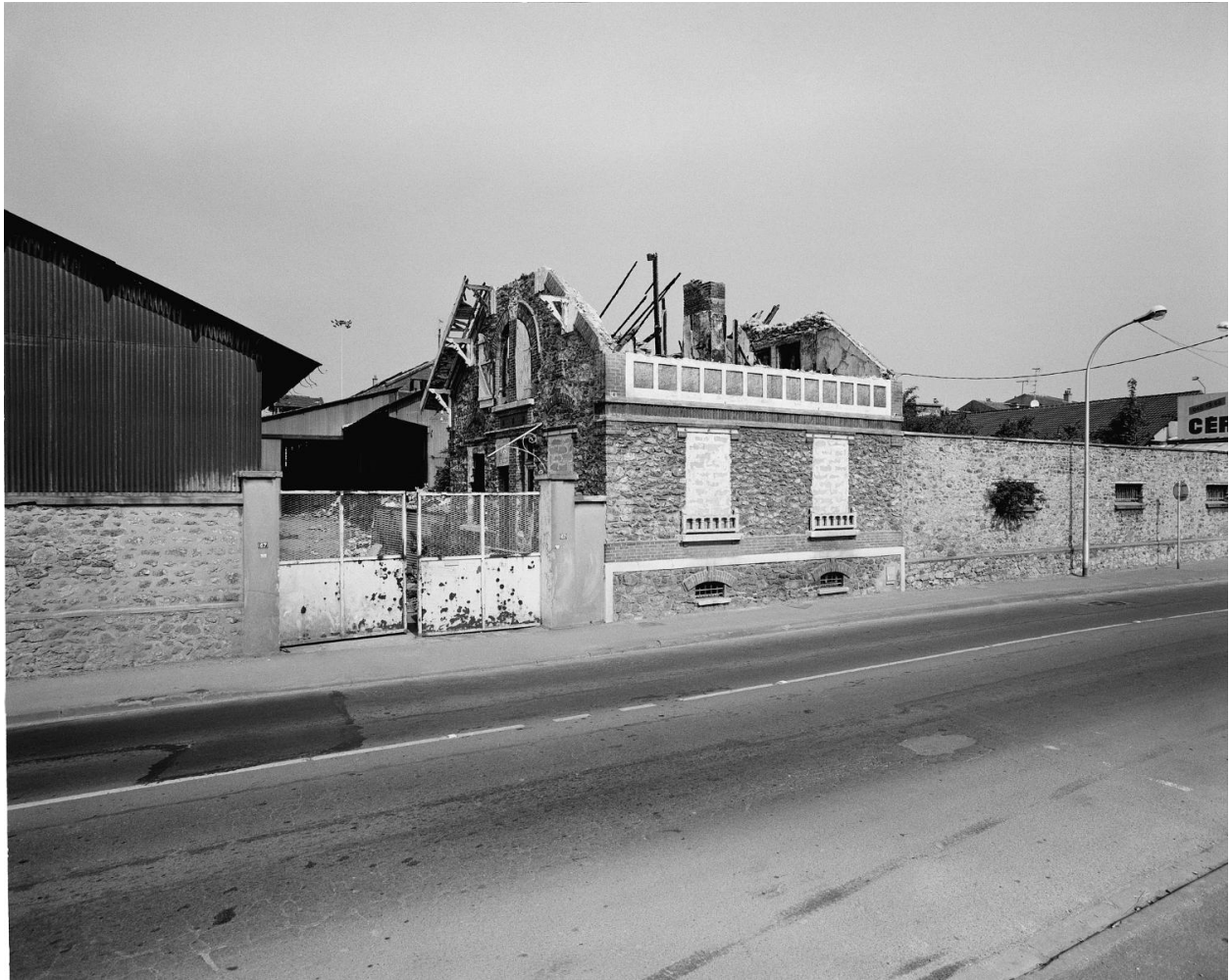
Usine en cours de démolition, située à la limite d'Athis-Mons et de Juvisy : vue d'ensemble des façades donnant sur le quai.
