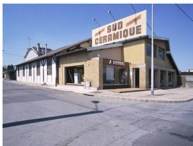
Vue d'ensemble du hangar et du bâtiment de vente de la société Sud Céramique (3, quai de l'Industrie). Phot. Philippe Ayrault IVR11_20039100950XA
