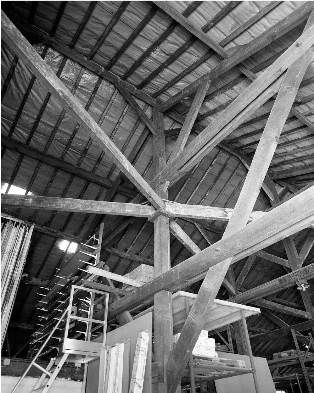
Hangar de la société Sud Céramique (3, quai de l'Industrie) : vue de la charpente.
