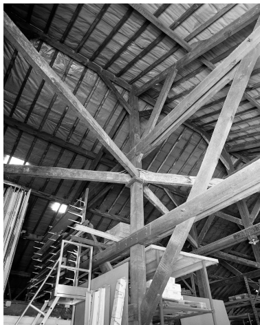
Hangar de la société Sud Céramique (3, quai de l'Industrie) : vue de la charpente. Phot. Philippe Ayrault IVR11_20039100953X
