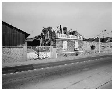
Usine en cours de démolition, située à la limite d'Athis-Mons et de Juvisy : vue d'ensemble des façades donnant sur le quai. Phot. Philippe Ayrault IVR11_20039100835X
