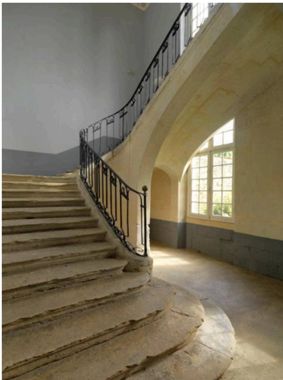
L'escalier d'honneur placé à droite de l'entrée principale de la façade antérieure.
