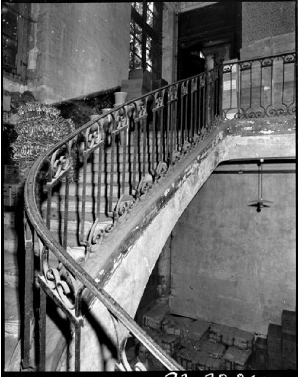
La deuxième volée de l'escalier desservant le premier étage.
