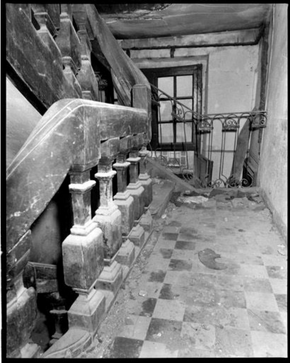
Escalier secondaire à rampe de balustres en bois.
