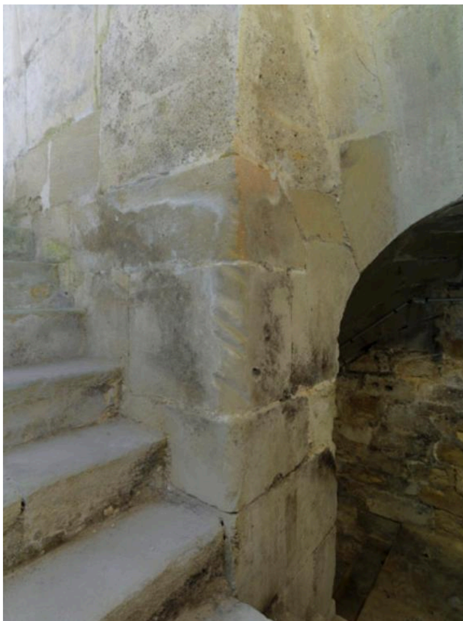
Premier demi-palier de la descente de cave. On distingue l'usure faite par les cordes à l'angle du mur.
