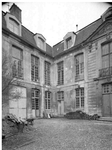
La jonction entre l'aile et le corps principal. On aperçoit
