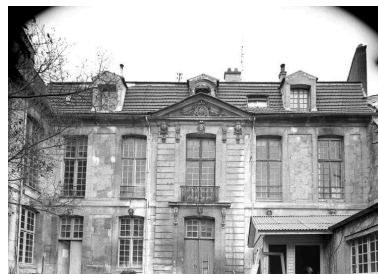
La façade principale en cours de travaux. (Fonds Bertin). Phot. Bertin IVR11_20177800679NUC2B
