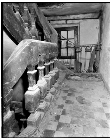
Escalier secondaire à rampe de balustres en bois. Phot. Pascal Corbière IVR11_19777800707X
