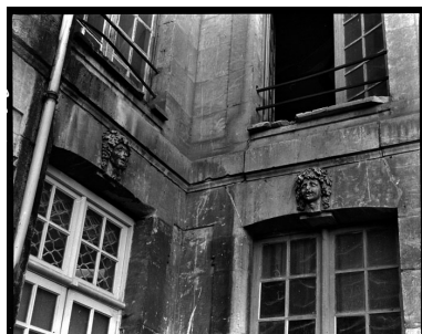
Angle du bâtiment avant la restauration. Phot. Pascal Corbière IVR11_19777800709X
