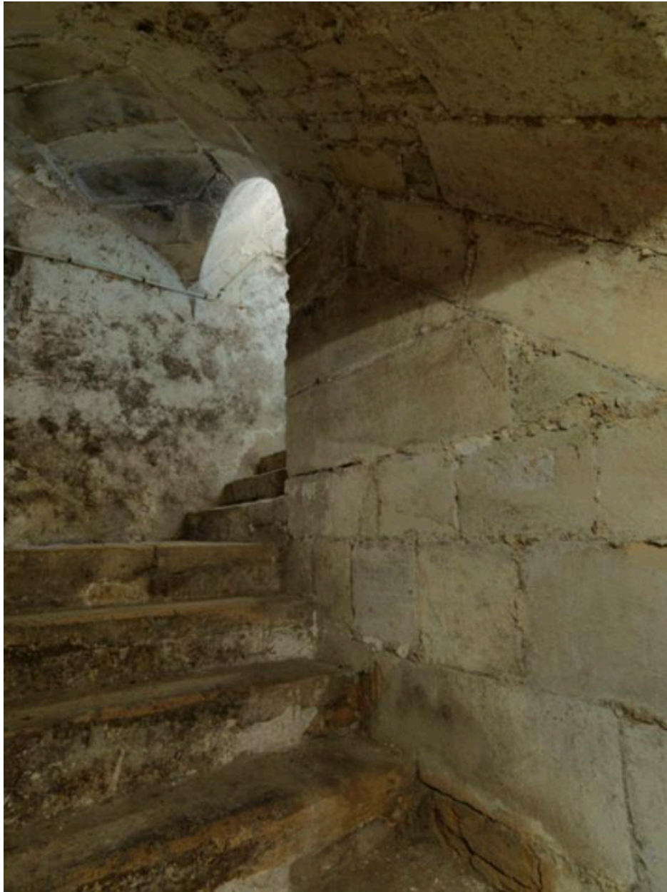
Deuxième volée de l'escalier de la cave composée de 7 marches.
