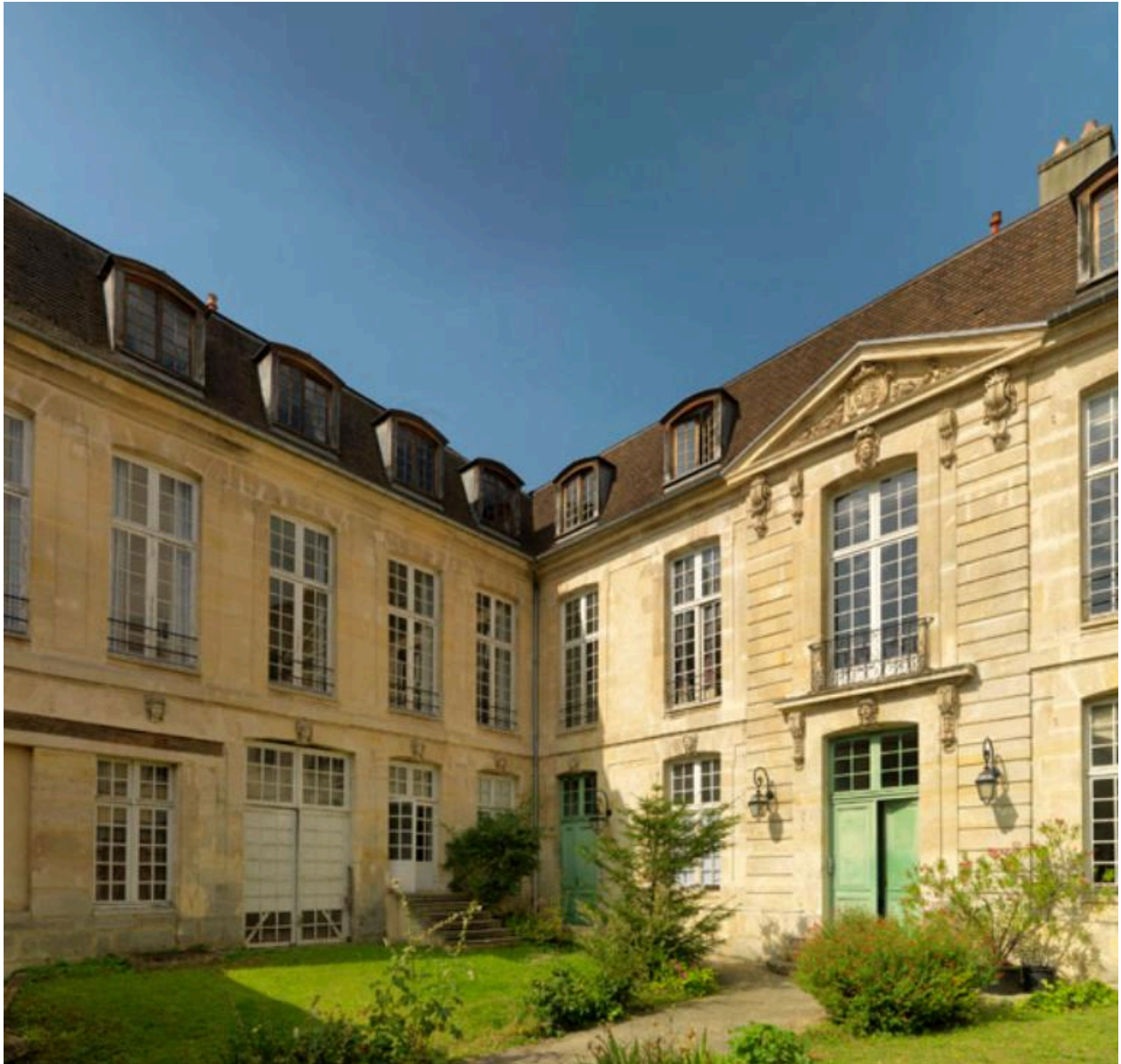
L'aile en retour de la façade sur cour.
