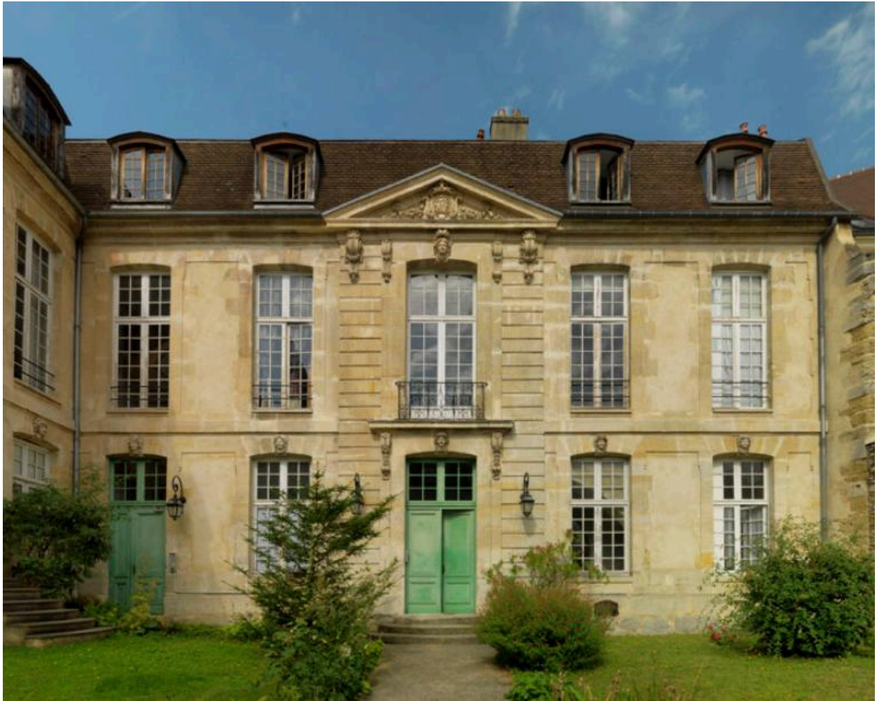
Vue de la façade sur cour.
