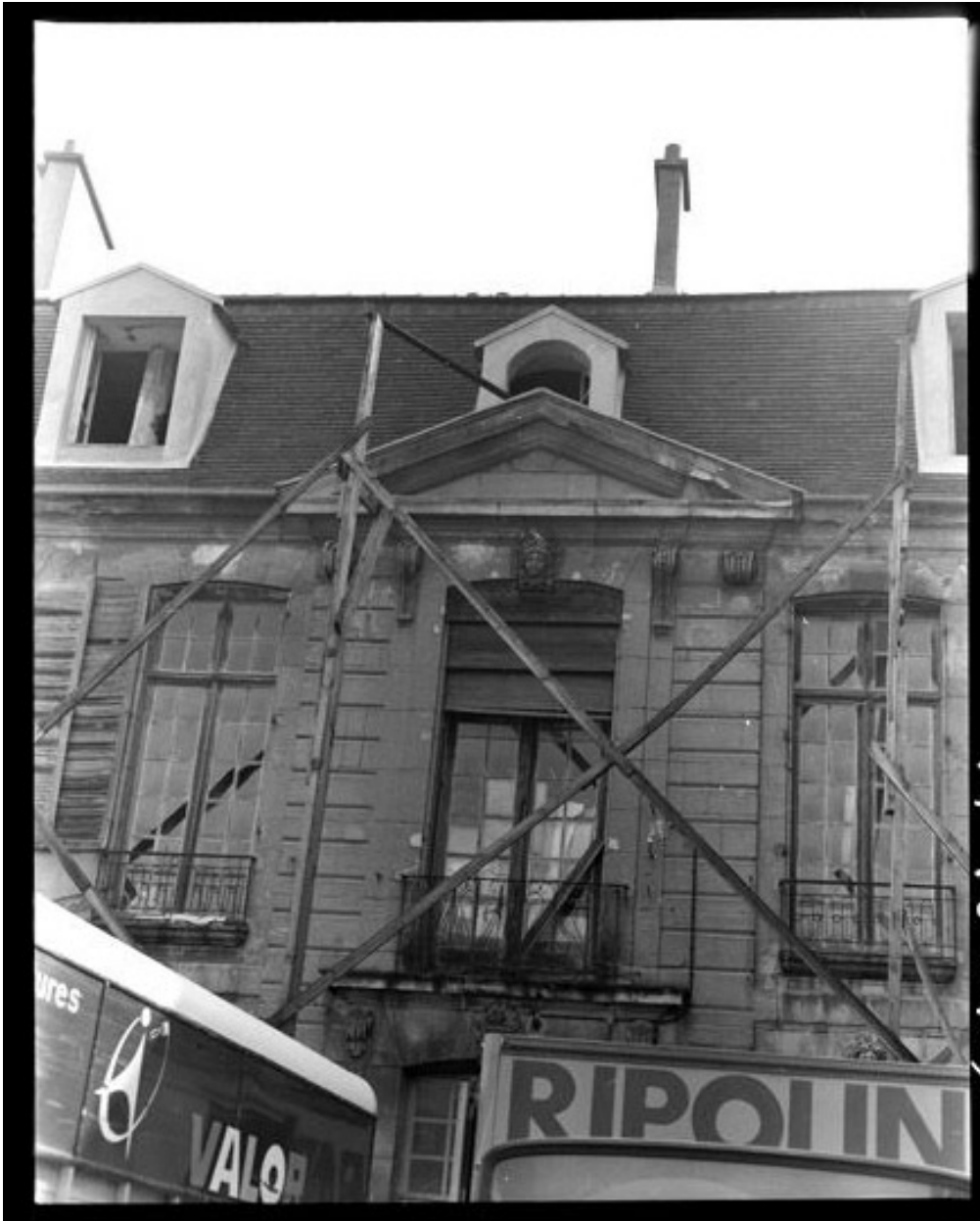
Vue de la façade sur cour alors en travaux.
