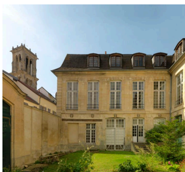
L'aile en retour de la façade antérieure comportait des remises au rez-de-chaussée. Phot. Laurent Kruszyk IVR11_20177800832NUC4A
