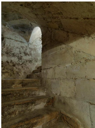
Deuxième volée de l'escalier de la cave composée de 7 marches. Phot. Laurent Kruszyk IVR11_20177800838NUC4A
