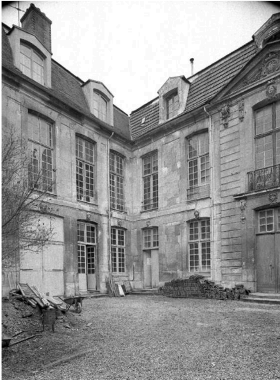
La jonction entre l'aile et le corps principal. On aperçoit l'entrée qui mène à l'escalier secondaire.(Fonds Bertin).
