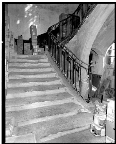
Le départ de l'escalier principal avant restauration. Le garde-corps est en ferronnerie. Phot. Pascal Corbière IVR11_19777800842X
