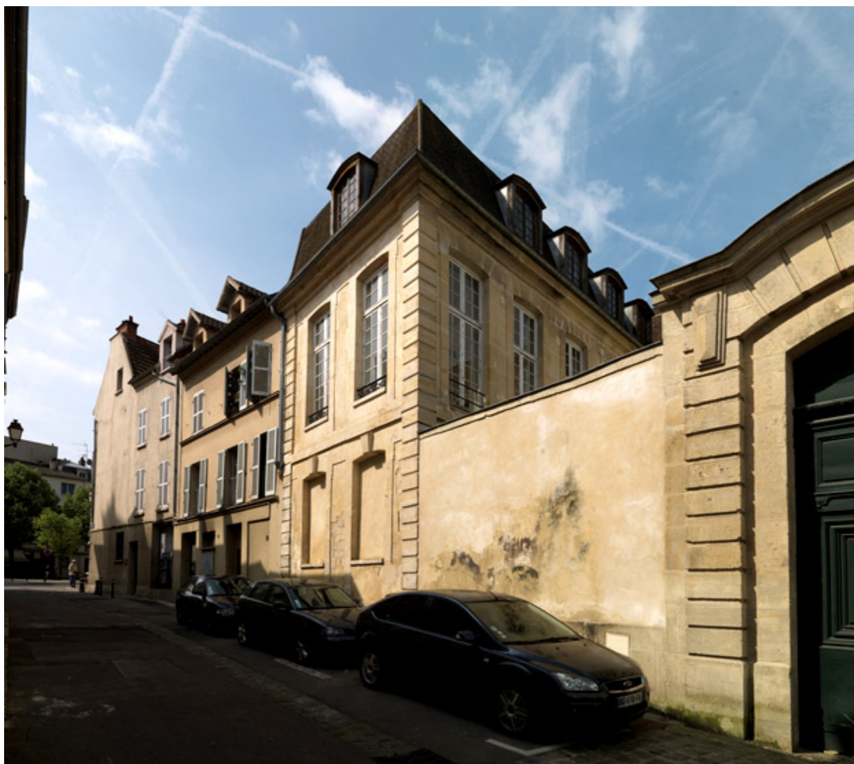
L'aile en retour sur la rue Baudin.
