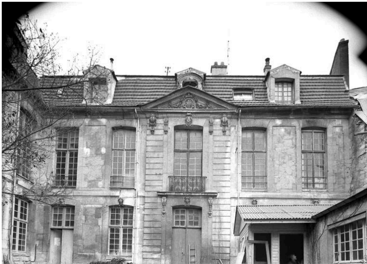
La façade principale en cours de travaux. (Fonds Bertin).
