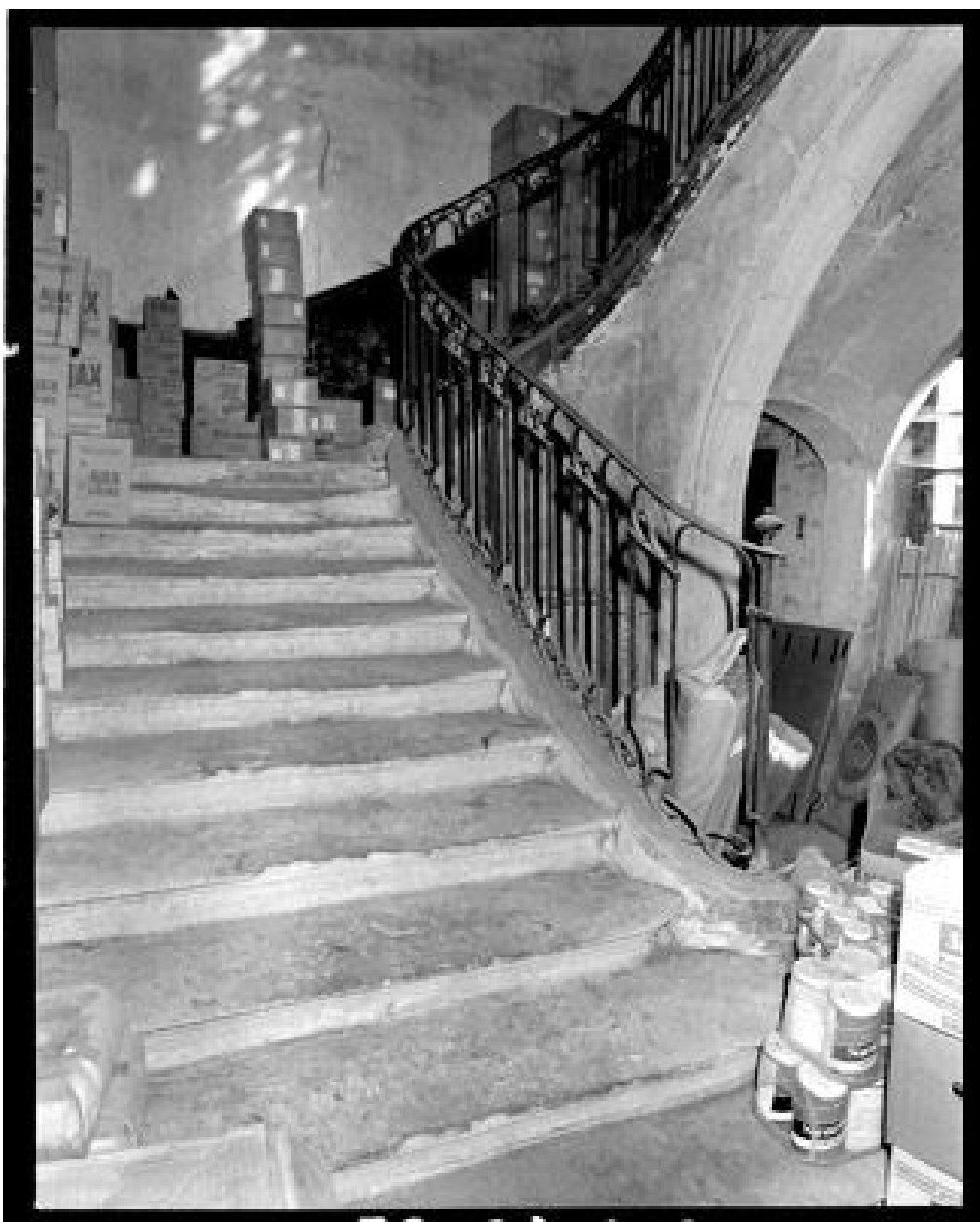
Le départ de l'escalier principal avant restauration. Le garde-corps est en ferronnerie.
