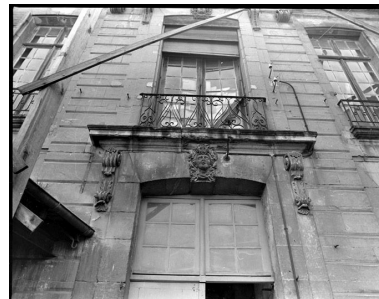
Détail d'une travée alors en restauration. Phot. Pascal Corbière IVR11_19777800844X
