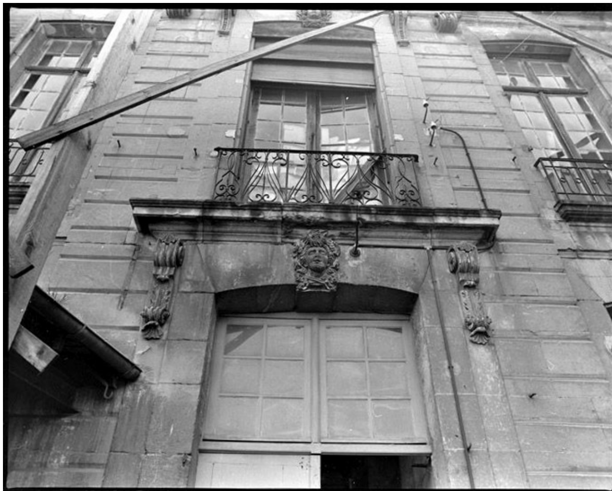
Détail d'une travée alors en restauration.
