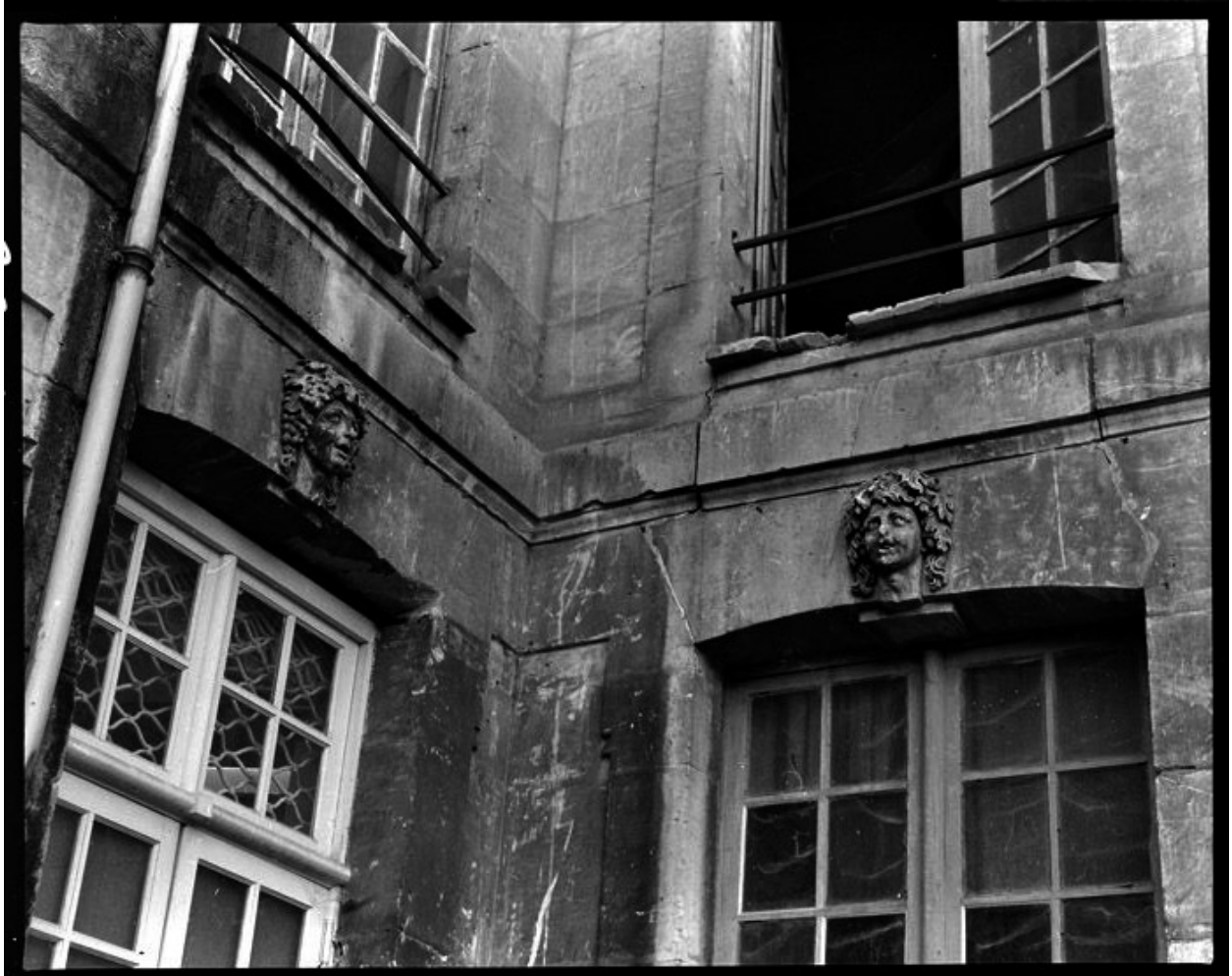
Angle du bâtiment avant la restauration.
