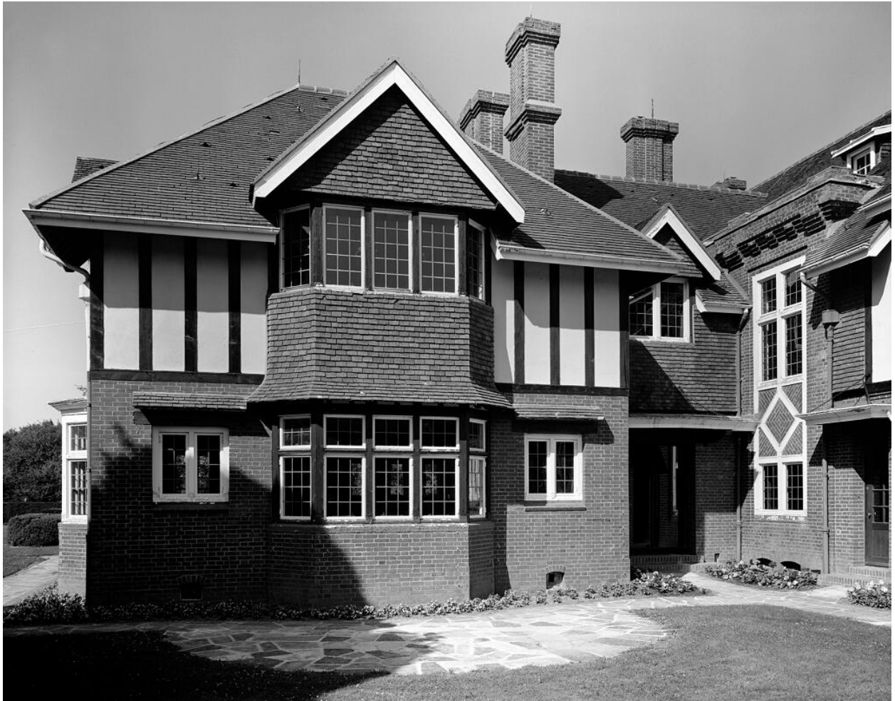
Vue du côté Nord-Ouest.
