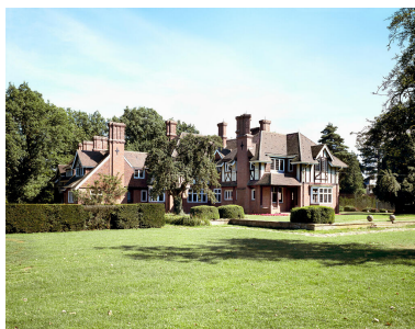
Vue générale depuis le jardin. Phot. Décamps Christian IVR11_19879200767VA
