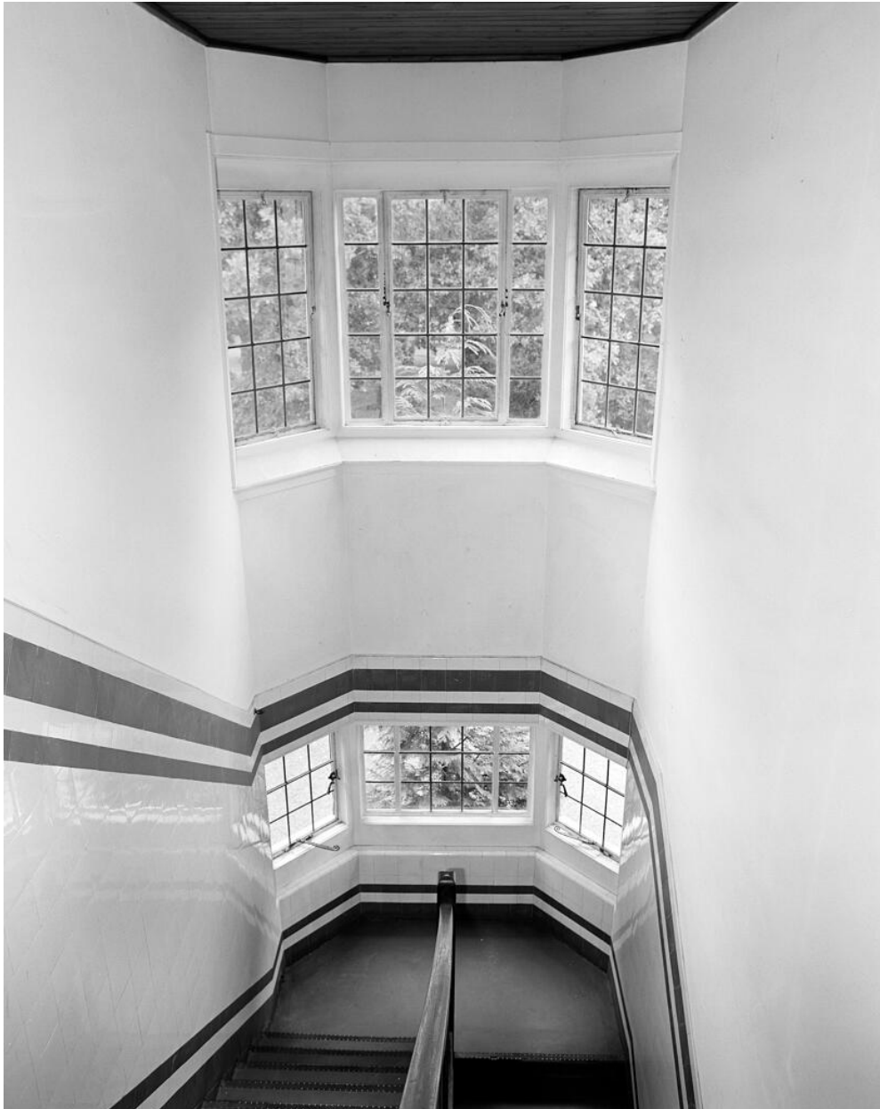
Vue de l'escalier de service.
