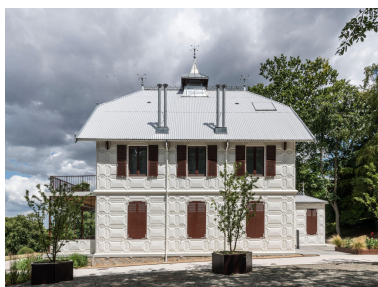
Façade latérale ouest. Phot. Laurent Kruszyk IVR11_20227800349NUC4A
