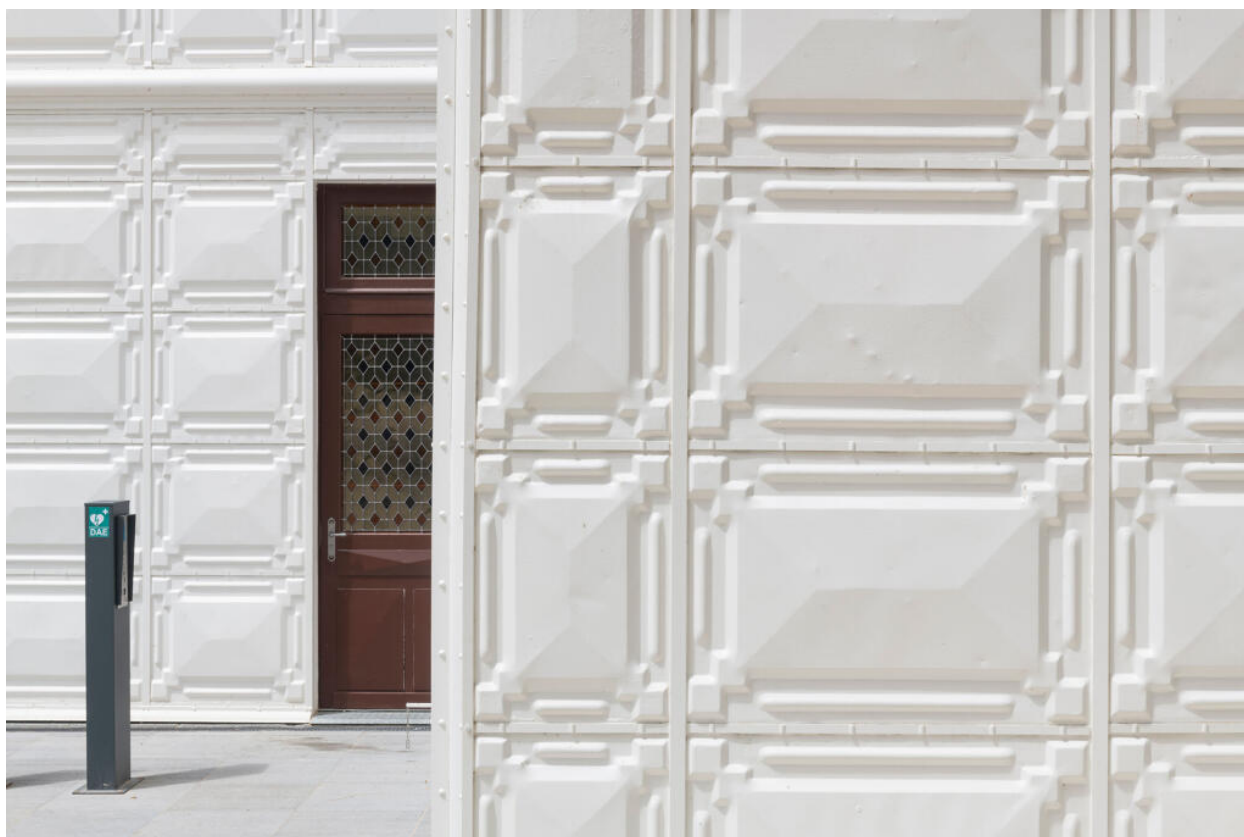
Détail des façades sud. La porte d'entrée.
