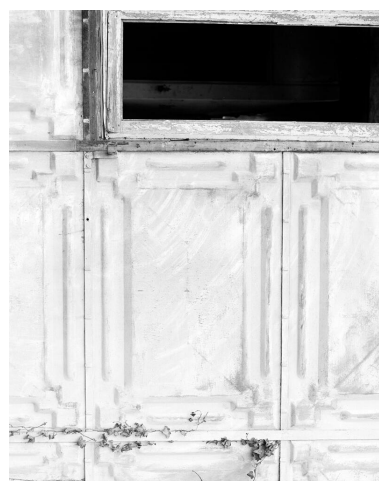
Détail d'un des panneaux métalliques constituant la façade (état en 1991). Phot. Vialles Jean-Bernard IVR11_19917800455X
