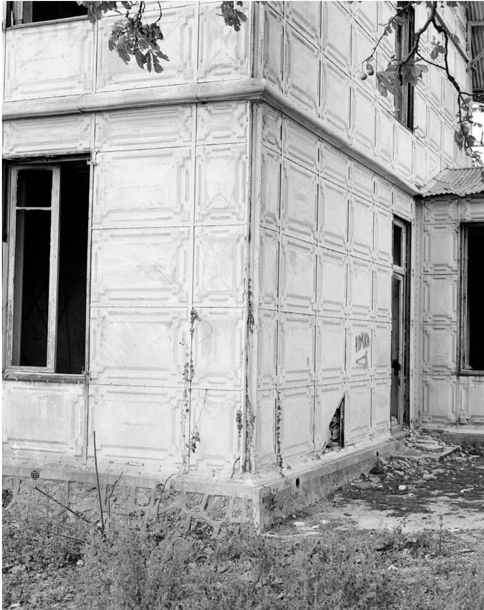
Détail du traitement d'angle (état en 1991).
