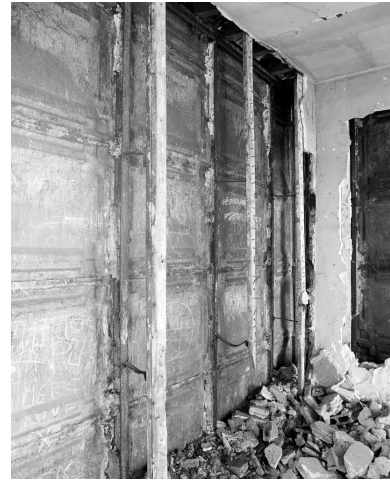
Vue intérieure des panneaux de la structure métallique (état en 1991). Phot. Vialles Jean-Bernard IVR11_19917800458X
