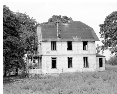
Vue d'ensemble d'une façade latérale (état en 1991). Phot. Vialles Jean-Bernard IVR11_19917800452X
