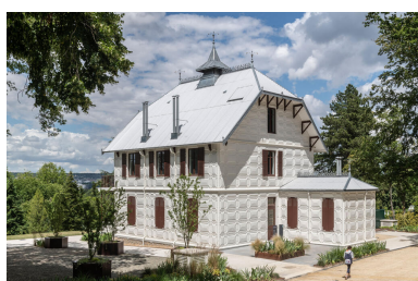
Angle sud-ouest de la maison. La façade d'entrée est augmentée d'une petite pièce en appendice. Phot. Laurent Kruszyk IVR11_20227800348NUC4A
