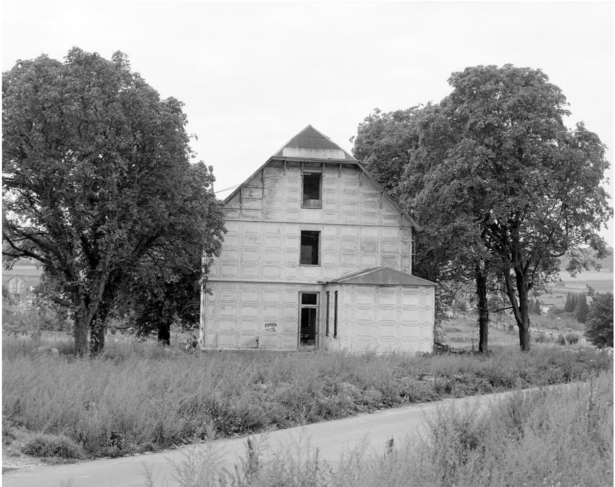
Vue d'ensemble de la façade d'entrée (état en 1991).
