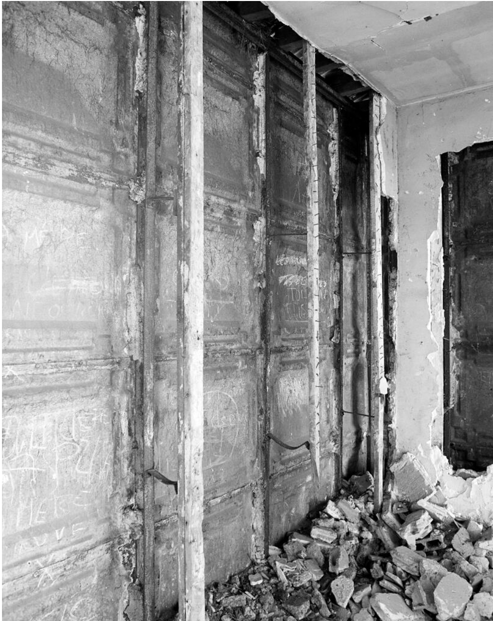
Vue intérieure des panneaux de la structure métallique (état en 1991).
