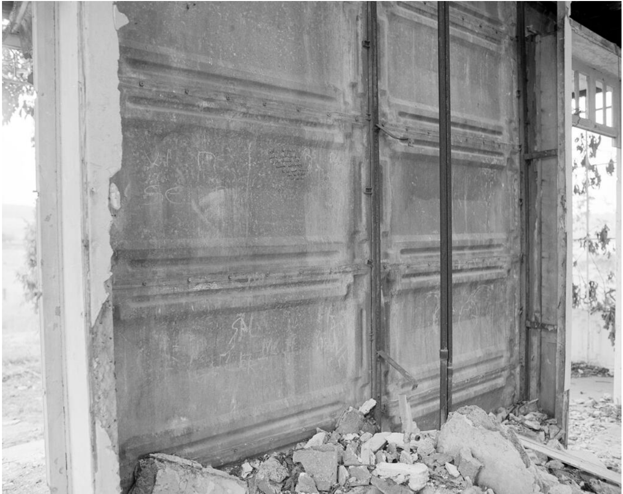
Détail des panneaux métalliques depuis l'intérieur (état en 1991).
