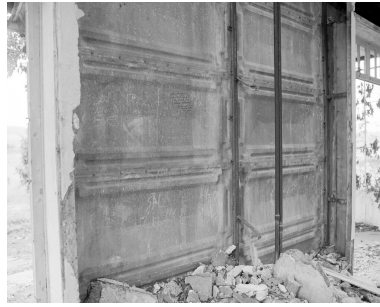
Détail des panneaux métalliques depuis l'intérieur (état en 1991). Phot. Vialles Jean-Bernard IVR11_19917800457X
