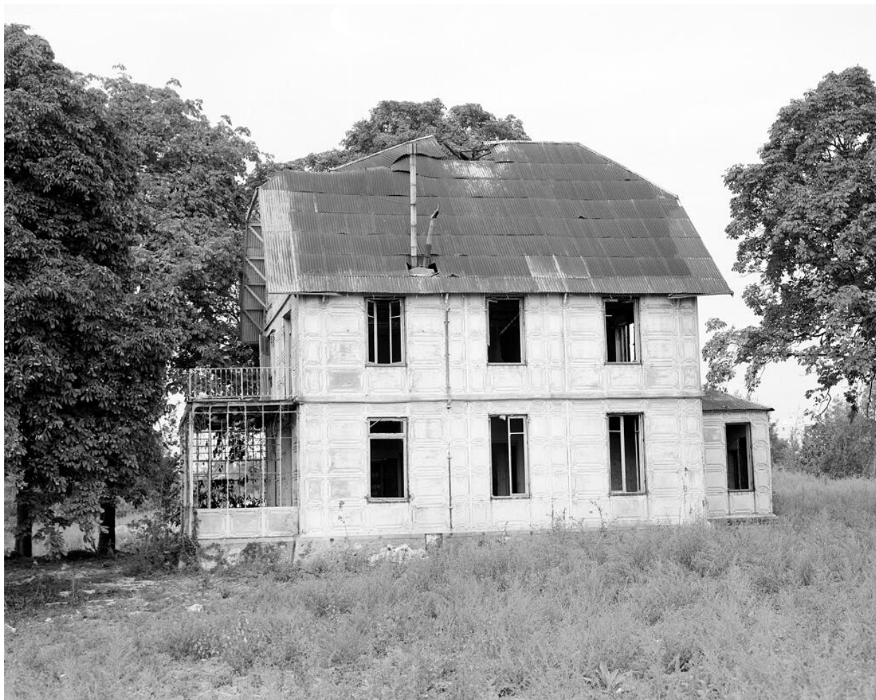
Vue d'ensemble d'une façade latérale (état en 1991).
