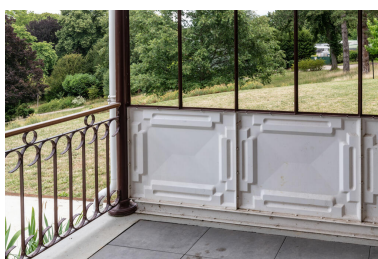
Détail des panneaux de fer de la terrasse, ici non doublés. Phot. Laurent Kruszyk IVR11_20227800351NUC4A
