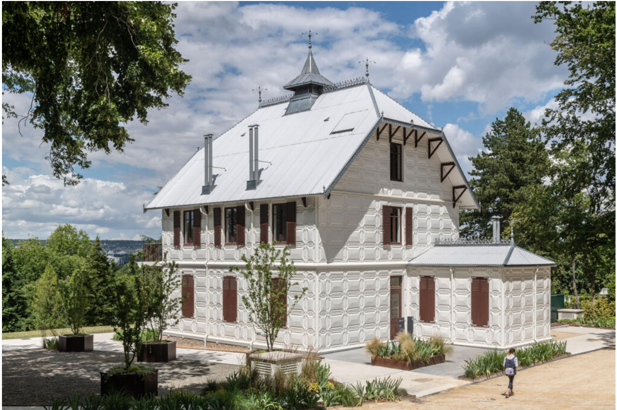
Angle sud-ouest de la maison. La façade d'entrée est augmentée d'une petite pièce en appendice.
