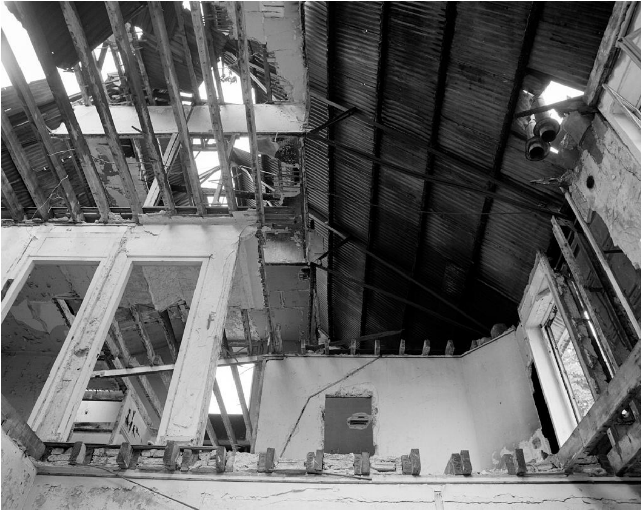
Vue intérieure des vestiges des différents niveaux (état en 1991).
