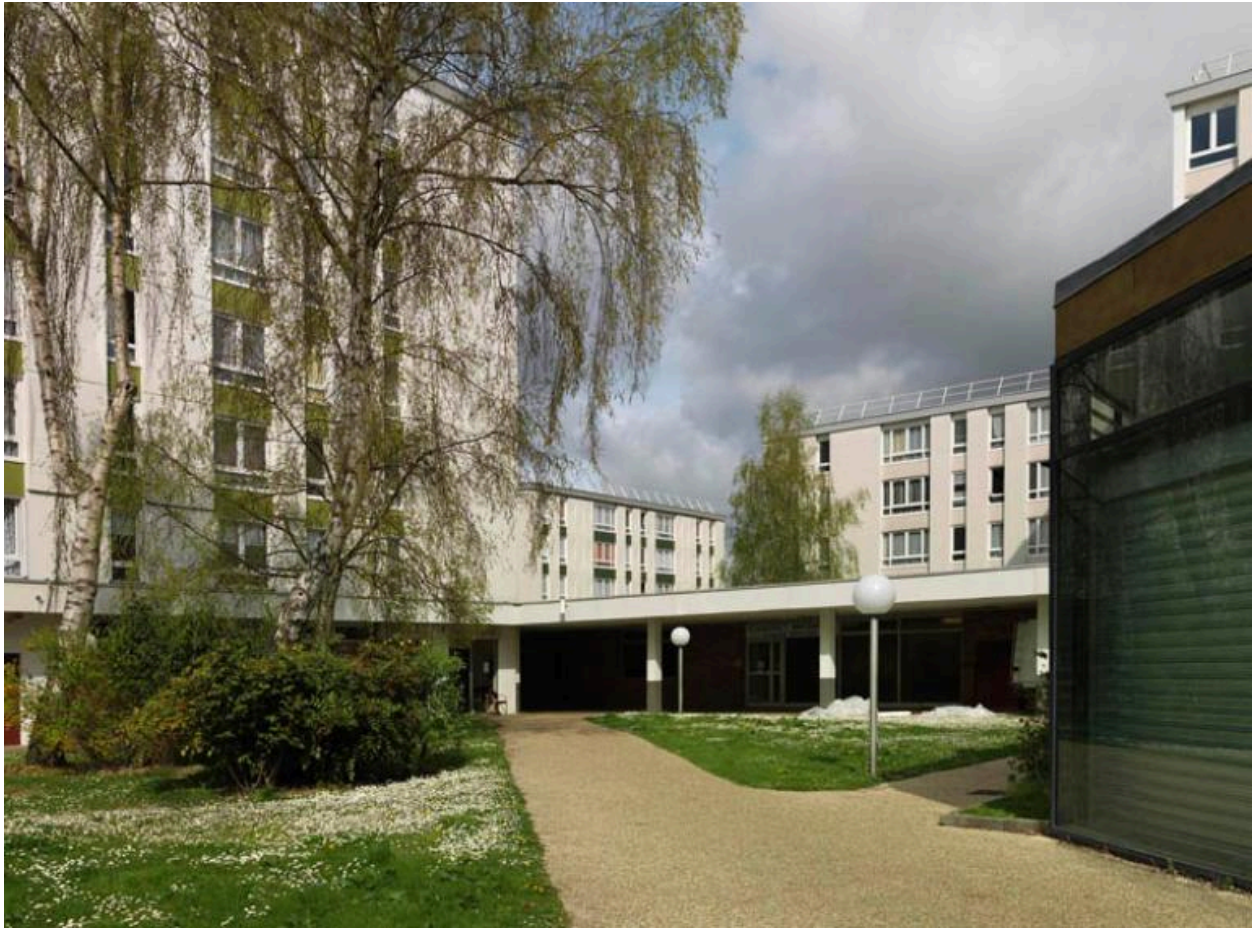
Le patio intérieur du centre commercial.
