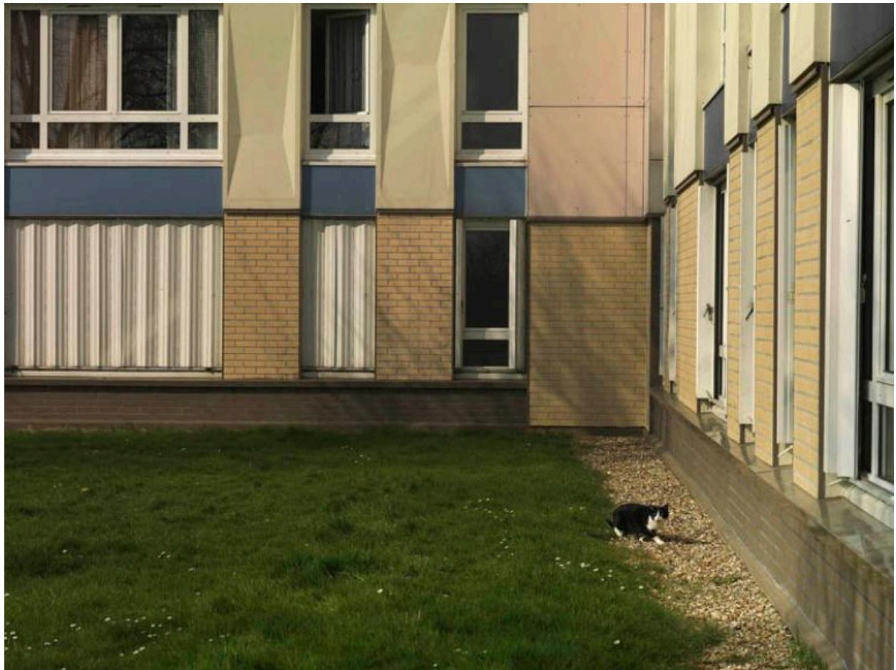
Façade et soubassement d'un immeuble après rénovation.
