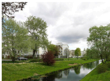
La rigole de Guyancourt. Phot. Philippe Ayrault IVR11_20147800110NUC4A
