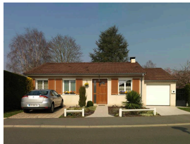
Maison de type "Villandry", avec le garage rejeté latéralement. Phot. Philippe Ayrault IVR11_20147800163NUC4A
