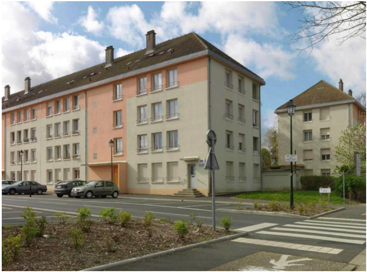
Vue générale, depuis la rue Jean Maillier, de l'ensemble de logements collectifs du square Ernest Defay, opération réalisée en 1968, ayant précédé la création du quartier du Pont-du-Routoir.
