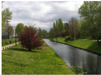
Vue générale de la rigole de Guyancourt, dans sa partie canalisée traversant le quartier du Pont-du-Routoir. Phot. Philippe Ayrault IVR11_20147800107NUC4A
