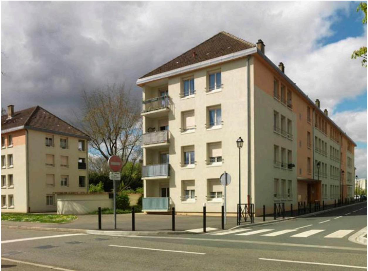
Les immeubles du square Ernest Defay.
