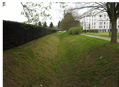
En surface, le tracé des ouvrages de régulation créés pour le bassin du Château est parfaitement lisible. Phot. Philippe Ayrault IVR11_20147800112NUC4A
