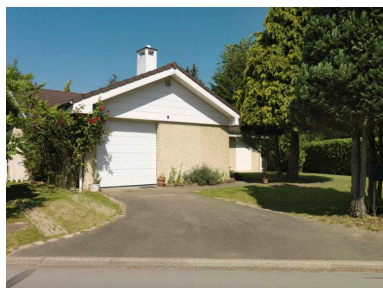
Une maison de type "Alice" dans le lotissement des Belles au Bois
