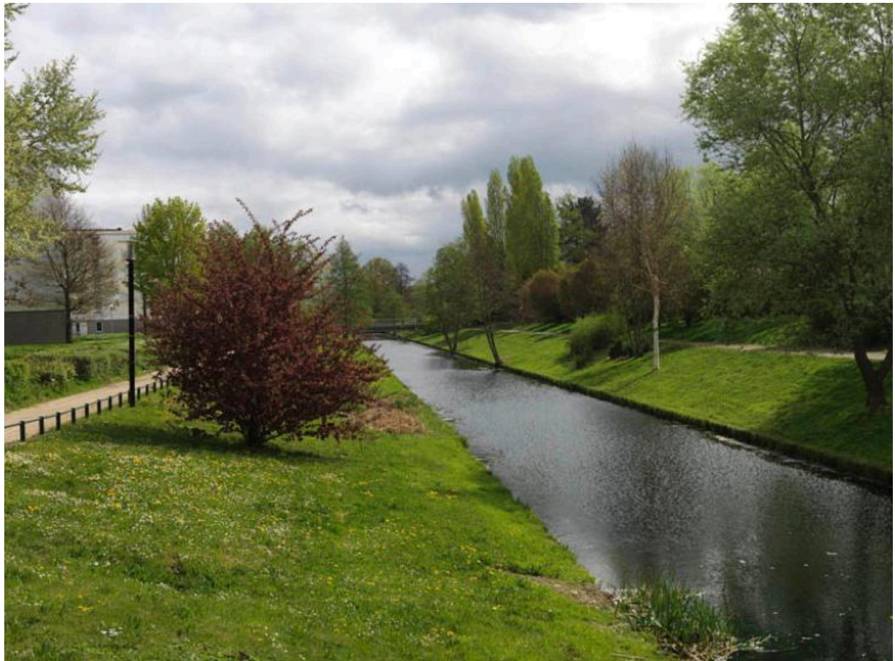
Vue générale de la rigole de Guyancourt, dans sa partie canalisée traversant le quartier du Pont-du-Routoir.
