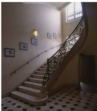
Vue d'ensemble de l'escalier situé à droite du vestibule. Phot. Philippe Ayrault IVR11_20079100918XA
