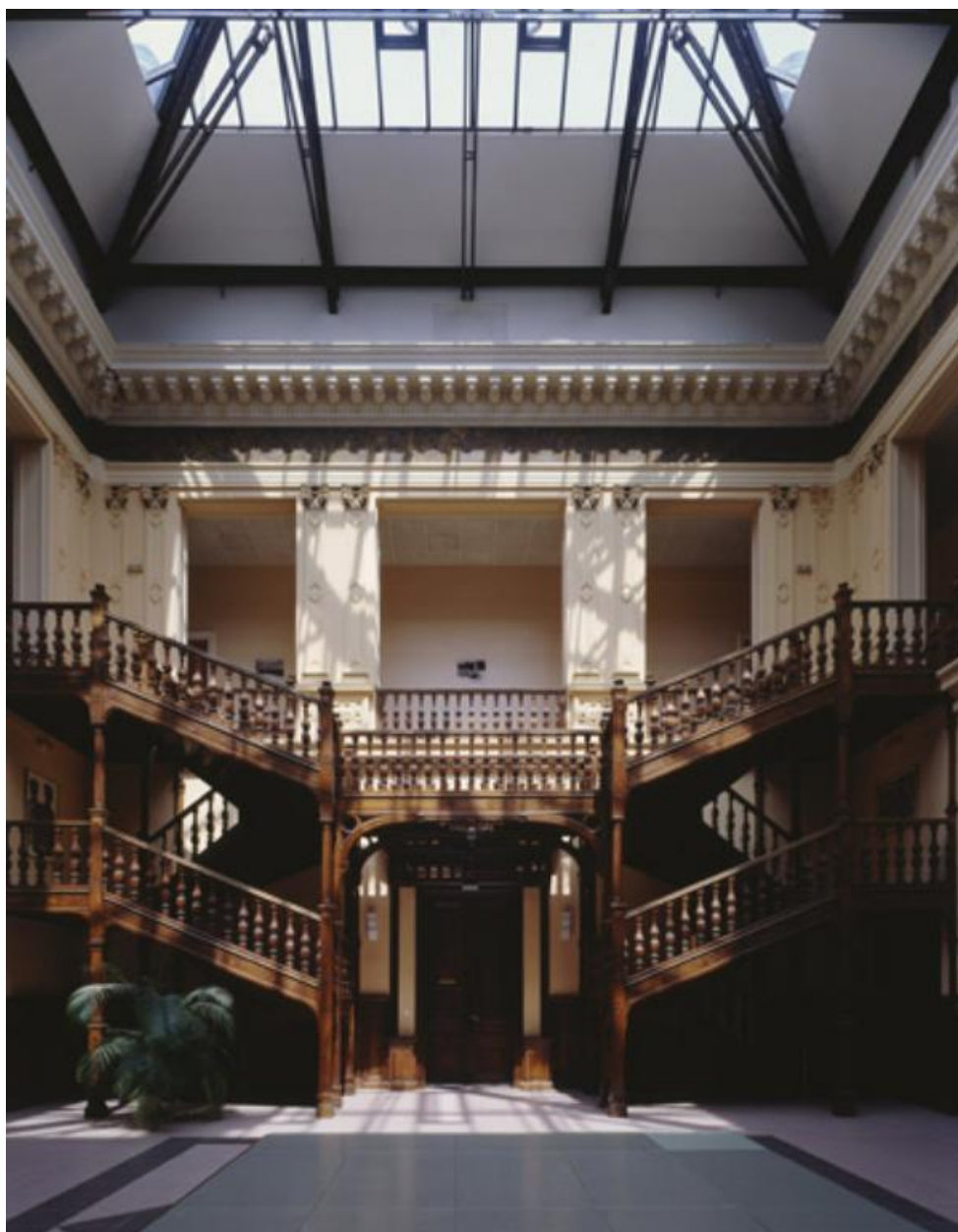
Le hall central : l'escalier en charpente, à double volée symétrique, conduisant à l'étage du hall.
