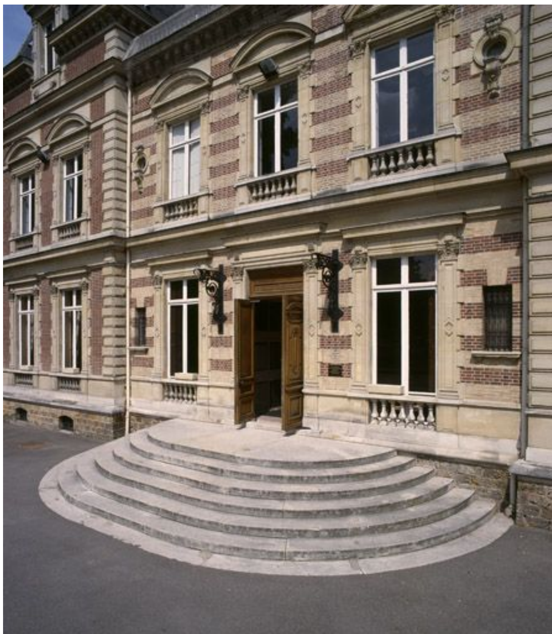
Détail du corps central et de son escalier.
