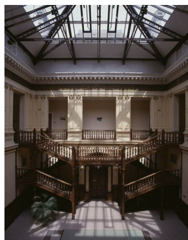
Le hall central : l'escalier en charpente, à double volée symétrique, conduisant à l'étage du hall. Phot. Philippe Ayrault IVR11_20079100929XA
