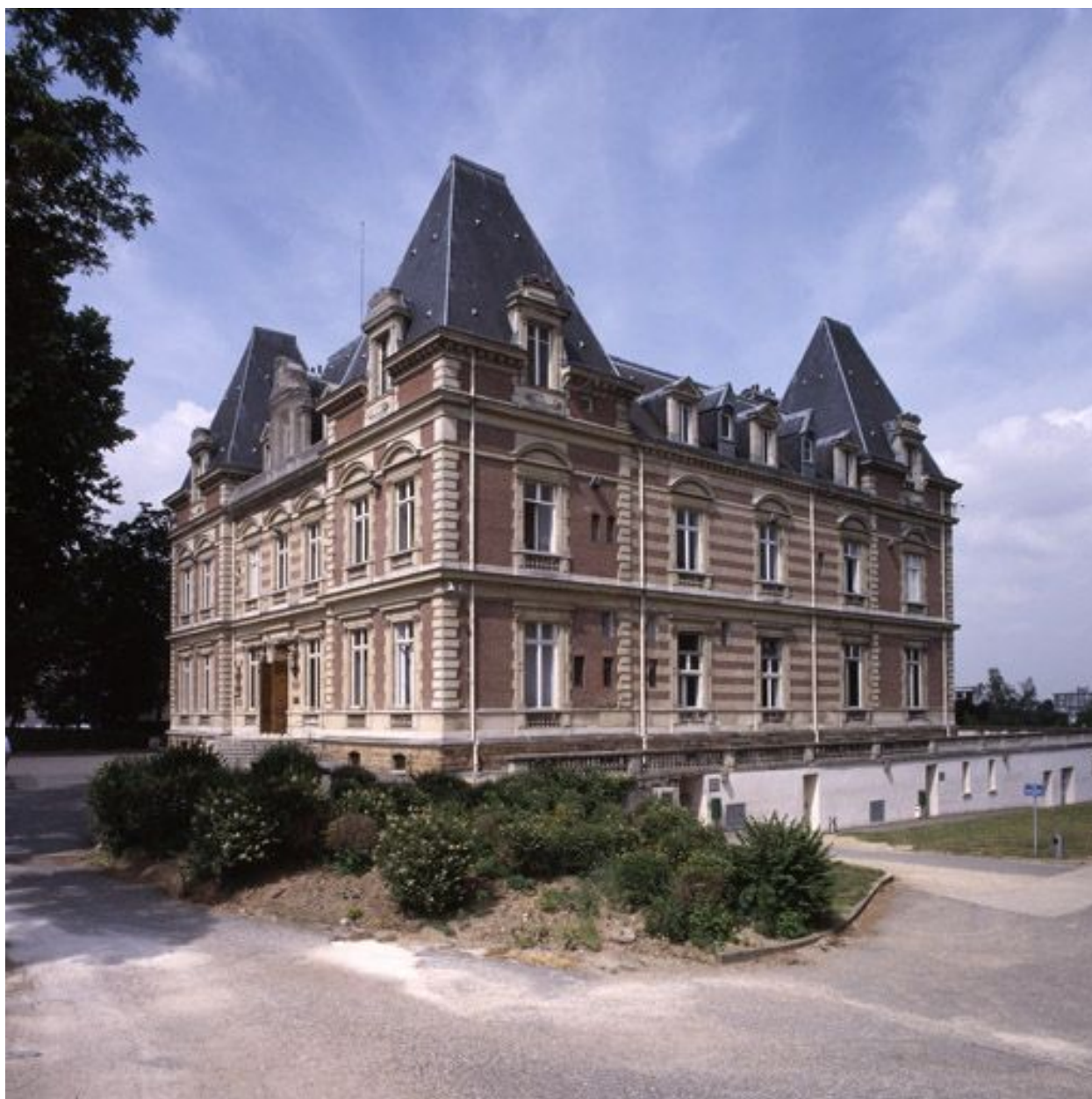
Façades antérieure et latérale est.
