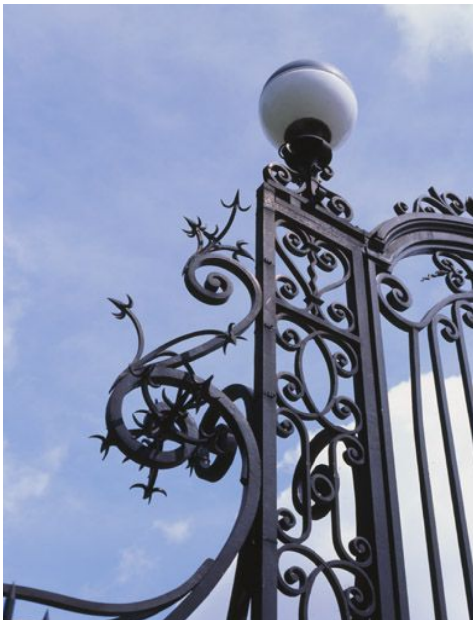
Détail de la grille d'entrée.
