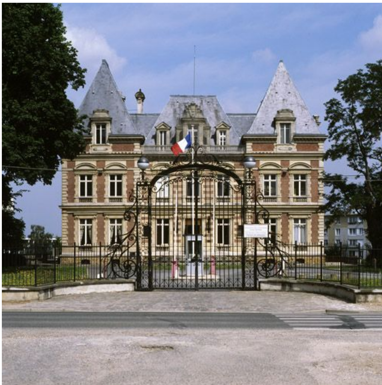
Vue d'ensemble derrière la grille d'entrée.
