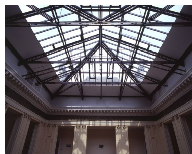
Détail de la corniche et de la charpente métallique supportant la verrière. Phot. Philippe Ayrault IVR11_20079100935XA
