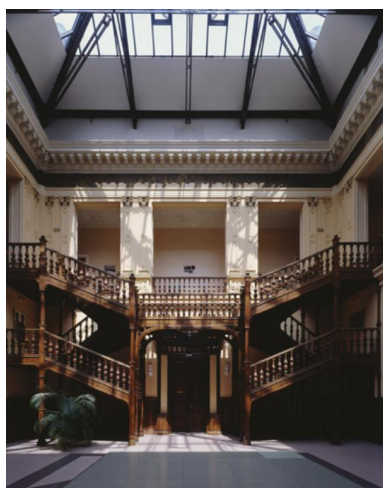
Le hall central : l'escalier en charpente, à double volée symétrique, conduisant à l'étage du hall. Phot. Philippe Ayrault IVR11_20079100931VA
