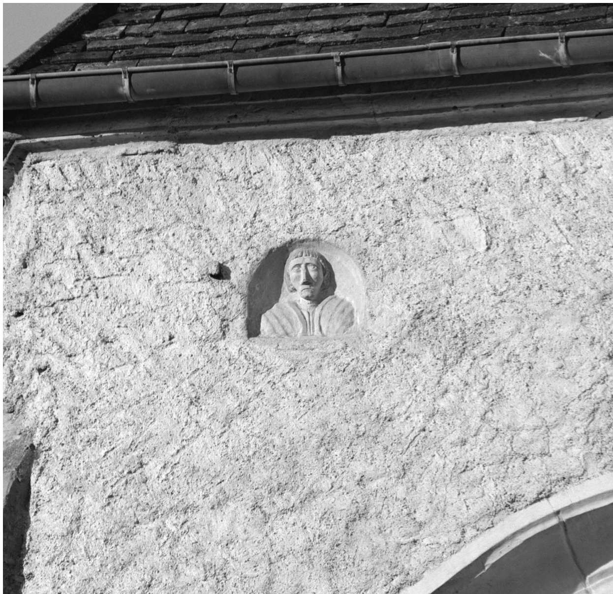
Détail d'un buste ornant la façade nord du chevet
