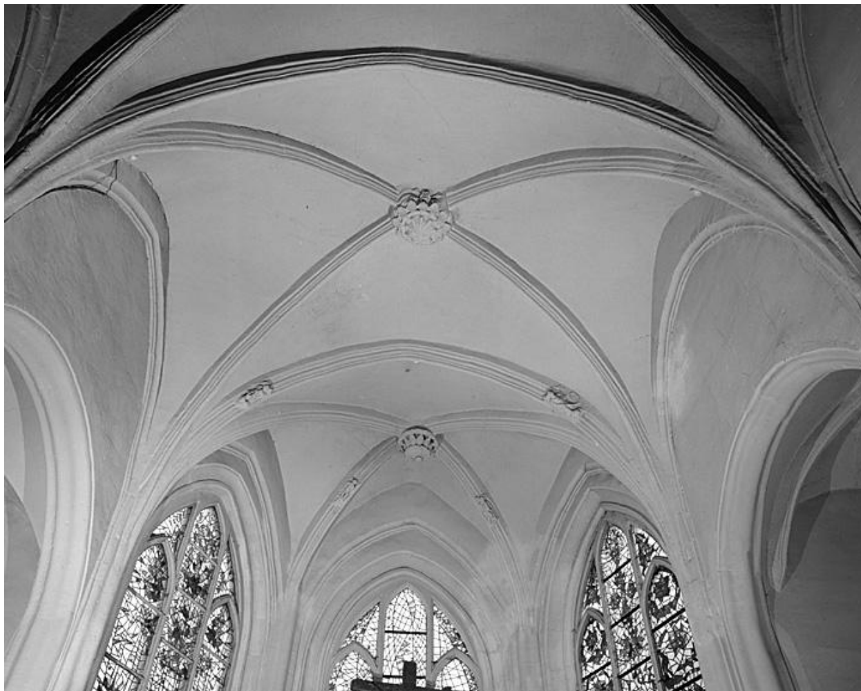
Détail des voûtes du chœur.
