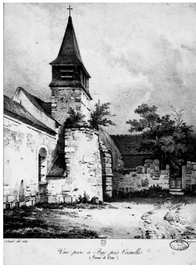
Vue d'ensemble. IVR11_19807800357Z
