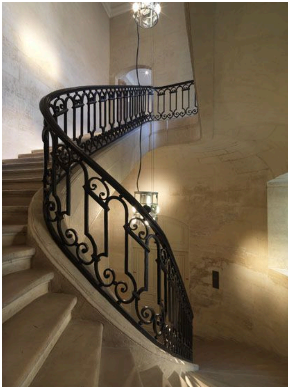
Détail de la rampe dans la partie tournante.
