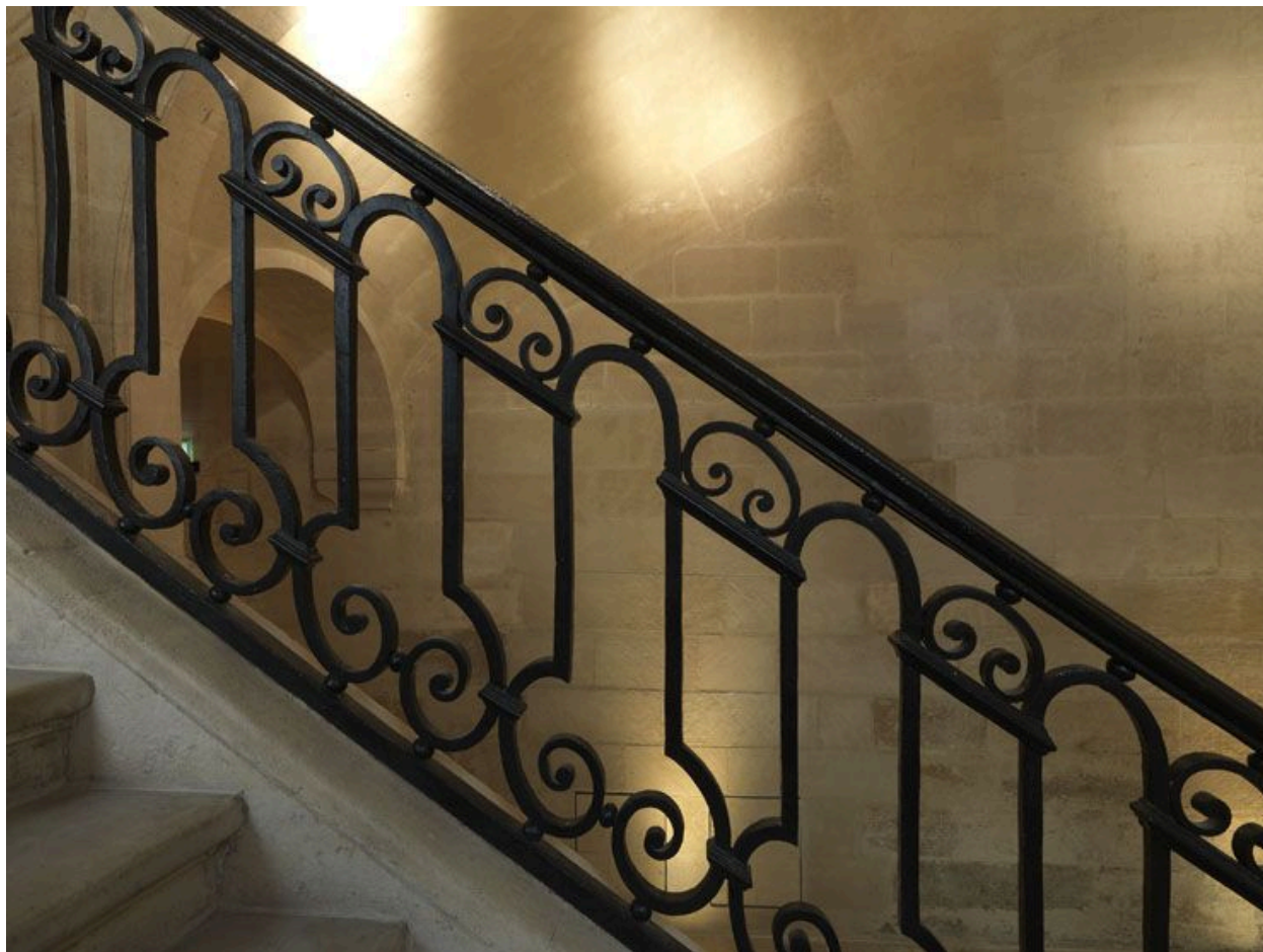
Détail de la rampe dans la partie rampante.
