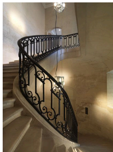
Détail de la rampe dans la partie tournante. Phot. Laurent Kruszyk IVR11_20097500834NUC4A
