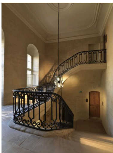
La dernière volée de l'escalier. Phot. Laurent Kruszyk IVR11_20097500836NUC4A
