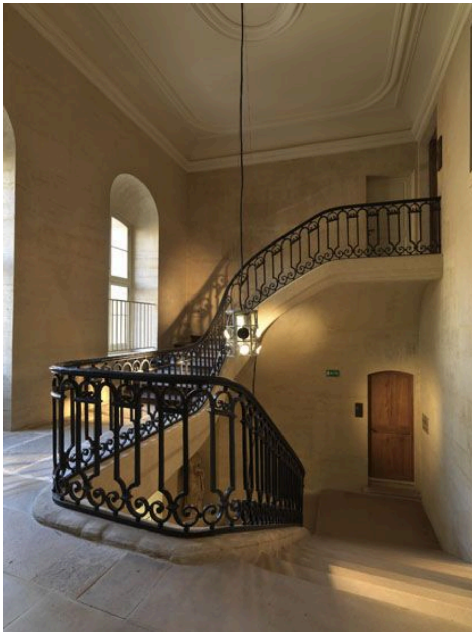
La dernière volée de l'escalier.
