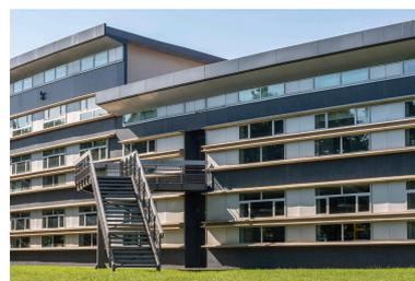
La façade nord joue du contraste entre matité et brillance, grâce à un revêtement de grès cérame vernissé gris foncé qui rompt avec l'acier laqué des trumeaux des fenêtres et les lisses horizontales en aluminium extrudé formant un léger débord.
