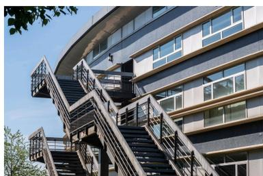
Détail de la façade nord, avec le départ des escaliers de secours. La structure du lycée est en béton armé à murs porteurs, poteaux et poutres, établis sur une trame dont la taille s'adapte à la vocation des locaux : 9 mètres ici au nord
