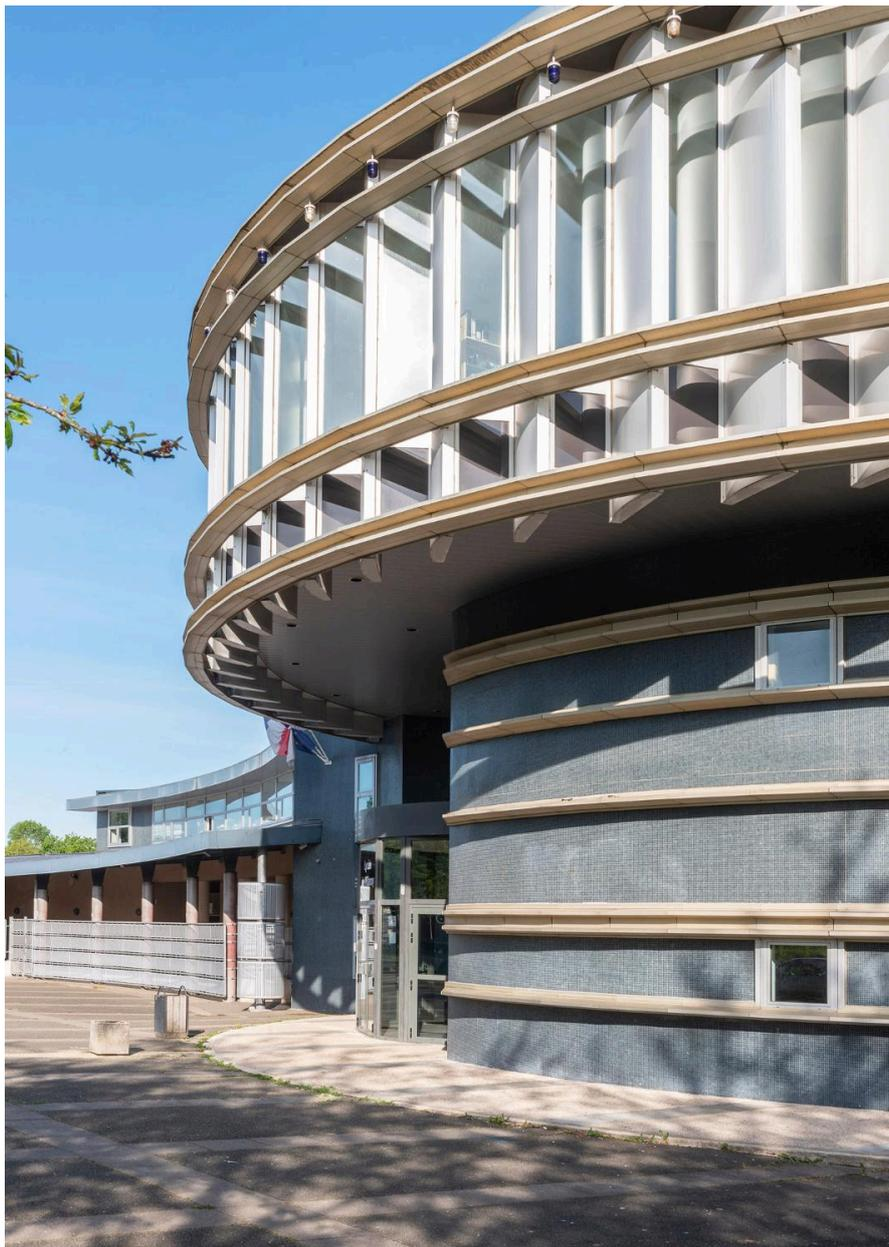
Le CDI circulaire, incarnant l'origine du savoir, présente une alternance d'ailettes verticales en tôle d'aluminium et de bandes vitrées. L'ensemble est cerné par des lisses horizontales en aluminium anodisé de ton champagne (beige doré).
