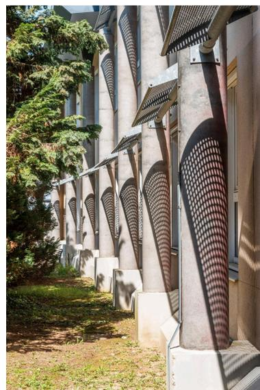
La structure constructive est volontairement apparente sur la façade sud, avec des poteaux de béton lasuré gris qui font écho aux brise-soleil métalliques.
