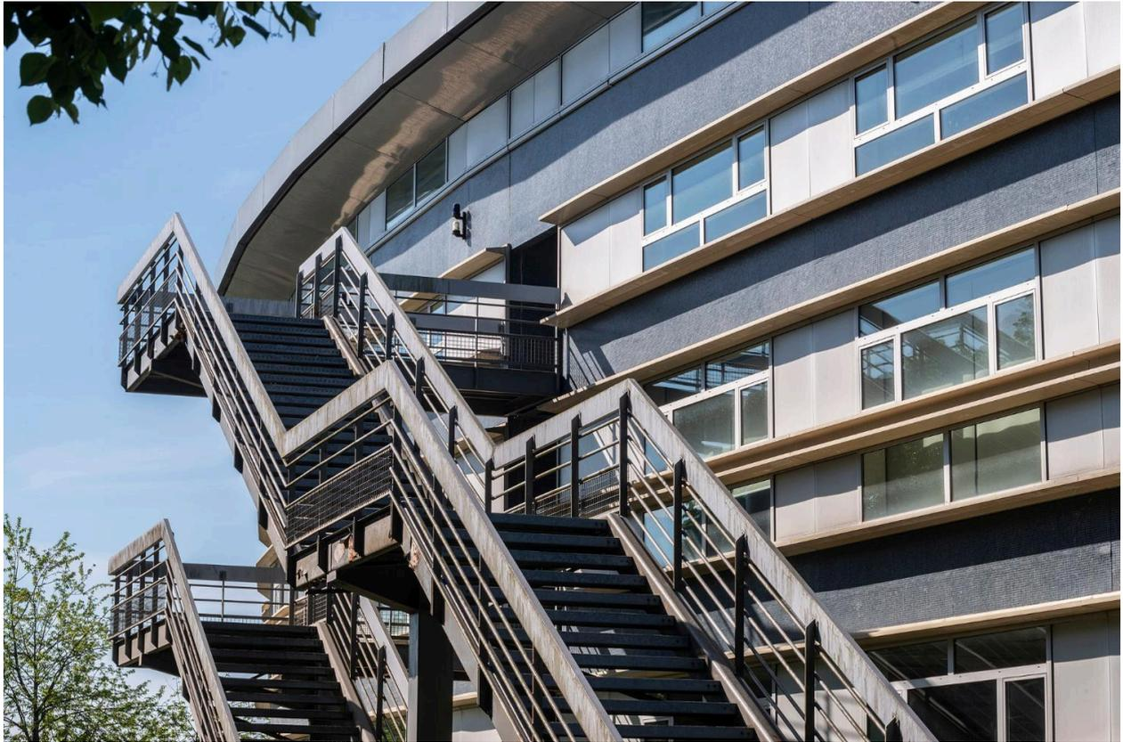
Détail de la façade nord, avec le départ des escaliers de secours. La structure du lycée est en béton armé à murs porteurs, poteaux et poutres, établis sur une trame dont la taille s'adapte à la vocation des locaux : 9 mètres ici au nord pour les salles de classes les plus vastes du pôle technique et tertiaire.
