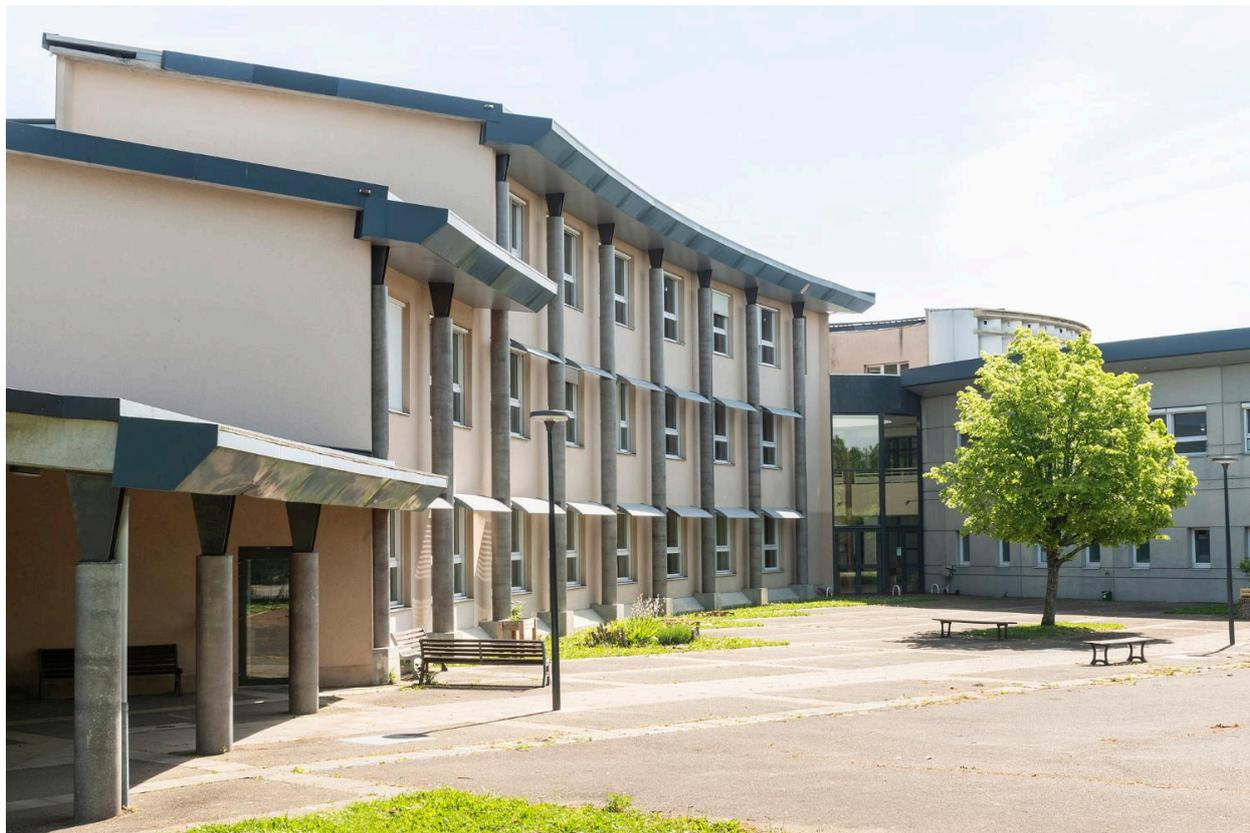
Sur la façade sud, les décrochements de volumes, la pente des toitures et le rythme des pilastres de béton contribuent à faire la transition avec la cour et l'échelle du piéton.
