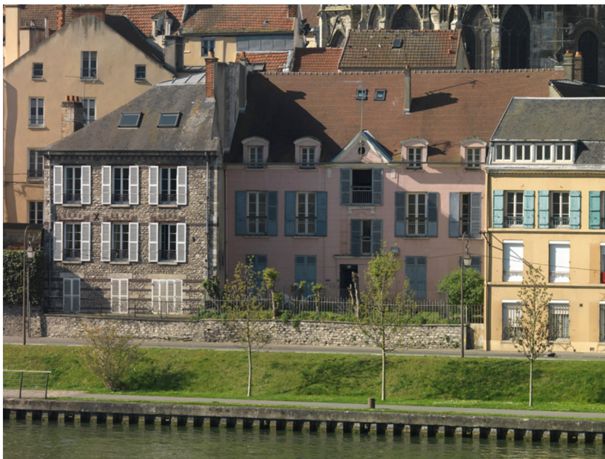
La façade sur Seine de l'hôtel qui a été récemment restauré.
