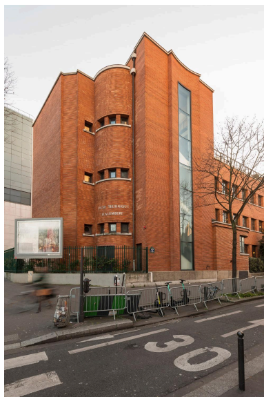
Vue générale du lycée, à l'angle de la sente des Dorées. Phot. Laurent Kruszyk IVR11_20207500210NUC4A
