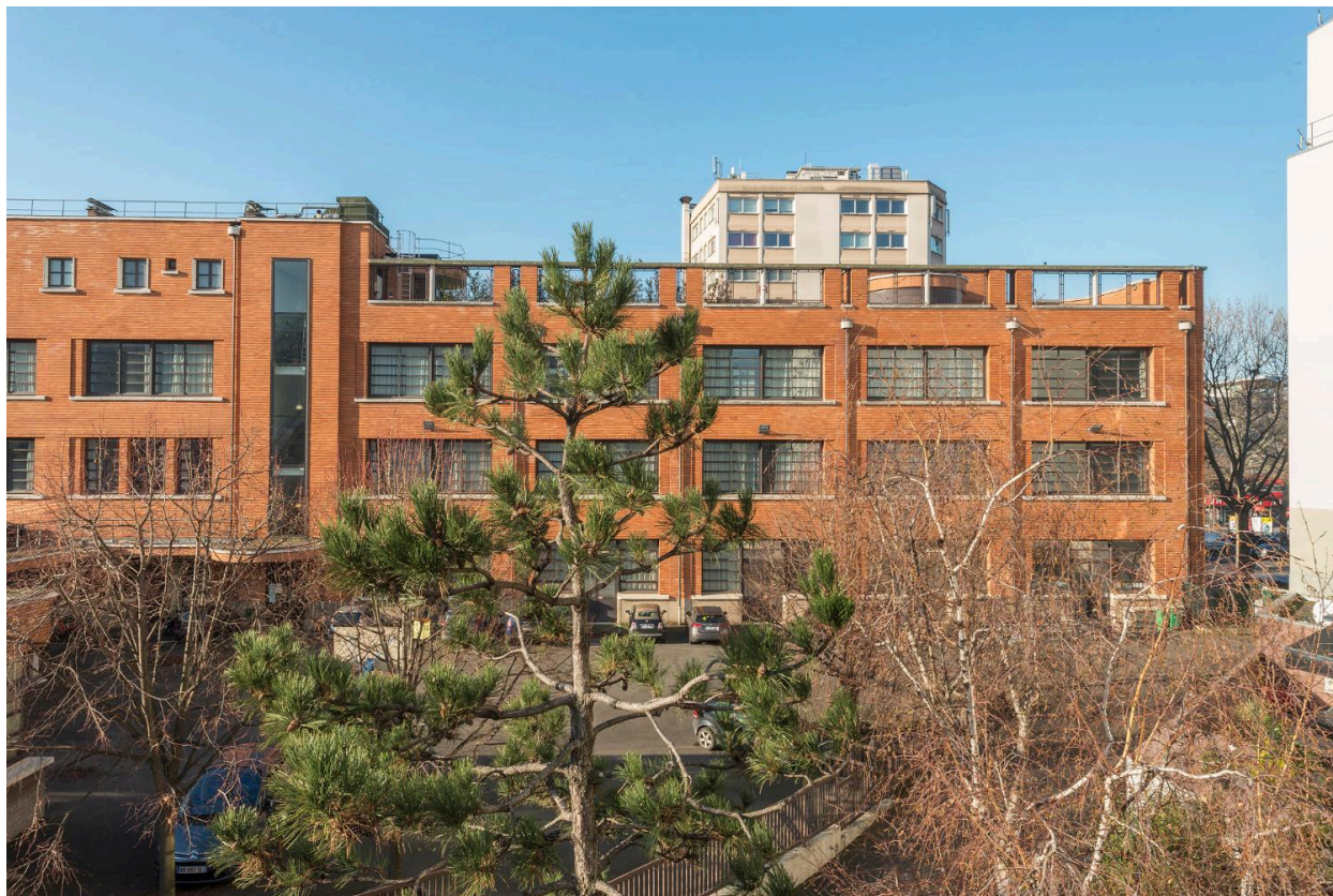
Détail des élévations côté cour.
