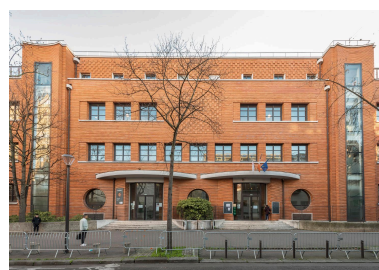
Façade antérieure du lycée, vue de face. Phot. Laurent Kruszyk IVR11_20207500219NUC4A
