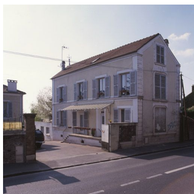
Vue d'ensemble de la maison, 27 boulevard Henri-Barbusse.
