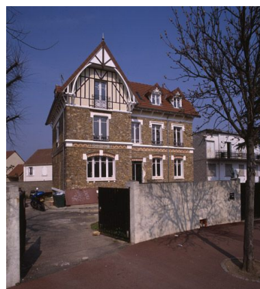
Vue d'ensemble de la maison, 1 place du Docteur- Rouffy. Phot. Philippe IVR11_20079101780XA
