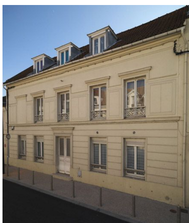
Vue rapprochée de la façade de la maison, 16 rue de Mainville. Phot. Philippe IVR11_20089100177NUC4A
