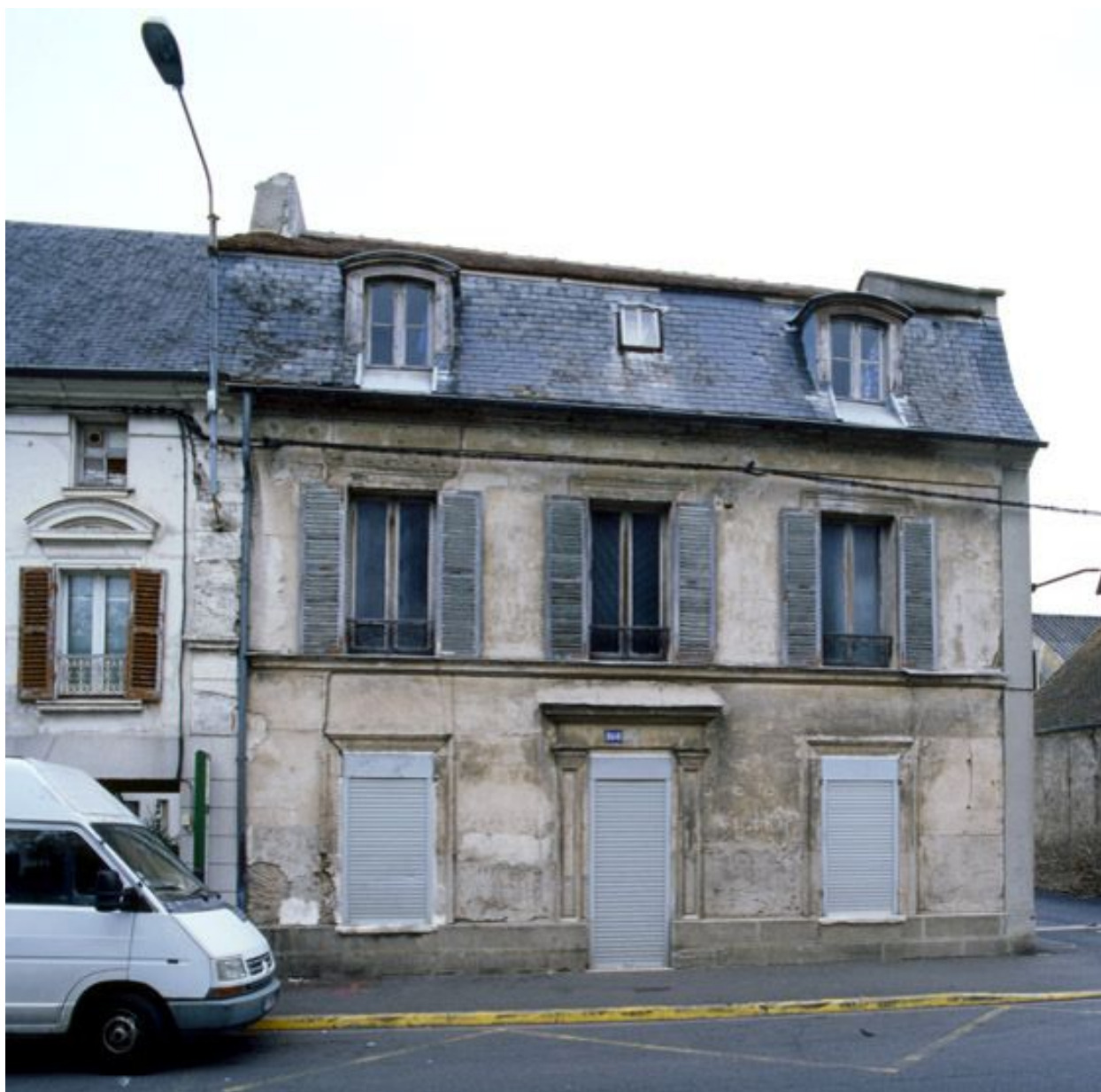
Vue d'ensemble de la maison de ville, 160 boulevard Henri-Barbusse.
