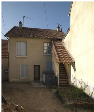
Vue d'ensemble de la maison, avec entrée de cave et escalier extérieur, 21 rue des Creuses.
