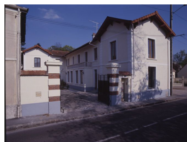
Vue d'ensemble de la maison, 12 boulevard Henri-Barbusse. Phot. Philippe IVR11_20079101754XA
