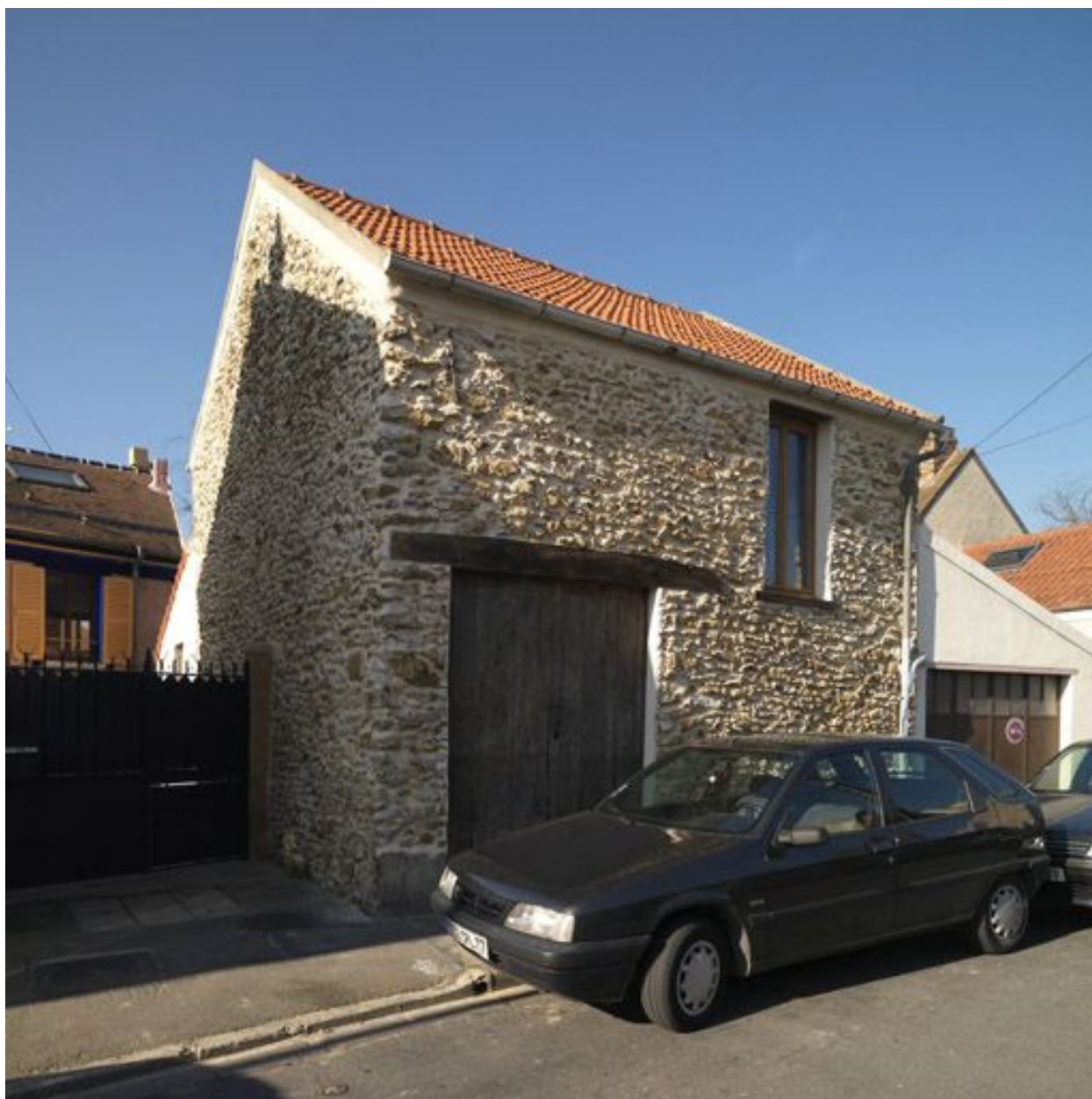
Vue de la grange depuis la rue, 27 rue des Creuses. La pierre que recouvrait un enduit ancien a été mise à nu.
