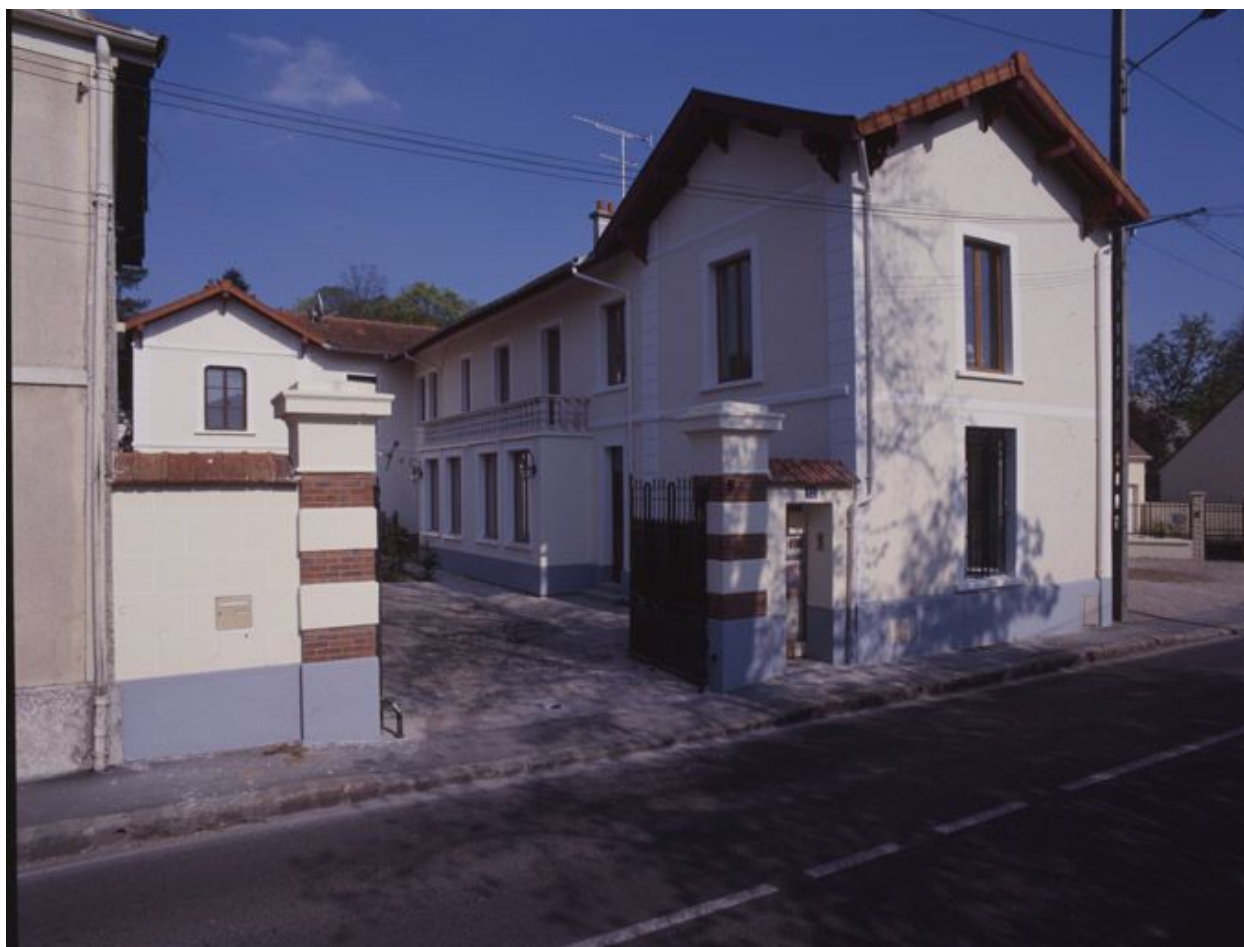
Vue d'ensemble de la maison, 12 boulevard Henri-Barbusse.
