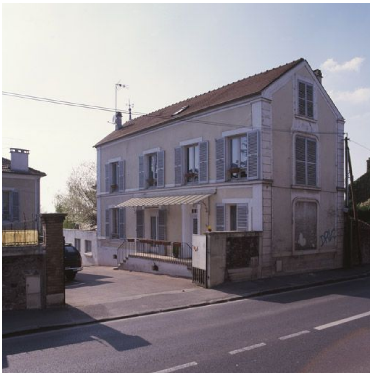
Vue d'ensemble de la maison, 27 boulevard Henri-Barbusse.
