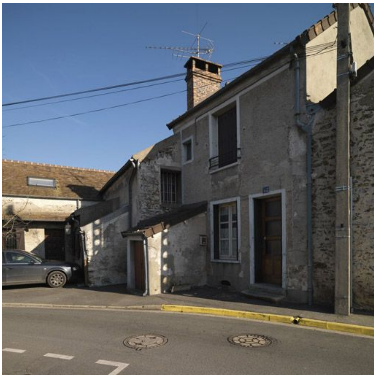
Vue d'ensemble de la maison, 44 rue des Creuses. Comme sa voisine (n° 44), elle présente une entrée de cave sur appendice en saillie.
