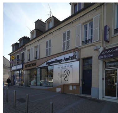
Vue d'ensemble de la maison avec boutique, 28 place de la République. Phot. Philippe IVR11_20089100164NUC4A
