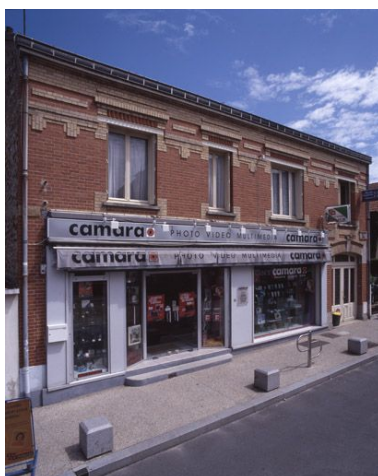
Vue d'ensemble de l'immeuble, 11 rue Jean-Moulin. Phot. Philippe IVR11_20079100814XA
