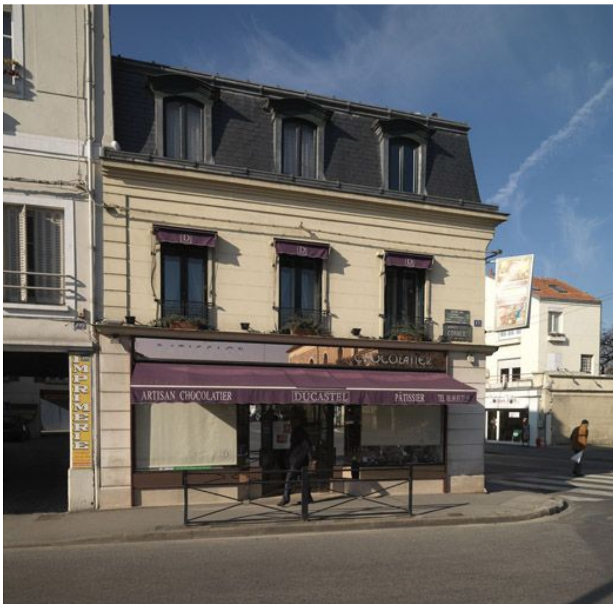
Vue d'ensemble de la maison, 111 boulevard Henri-Barbusse.
