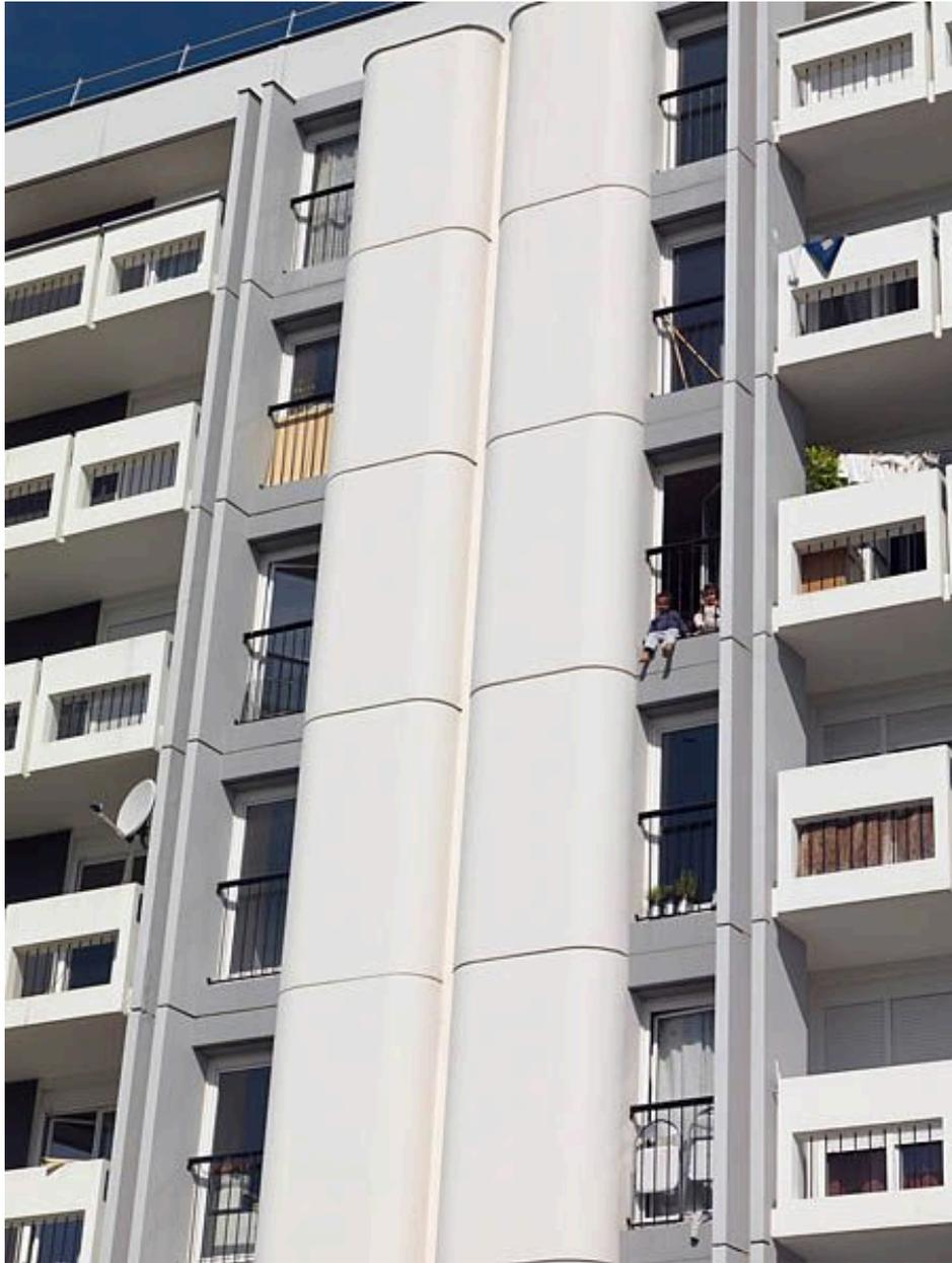
cité dite Résidence Pergaud. Modules préfabriquées de fenêtres simples correspondant aux chambres. Chaque élément de chambre comprend un emplacement de placard dans les alvéoles en façade de 0,70m<sup>2</sup> au sol environ et un encadrement pour porte fenêtre.
