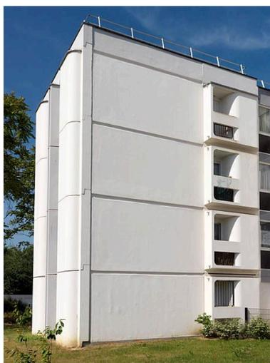
cité dite Résidence Pergaud. Mur pignon. Le système de murs porteurs est constitué selon le principe de refends transversaux en béton banché coulés en coffrages métalliques. Le parement des pignons était en béton banché décoré en stries obtenues par coffrage. Le décor de stries a disparu lors de la rénovation.
