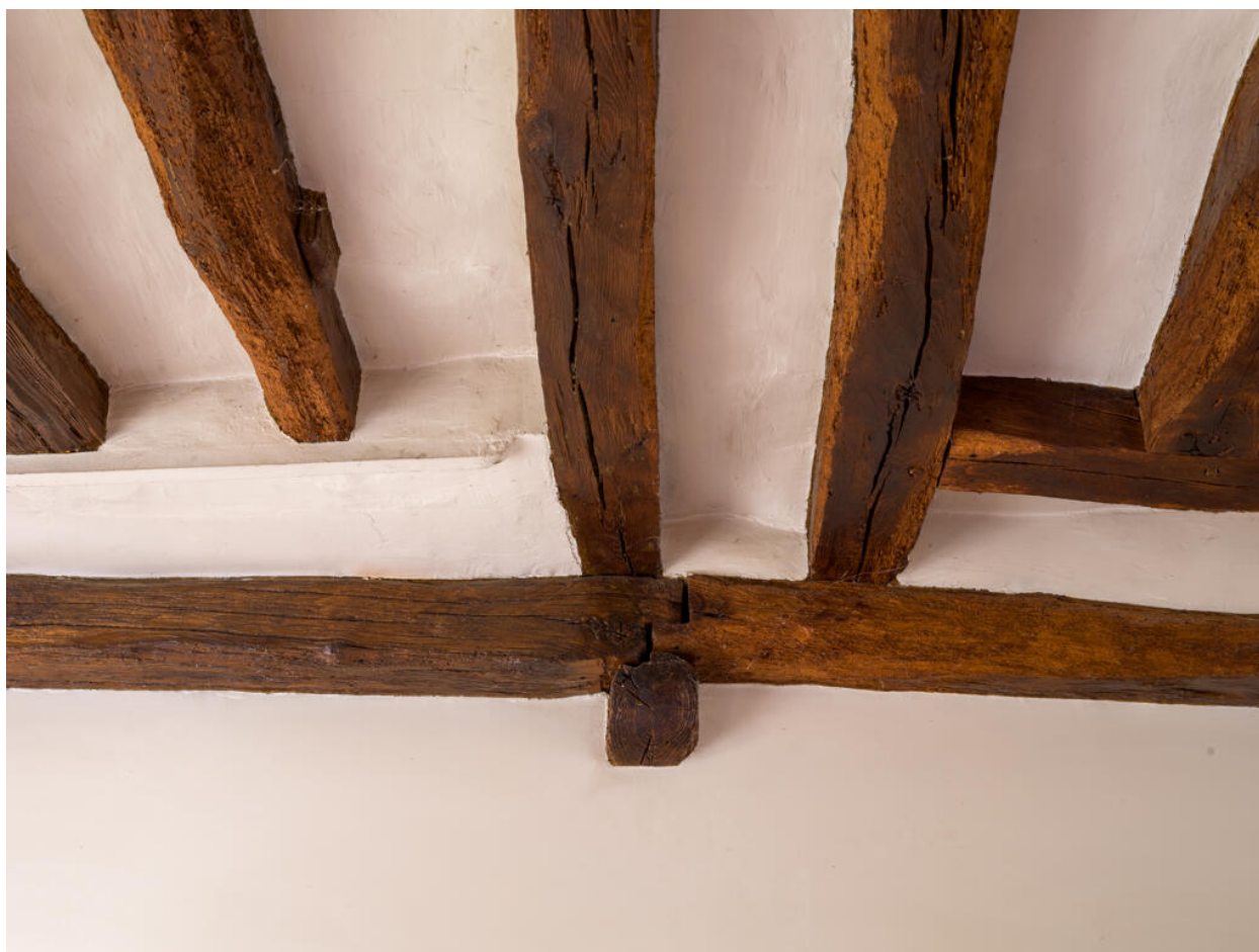
Détail de l'extrémité est du plafond de la salle située au rez-de-chaussée du corps de bâtiment est.
