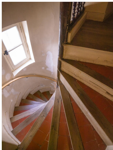
Vue générale de l'escalier en vis. Phot. Asseline Stéphane IVR11_20259100985NUC4A
