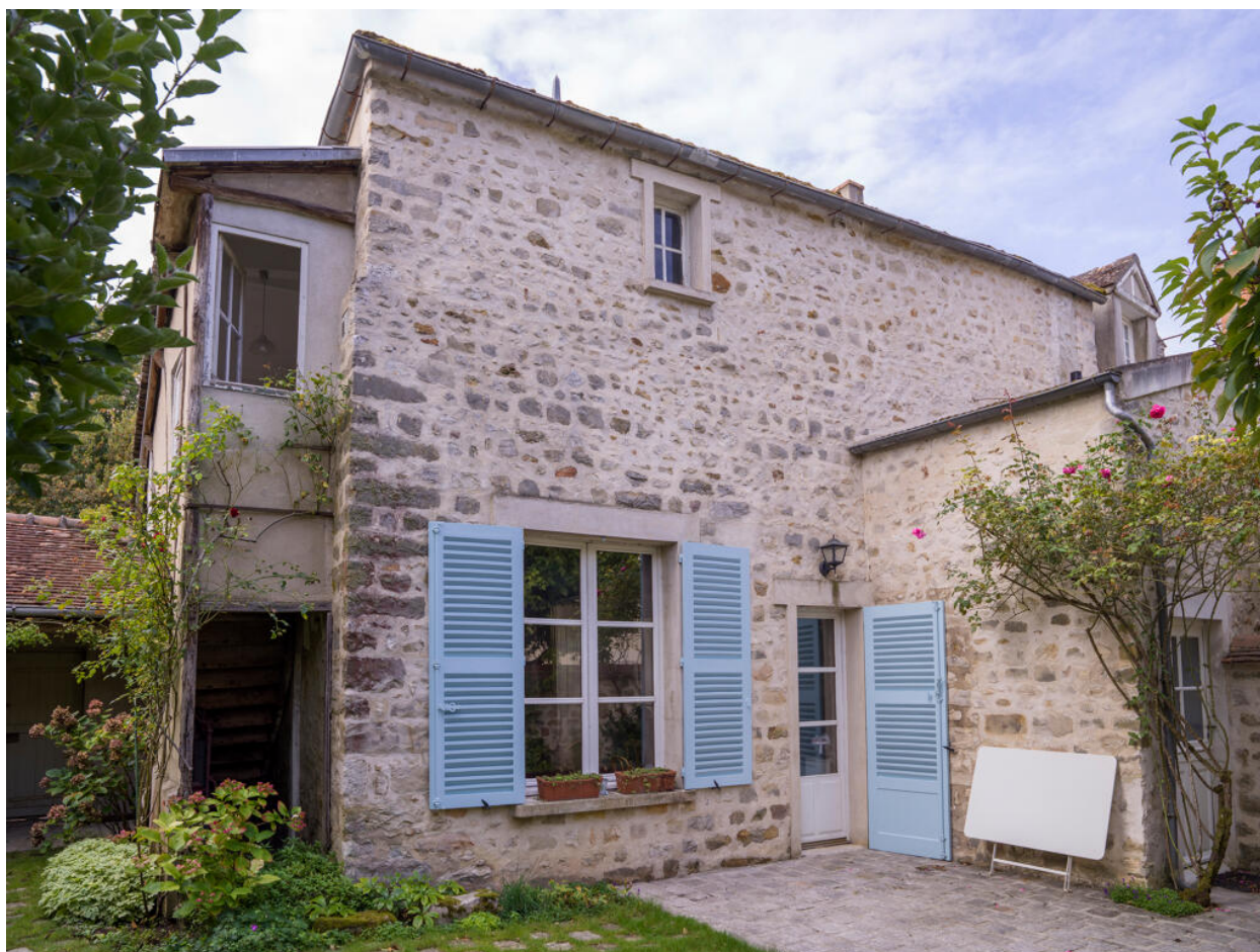
Vue générale des façades sur jardin.
