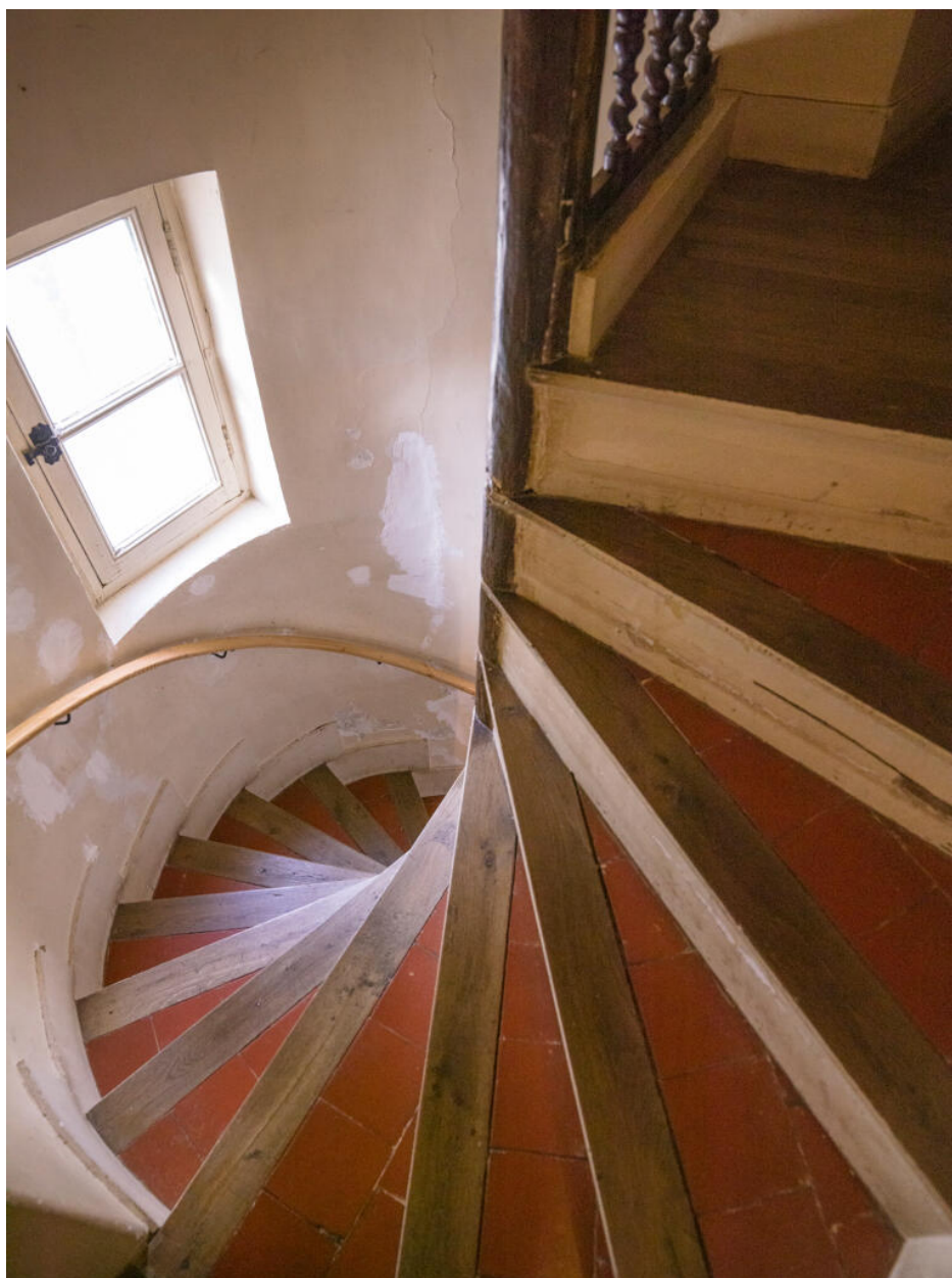
Vue générale de l'escalier en vis.
