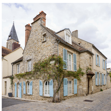
Vue générale de la maison à l'angle de la rue Notre-Dame et de la rue du Lau, depuis le sud-ouest. Phot. Asseline Stéphane IVR11_20259100963NUC4A
