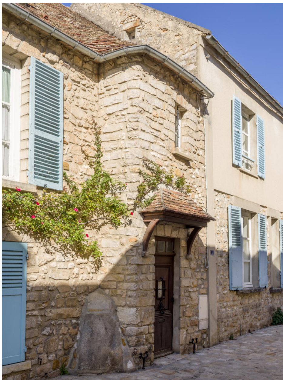
Détail de la façade sur la rue du Lau montrant en saillie du nu du mur une ancienne tour à demi hors oeuvre abritant l'escalier en vis. Vue depuis le sud-ouest.
