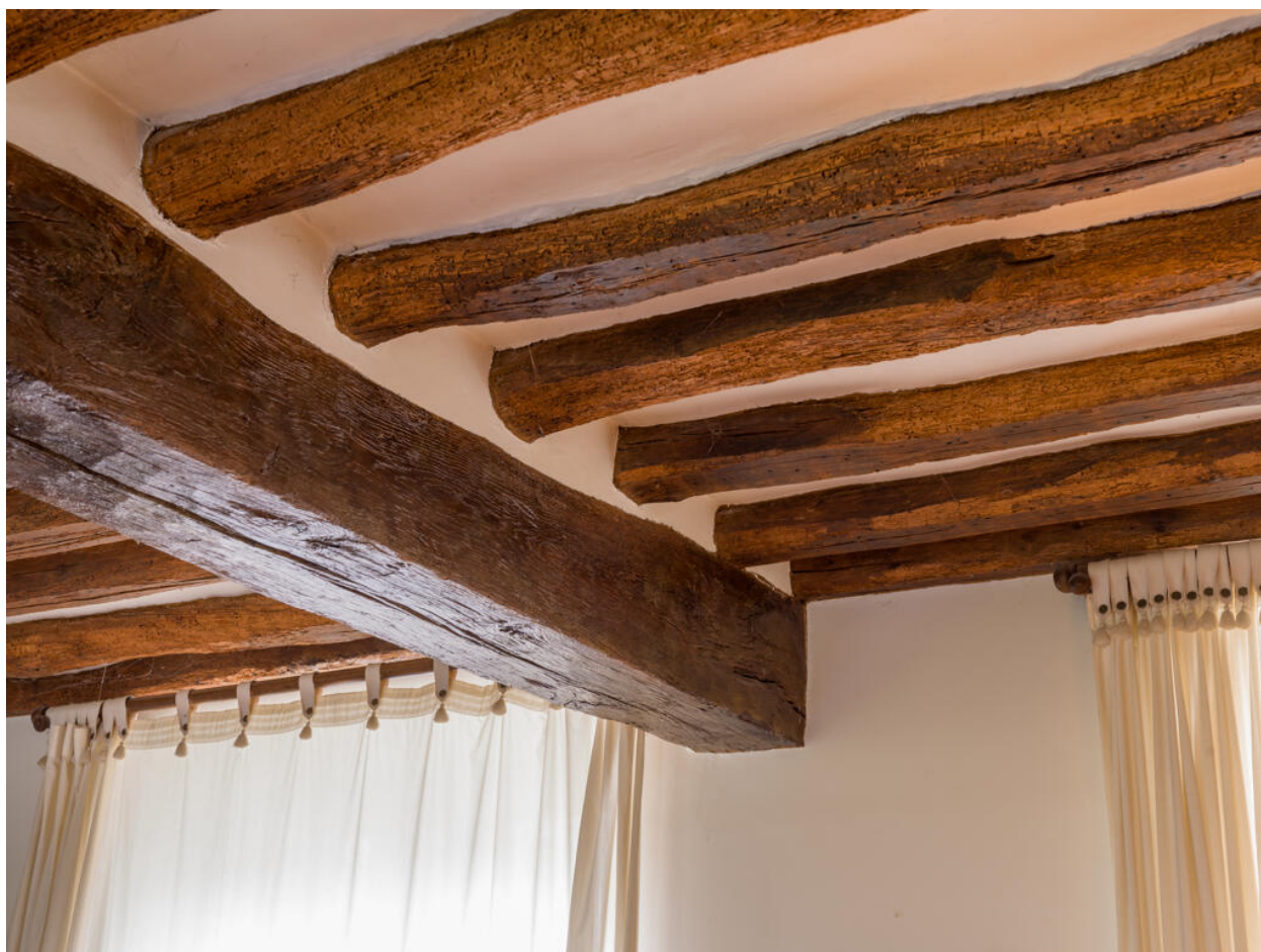
Détail du plafond de la salle située au rez-de-chaussée du corps de bâtiment est.
