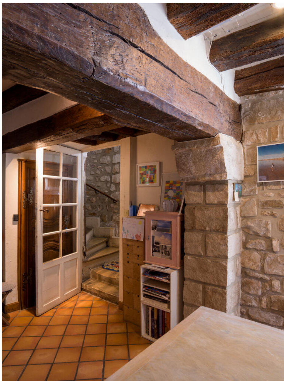
Vue de la pièce située au rez-de-chaussée du corps de bâtiment ouest, depuis le nord-ouest.
