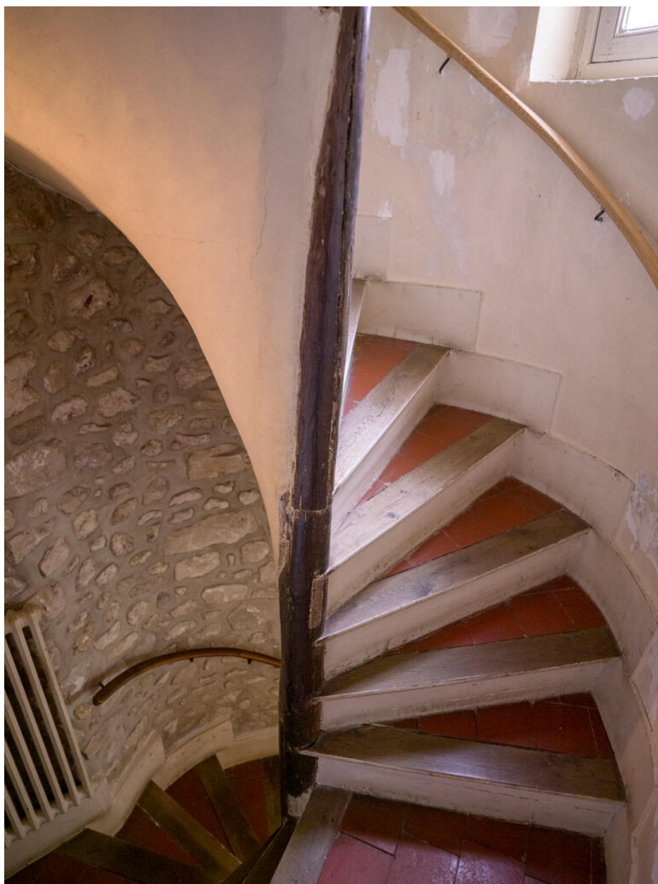
Vue générale de l'escalier en vis.
